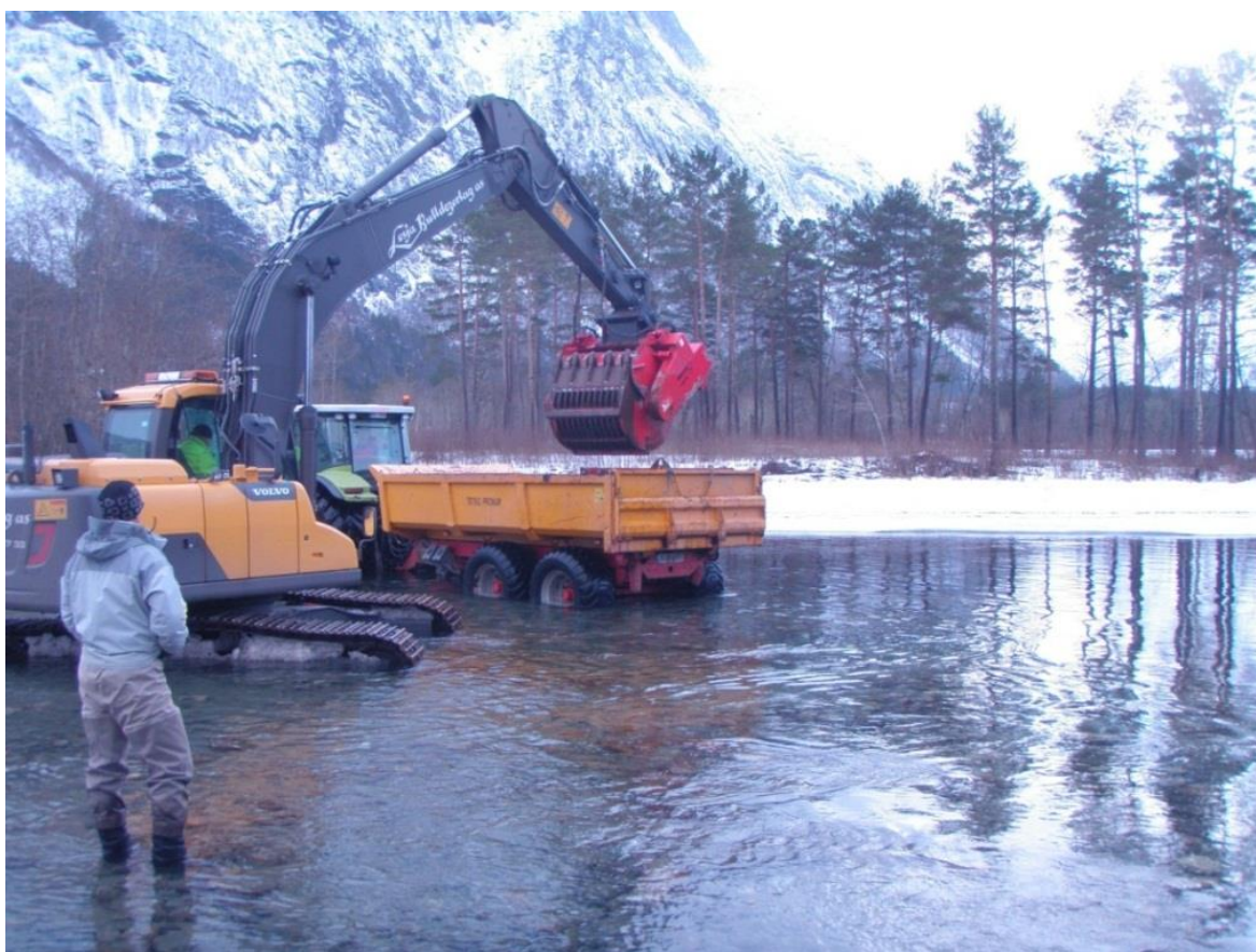
Bilde 12. I mars 2013 ble det benyttet beltegraver med sorteringsskuffe for å fjerne finsedimenter fra elvebunnen i to områder av Eira. Foto: Nils Arne Hvidsten.
