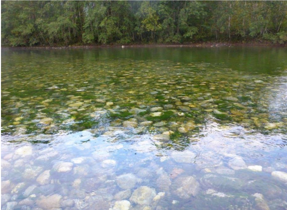
Bilde 13. Tiltaksområde i Eira i Møre og Romsdal der grovt substrat i elvbunnen ble utsortert med bruk av beltegraver med sorteringsskuffe. Det er et tydelig skille mellom behandlet (lyst område) og ubehandlet elvbunn (mørkt område). Foto: Jan Gunnar Jensås.
