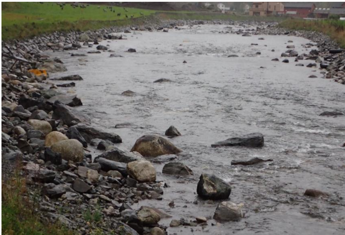
Bilde 6. Eksempel på en tilbaketrukket elveforbygning (høyre side av elva). Hovedforskjellen fra en tradisjonell utformet elveforbygning er at det er bevart en strandsone med naturlig substrat. Bildet er hentet med tillatelse fra Pulg mfl. (2018).
