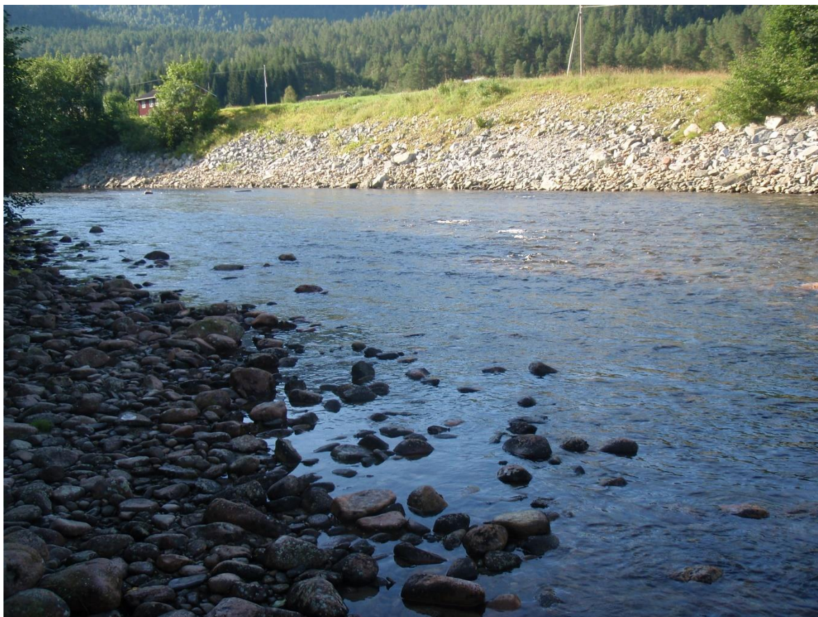
Bilde 5. Eksempel på en tradisjonelt utformet elveforbygning fra Toåa i Surnadal. All naturlig kantskog er fjernet på elvebredden, og de naturlige elvemassene er erstattet med sprengtstein. Foto: Gunnbjørn Bremset.
