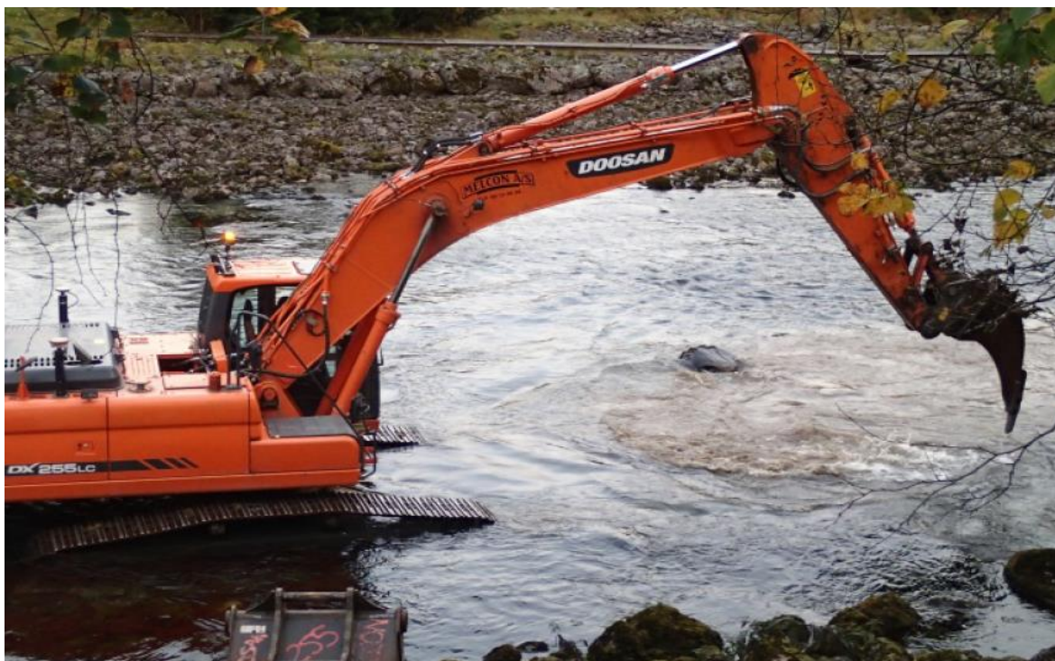
Bilde 11. Ripping ved bruk av gravemaskin og skuff med stålpiigg (teleripper) i Aurlandselva. Bildet er hentet med tillatelse fra Pulg mfl. (2018).
