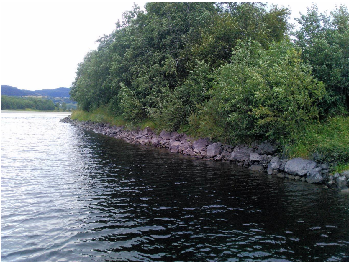
Bilde 2. Elveforbygninger er blant de mest betydelige vassdragsinngrepene i nedre deler av Gaula. Denne forbygningen ligger på elvehøyre side om lag 700 meter oppstrøms Kvålsbrua i Melhus. Foto: Gunnbjørn Bremset.
