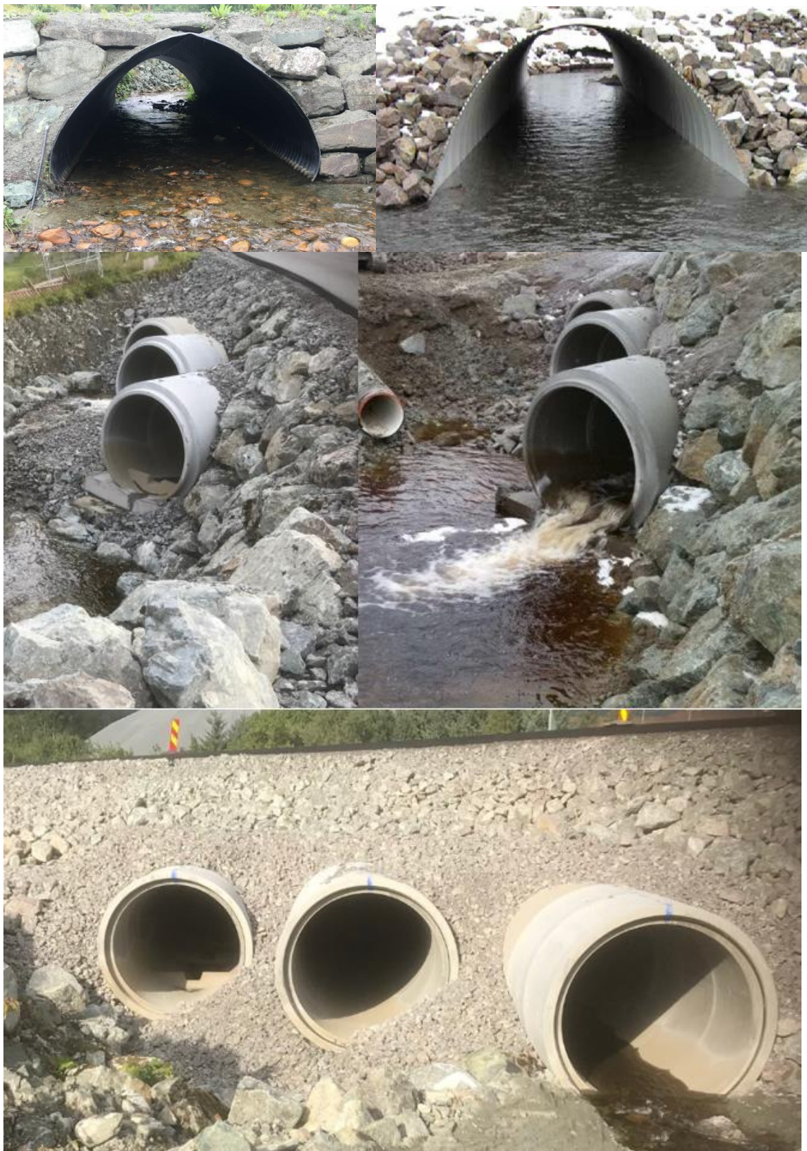
Bildeserie 16. Illustrasjonsfoto av kulverter med optimal utforming (de to øverste bildene), og kulverter som åpenbart vil hindre fiskepassasje (de tre nederste bildene). Den tekniske løsningen som er benyttet i Loa ved Ler (øverste venstre bilde) er basert på best tilgjengelig kunnskap, og kan være en modell for framtidige tiltak i Gaulavassdraget. Foto: Morten André Bergan.
