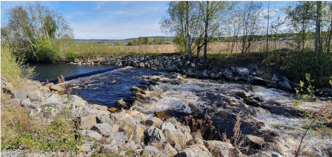
Bilde av terskelen ved Flagstadmyrene tatt under befaring den 13.05.2020
