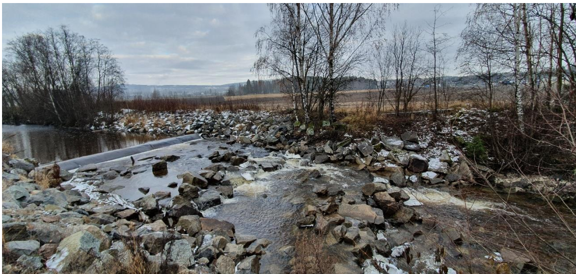
Bilde av terskelen ved Flagstadmyrene tatt under befaring den 14.11.2019
