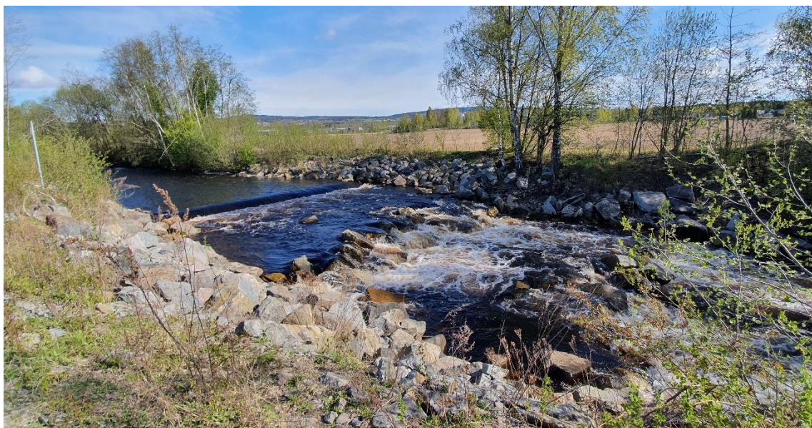
Figur 5. Terskelen ved Flagstadmyrene den 13.05.2020. På bildet sees bassenget oppstrøms og kulpen umiddelbart nedstrøms terskelen i tillegg til starten på strykpartiet før elva går over i en roligere glattstrøm (utenfor bildet).
