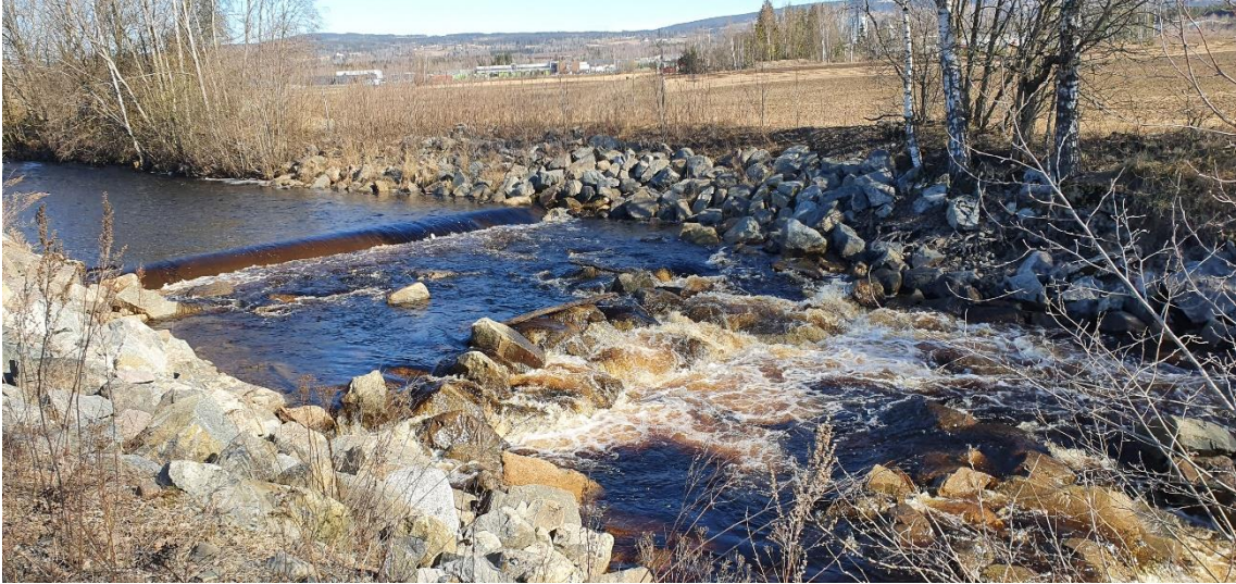
Bilde av terskelen ved Flagstadmyrene tatt under befaring den 15.05.2020
