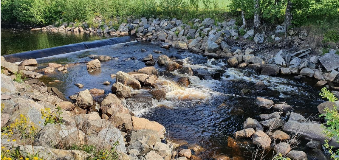
Bilde av terskelen ved Flagstadmyrene tatt under befaring den 03.06.2020
