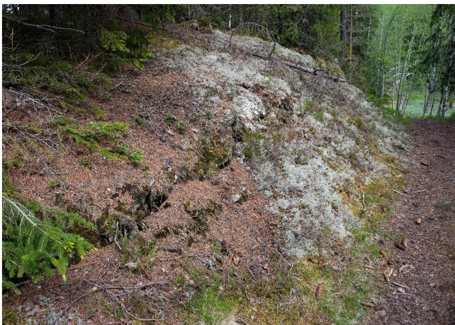
Figur 3.12. Veiskulderen i vest for traktorveien som går langs med dam 1 og 2 ned til Vesle Ossjøen. Her er det sprekker i grus og steinlaget med røtter som er egnet som overvintringsplass og dagskjul for småsalamanderne. Foto: Børre K. Dervo ©.
