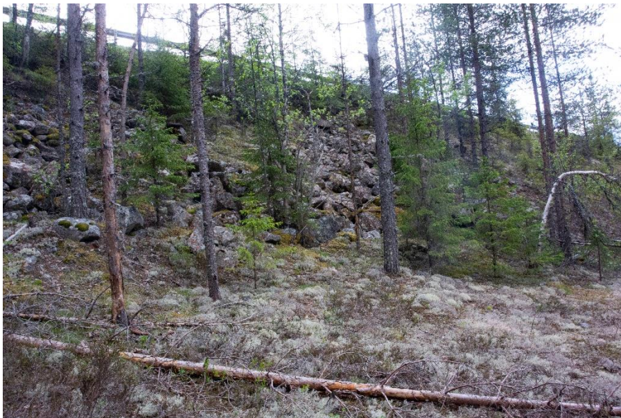
Figur 3.11. Veifyllingen ved Trysilvegen sør for dam 2 med steinstrukturer som er egnet som overvintringsplass for småsalamanderne. Foto: Børre K. Dervo ©.
