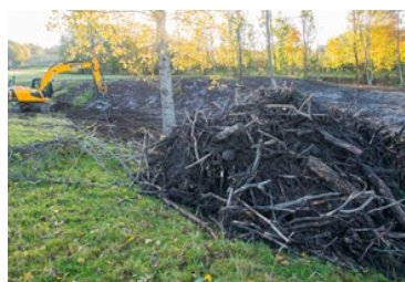
Bilde 7.4. Restaurering av landarealene øst for dammen.
