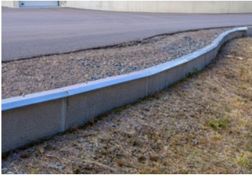
Bilde 9.23. Fastmontert ledegjerde av betong med stålplate på toppen som overheng, Holumskogen Nittedal.
