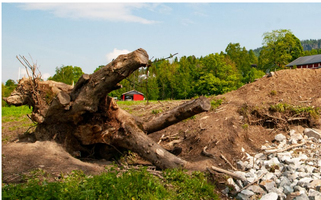
Bilde 5.12. Miljødesign av kunstige overvintringsplasser. Til venstre i bildet er det bygging av kunstige jordhuler under ei stor tre-rot. Til høyre i bildet er det bygging av et hotell av grov pukke (5-30 cm) som etterligner ei steinrøys med hulrom for overvintring.
