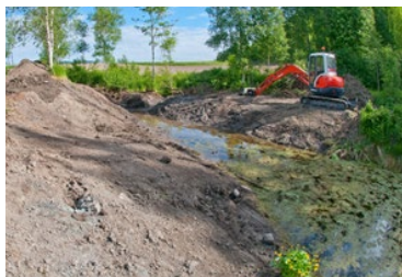
Bilde 7.18. Restaurering av dreneringsgrøft inn i dammen på Skaugen i Lier i 2009.
