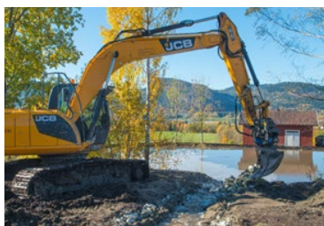
Bilde 7.9. Bekken ble lagt om inn i dammen for å sikre god vanntilførsel.
