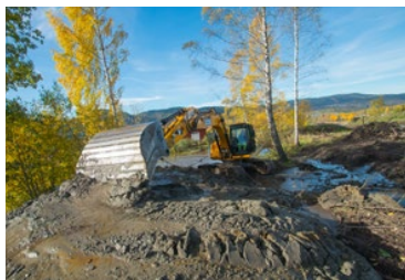
Bilde 7.7. Noe av bunnsedimentene ble deponert på damkanten.
