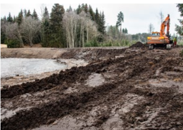
Bilde 8.3. Bilde tatt 28.02.2020 hvor det var flyttet på rundt 15 000 m 3 med masse.
