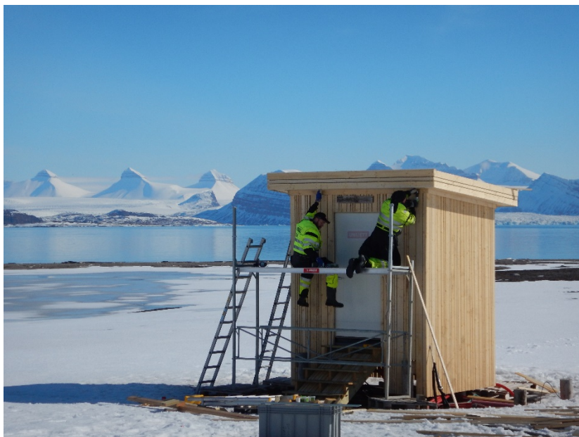
Figur 3.1. Ny kledning ble lagt på fiberbodene i mai 2018. Foto: Frode Koppang/Kartverket
