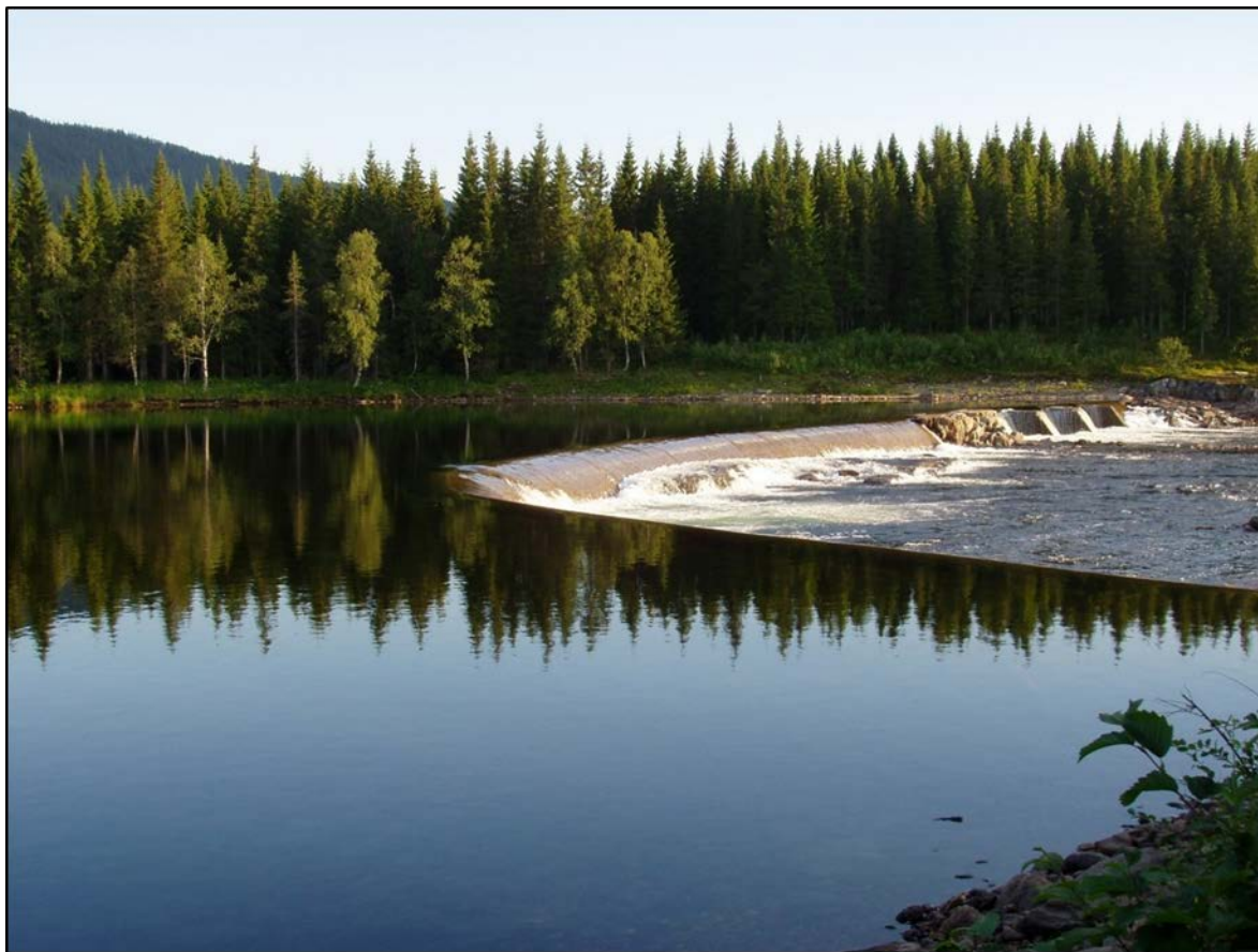
Bilde 13. Det er etablert fem terskler for å opprettholde vannspeil i øvre deler av Namsenvassdraget. Terskelen ved Kjelmfossen har såkalt Syvde-utforming. Foto: Eva Bonsak Thorstad, NINA
