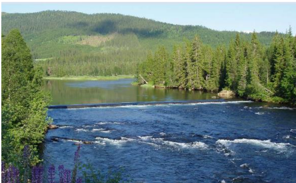
Bilde 16. Vannhastighetene oppstrøms kunstige terskler reduseres vesentlig sammenlignet med naturtilstanden, slik som illustrert ved forskjeller i vannhastigheter oppstrøms og nedstrøms terskelen ved Namsskogan sentrum. Foto: Eva Bonsak Thorstad, NINA.
