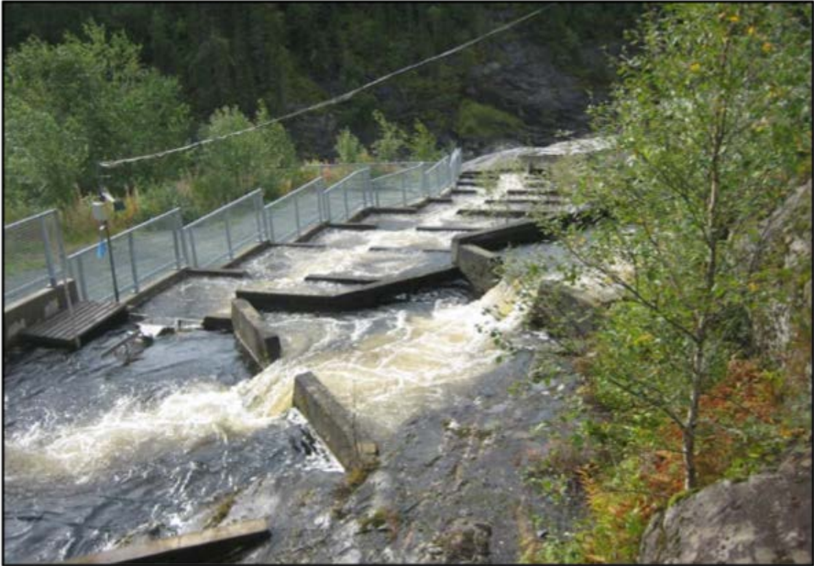
Bilde 14. Laksetrappa i Nedre Fiskumfoss gir sjøvandrende laksefisk tilgang til områder som tidligere bare hadde småblank og stasjonær aure. Foto: Svein Williksen.
