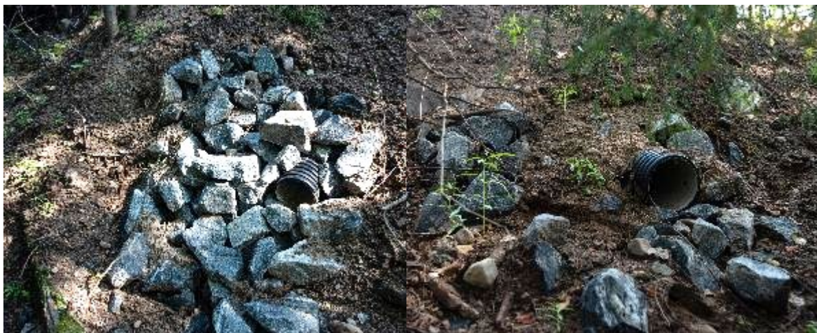
Figur 4.5. Inngangen til de to salamanderhotellene ved «butikktoalet» ved tjernet på Arsenalet. Det er inngang både gjennom steinmassene som stikker helt ut i fronten og dreneringsrørene som går inn i hotellet. Dreneringsrørene er perforert med hull på 16 mm for hver 30 cm langs hele røret. Foto: Børre K. Dervo, NINA ©.
