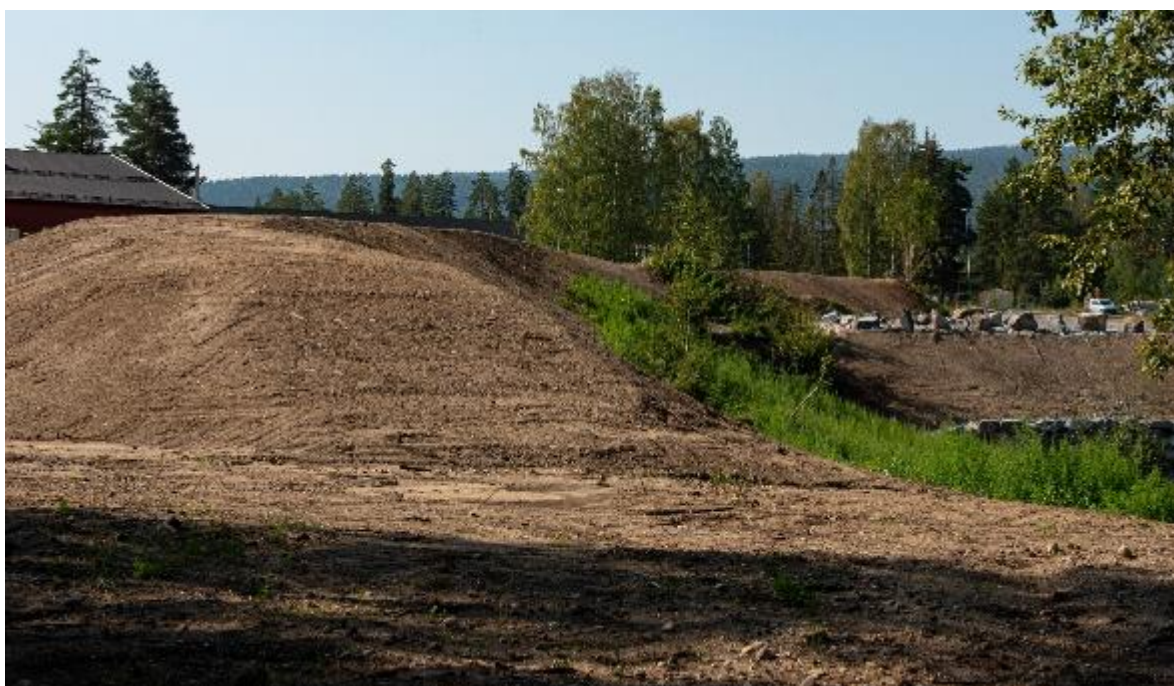
Figur 4.14. Bilde av vollen i sør mot tjernet på Arsenalet 27. august 2019. Skråningen har en helning på i underkant av 30 grader på det bratteste og vil fungere som en barriere for salamanderne mot industriarealene. Arealene her skal vegeteres naturlig over tid. Foto: Børre K. Dervo, NINA ©.
