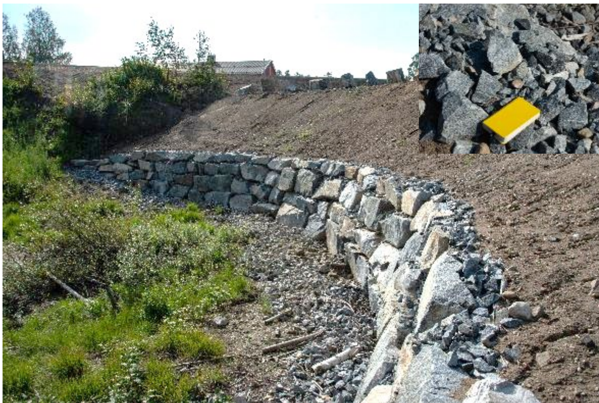
Figur 4.4. Støttemuren ved fyllingsfronten på Arsenalet laget som et stort salamanderhotell. Tørrmuren i fronten er stablet for å lage godt med hulrom som gir lett tilgang til de bakenforliggende grove steinmassene. Bilde opp til høyre viser de usorterte og vaska massene som ligger bak støttemuren (lengde på gulboka er 19 cm). Over steinmassene er det lagt en veiduk for å hindre at jord trenger inn. Foto: Børre K. Dervo, NINA ©.
