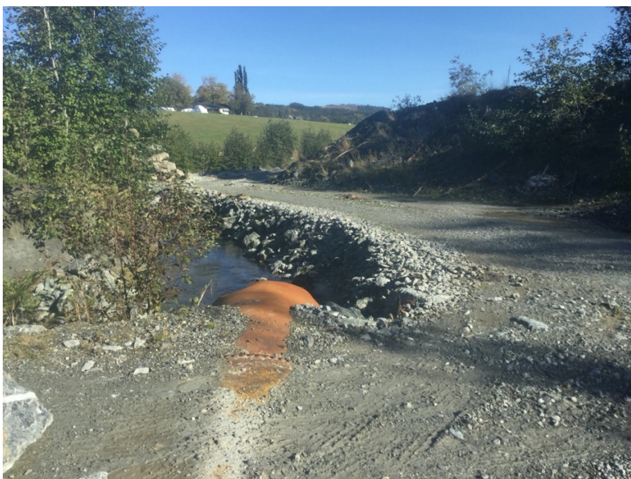
Figur 3.4.11. Det er ikke lagt ferdig fylling oppover høyre sideløp av Hovbekken. Steril fylling vises tydelig. Foto: Gunnar Kristiansen, Natur og Samfunn AS.
