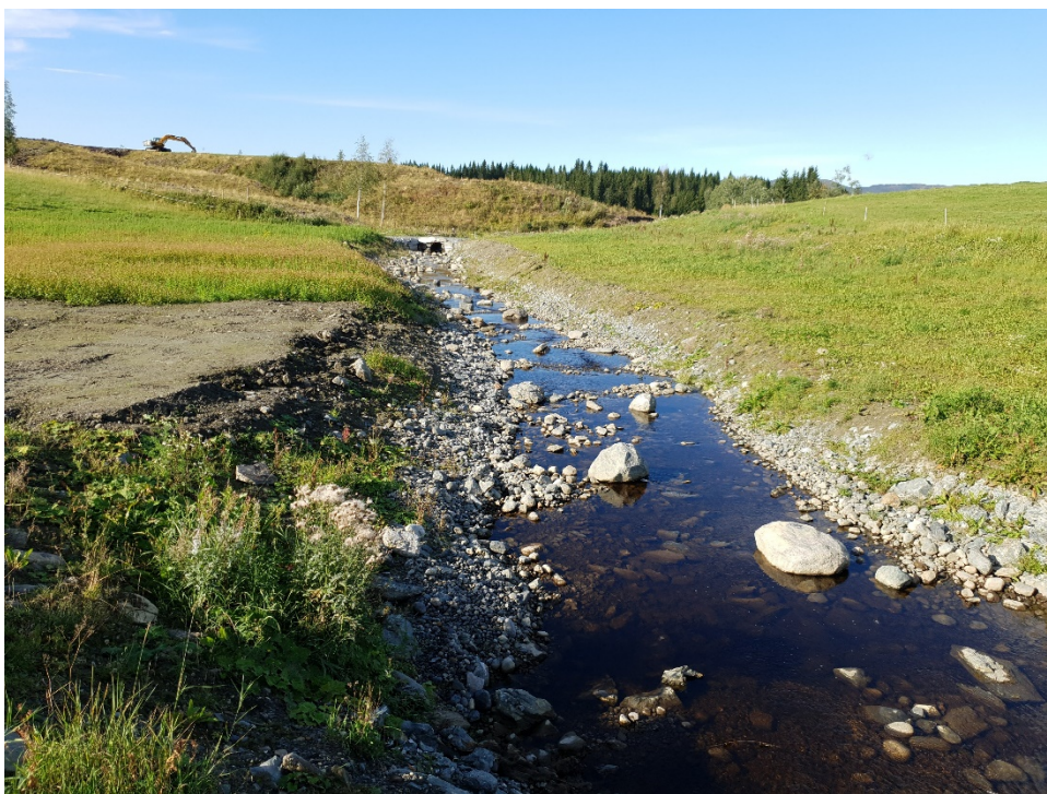
Figur 3.3.13. Sikringsarbeid utført ved dyrket mark. Parti fra Råelva, september 2019. Foto: Bård G. Stokke, NINA
