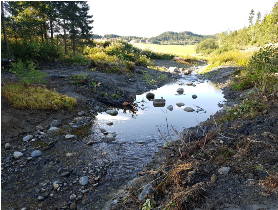
Figur 3.3.12. Matter med vegetasjon plasseres i bearbeidet areal. Parti fra Lundbekken, september 2019. Foto: Bård G. Stokke, NINA
