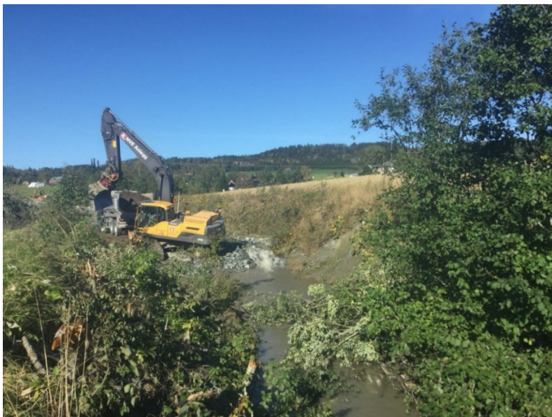
Figur 3.4.19. Bunnsikring, heving av bunn og plastring av sidene. Foto: Gunnar Kristiansen, Natur og Samfunn AS.
