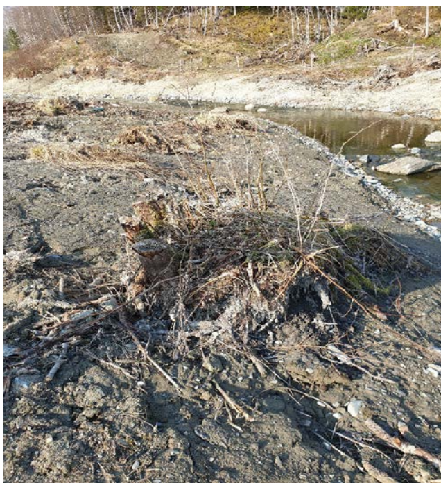
Figur 3.3.10. I slutfasen av sikringsarbeidet legges det vekt på å plassere trerøtter i berørte arealer for å fremme gjenvekst. Parti fra Lundbekken, april 2019. Foto: Bård G. Stokke, NINA
