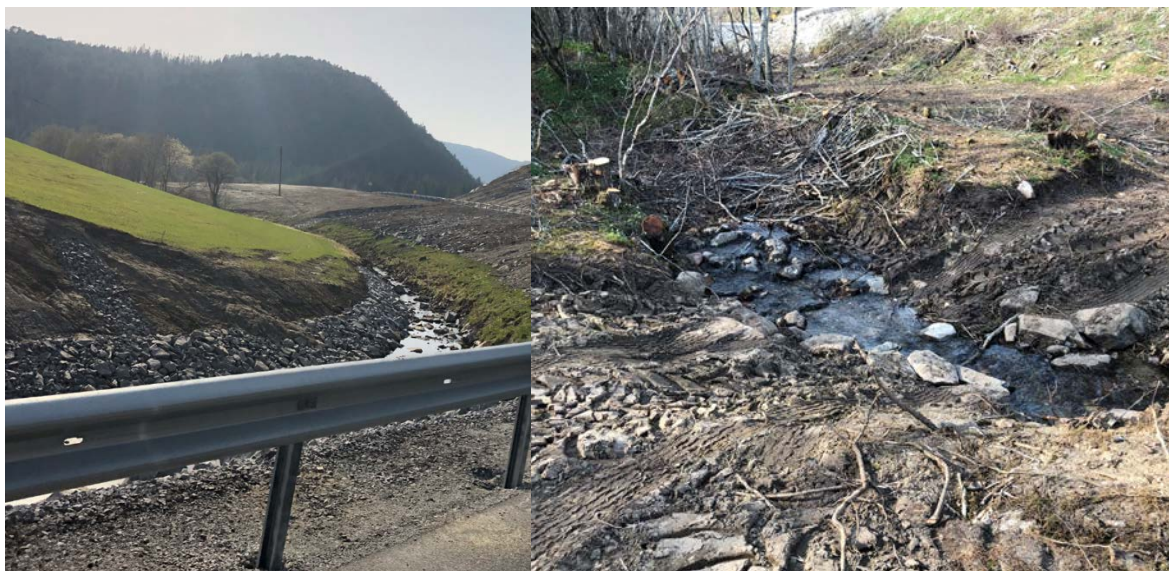
Figur 31. Arbeid med ny Fv 715 (t.v.) og privat arbeid i og ved Skauvåsbekken (t.h.) har satt stort press på vassdragets nøkkelområder for sjøørret og laks. Foto: NINA.
