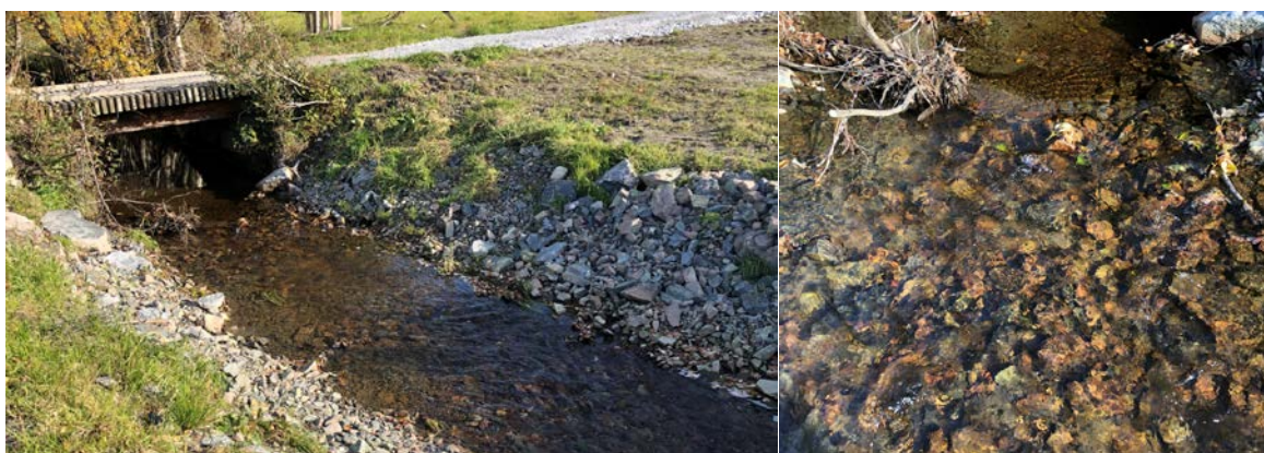
Figur 35. Nedre del av Skauvåsbekken går i en landbruksutrettet kanal, dominert av unaturlig skuttstein, eller finere substrat (sand, mudder).
