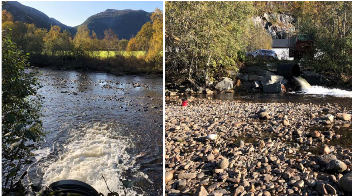
Figur 42. Kraftverksutløpet i Skipelva. Foto: NINA
