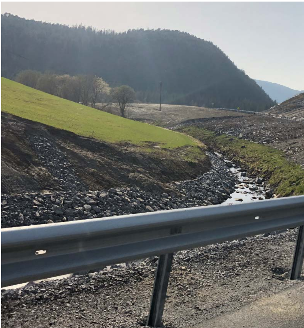
Figur 7. Endret bekkeløp i Skautjønnbekken etter veiarbeid med ny Fv 715. Bratt gradient ned langs bekken, uten kantvegetasjon eller buffersone, gir økt avrenning fra landbruksområder og veien. Foto fra april 2019. Foto: NINA.
