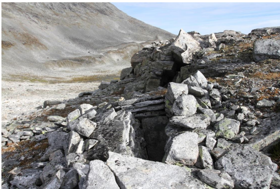
Figur 70. Fangstgrop nr 6 i skråningen mot øst er relativt «intakt» og den eneste som er murt under bakkenivå. Bildet er tatt mot nord.
