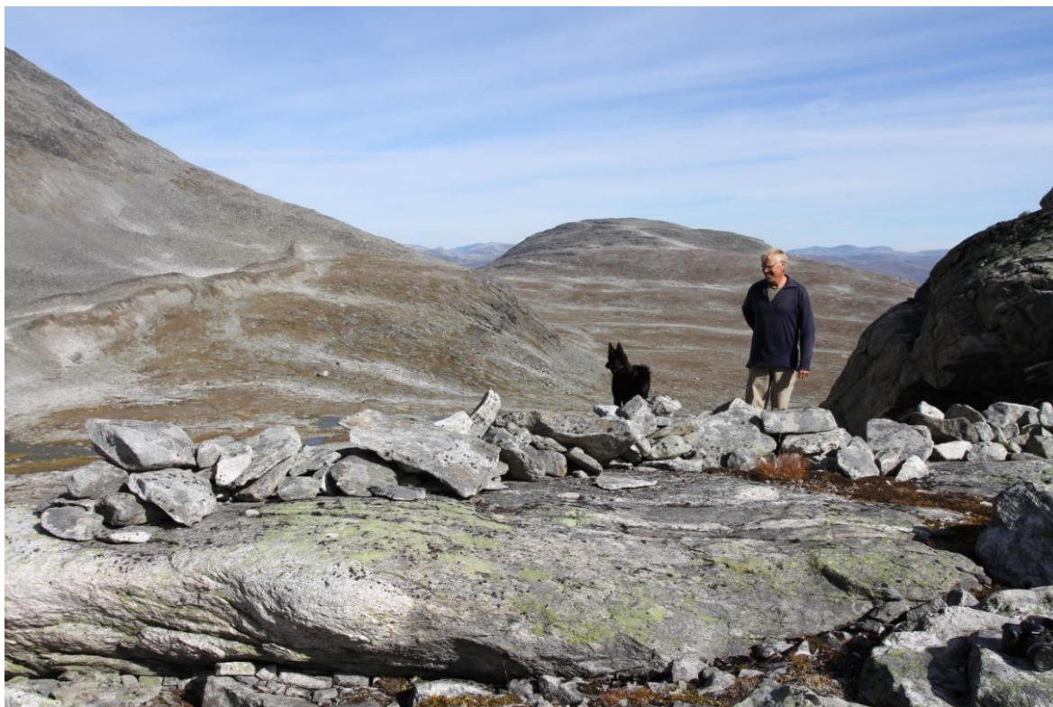
Figur 68. Øverste delen av sperremuren på østsiden av Grovåskaret. Bak den går berget bratt ned mot nord og utgjør i dag et naturlig stengsel på østflanken av anlegget. Muren må ha vært bygd i en tid da fonnen var mye større og gikk helt opp til platået vi ser her. Kanskje den dekket mye av inngangspartiet til anlegget fra nord. Fjelloppsyn i Nesset fjellstyre, Dag Ringstad (bildet) har samlet mye verdifulle data fra dette anlegget, og ellers fra Eikesdalsfjella.
