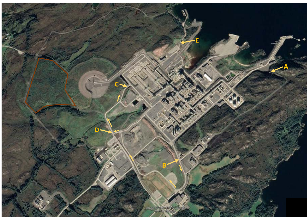
Figur 2. Figuren viser fabrikkanlegget og friarealet innenfor gjerdet slik det framsto i 2019. Depony-fyllingens omkrets er markert med en oransje linje i figuren til venstre for det sirkulære området rundt flammearnet. Transekt 1 fulgte veistrekningen langs gjerdet fra punkt A til punkt B. Transekt 2 startet ved punkt B og fulgte veinettet markert med små piler til punkt C. Transekt 3 startet ved punkt D og fulgte veien medurs langs gjerdet til punkt E.
