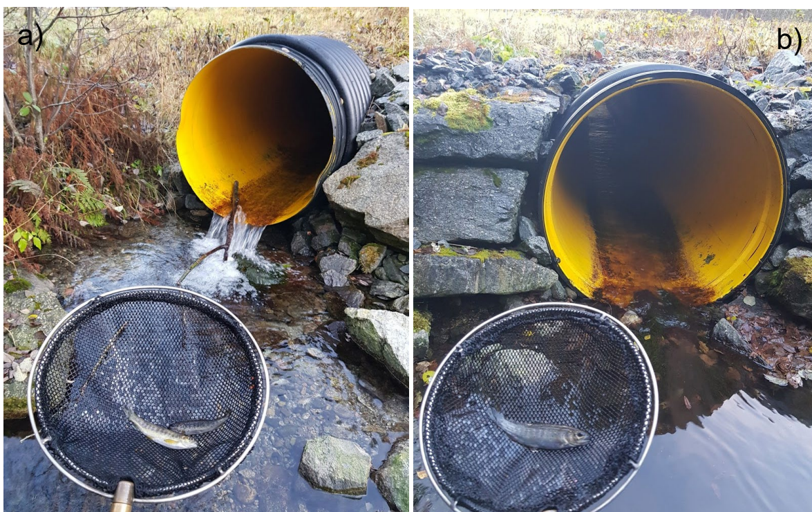
Bilde st4. Kulvert gjennom fylkesveien er vandringshinder for oppvandrende laksefisk. Hellingen i kulverten er lav, men høydeforskjellen kan gjøre det vanskelig å passere. a) Kulvert sett fra nedsiden av fylkesveien. b) Kulvert sett fra oversiden av veien. På oversiden av veien står vannet i dype grøfter med stillestående vann. Området er svært begrodd. Substratet består av silt og fin grus med innslag av større stein. Foto: Knut Andreas E. Bækkeli, NINA.
