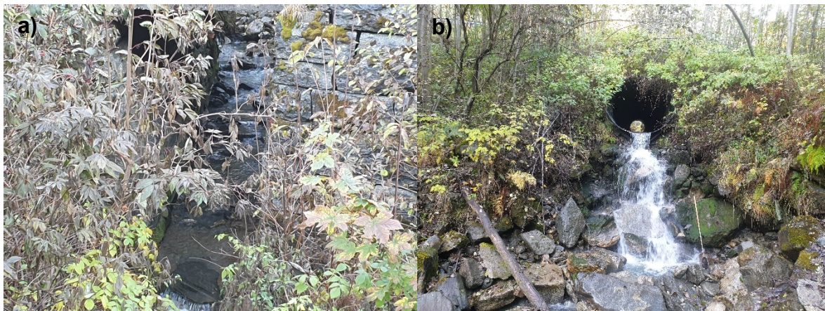
Bilde v3. På tur ned mot Driva passerer Stor-Vinnu først under gang- og sykkelveien med steinsatt elvebunn (a), deretter rv. 70 gjennom kulvert (b). Foto: Eva M. Ulvan, NINA.
