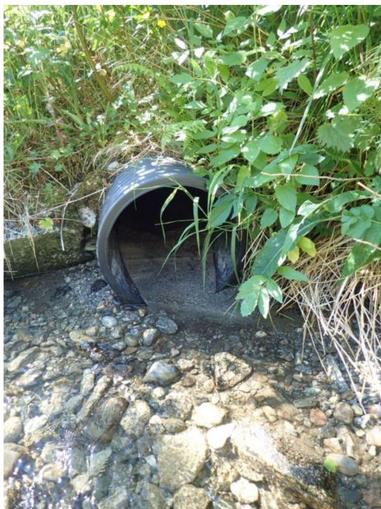
Bilde 17. Silt og sand tilføres Langhammerbekken blant annet via dreneringsrør. Bildet er fra juli 2018. Foto: Michael Puffer, Sunndal kommune.
