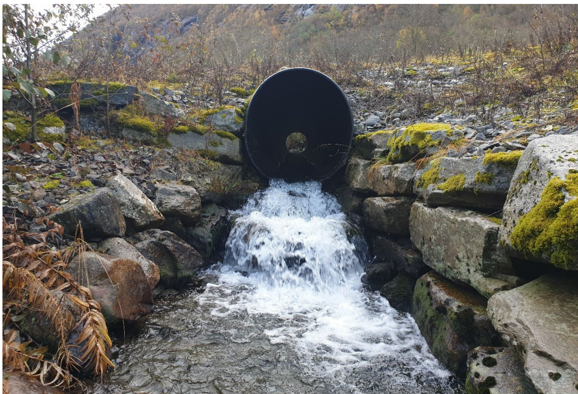
Bilde f3. Fagerbekken renner under rv. 70 gjennom kulvert. Kulverten er trolig absolutt vandringsbarriere for oppvandrende fisk. Foto: Eva M. Ulvan, NINA.
