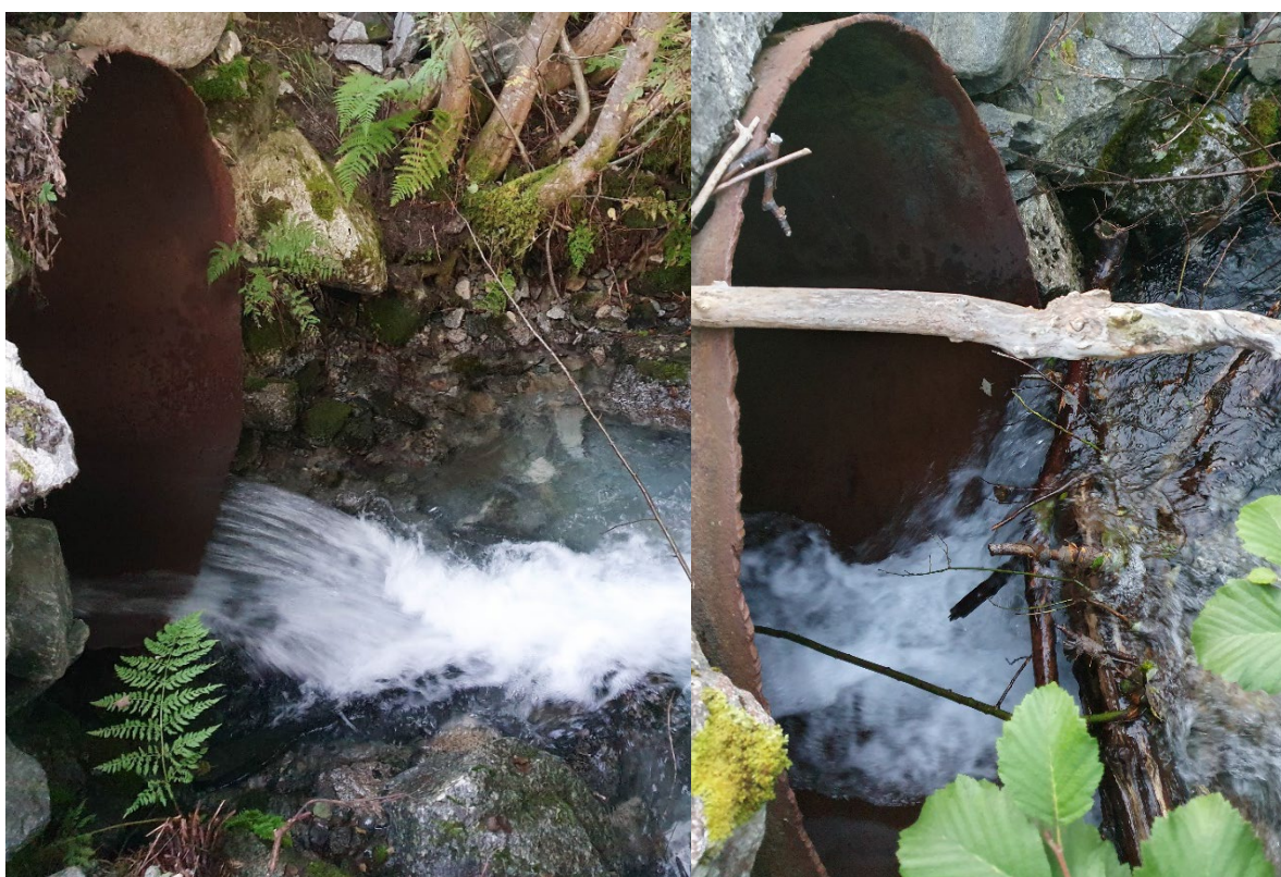
Bilde I5. Over- og nedside av vandringshindrende kulvert ved anleggsområdet ovenfor Løykjahagan. Foto: Torgeir B. Havn, NINA.
