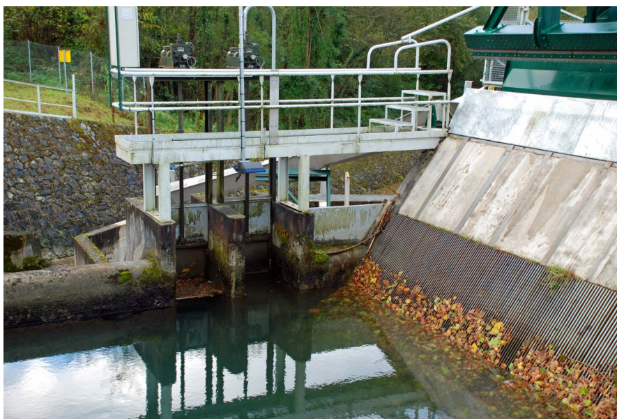
Eksempel på vellykket plassering av vanninntak/fiskeinngang på fiskepassasje ved siden av varegrind ved kraftverk i elva Gave d'Oussau i Frankrike. Det er viktig at slike fiskeinnganger blir plassert nært inntil varegrinda (Foto: M. Kraabøl).
