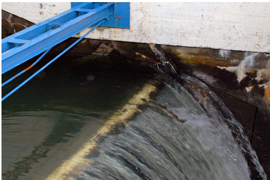
Nedvandring av utgytt voksen ørret over flomluka ved Hunderfossen kraftverk. Flomluker med lav fallhøyde er meget gunstige vandringsveier for fisk forbi kraftverk (Foto: M. Kraabøl).
