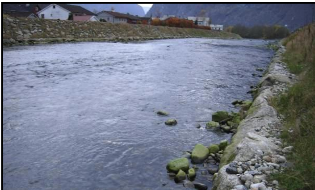
Bilde 10. I nedre deler av Daleelva er et lengre vassdragsavsnitt sterkt påvirket av kanalisering og forbygging. Dette har blant annet ført til at kantvegetasjonen er fjernet for en kortere eller lengre periode. Fotografi: Gunnbjørn Bremset.
