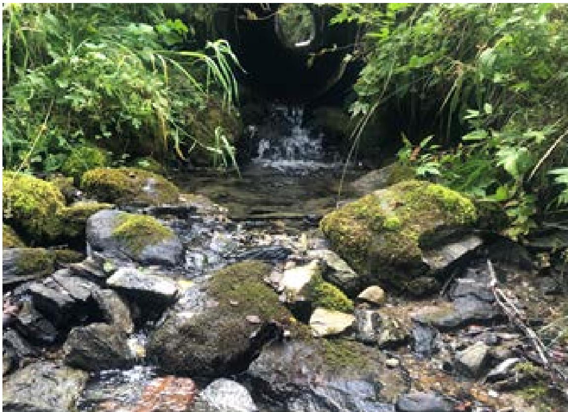
Foto 5: Vandringsstoppende veikulvert i tilsigsbekk, like før munning til Vikelva (foto: Morten Andre Bergan).
