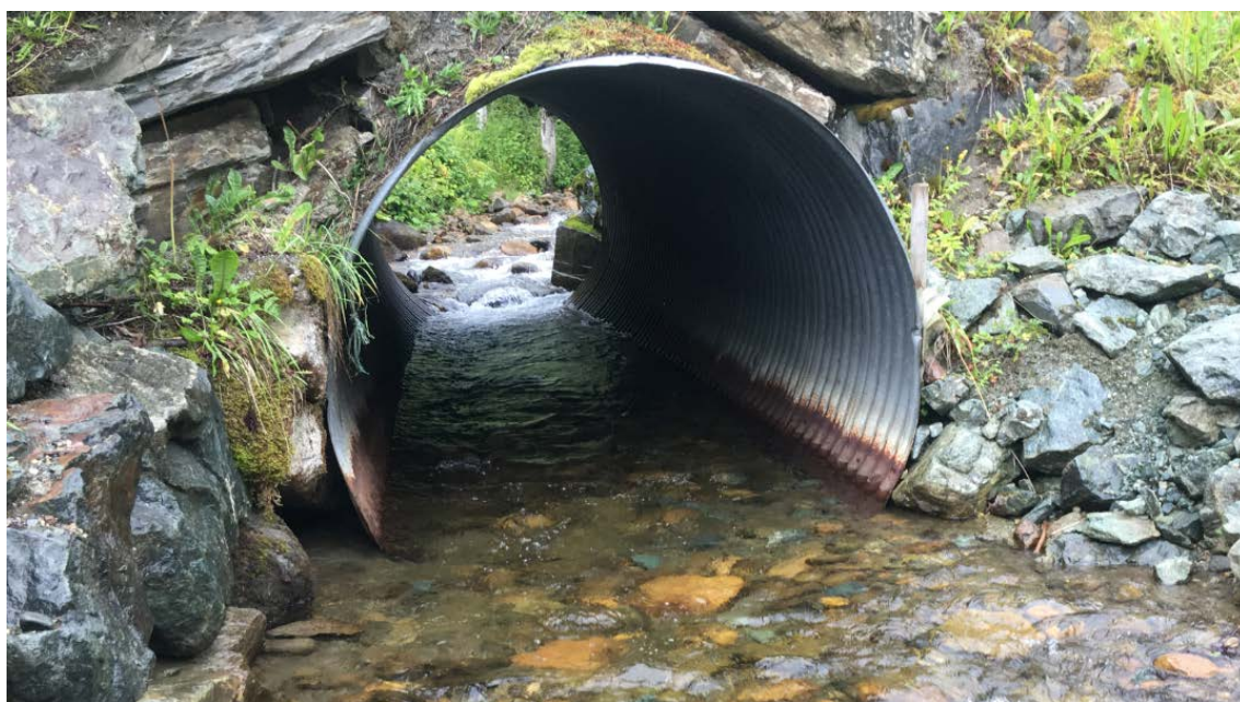
Bilde 13. God løsning. Veikulvert med bevart bekkebunn og noe innsnevring av opprinnelig vassdragsløp. Foto: Morten Andre Bergan, NINA.
