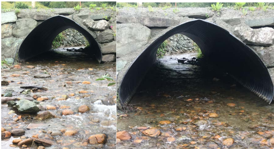
Bilde 12. Optimal løsning. Veikulvert med bevart bekkebunn og ingen innsnevring av opprinnelig vassdragsløp. Foto: Morten Andre Bergan, NINA.
