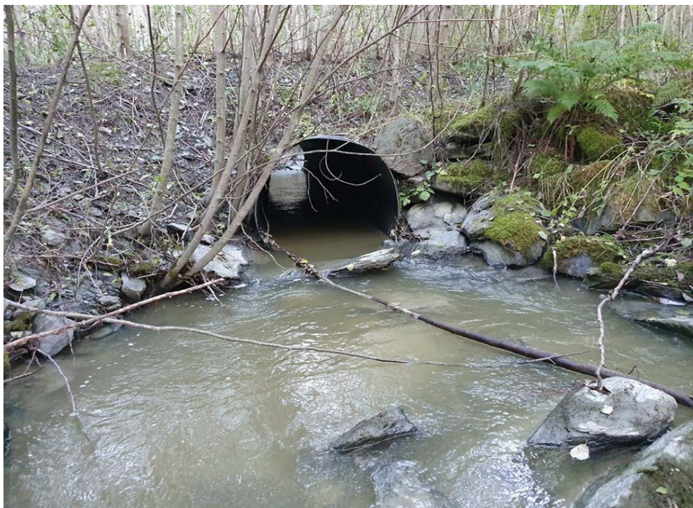
Bilde 9. Kulvert under gammel jordbruksvei ca. 100 meter oppstrøms samtløp med Vigda fremstår som uproblematisk for fisk å passere. Foto: Øyvind Solem, NINA.
