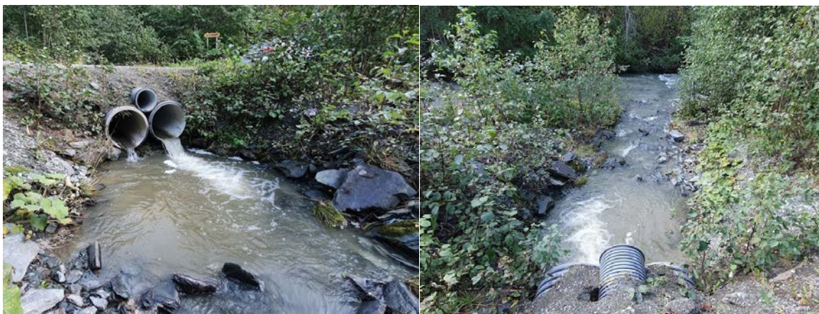
Bilde 5. Venstre bilde viser kulvert i form av tre rør under tursti ca. 10 meter oppstrøms der Valsetbekken renner ut i Vigda. Kulverten er et klart vandringshinder for anadrom laksefisk. Høyre bilde tatt fra tursti og nedstrøms mot samløp. Foto: Øyvind Solem, NINA.
