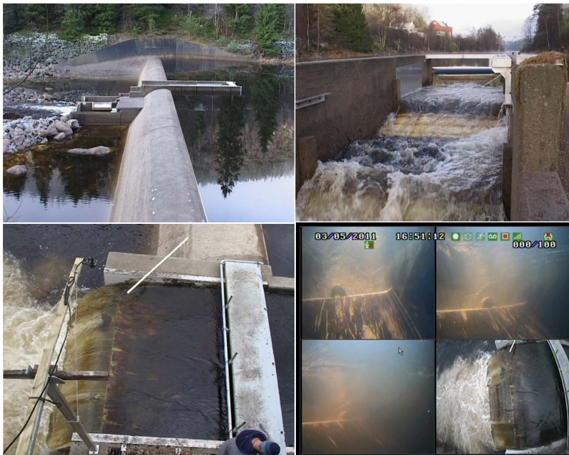
Figur 4.1. Fisketrappa i midten av dammen i utløpet av i Manflåvann i Mandalsvassdraget i 2011 (de to øverste bildene). I tillegg til tre undervannskamera, ble det også montert ett overflatekamera dette året (de nederste to bildene). Bilder fra disse fire kameraene dekker hele tverrsnittet av reguleringsluke i dammen.
