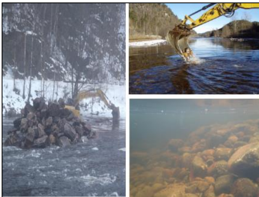
Før og etter fjerning av to av tersklene. Flyfoto på vintervannføring ( 6 \text{ m}^3/\text{s} )
