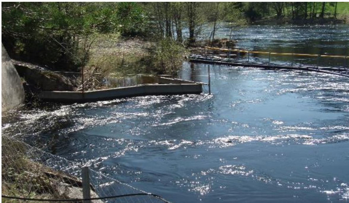
Inntak til Laudal kraftverk (til venstre) med alternativ nedvandringsvei i bakkant
