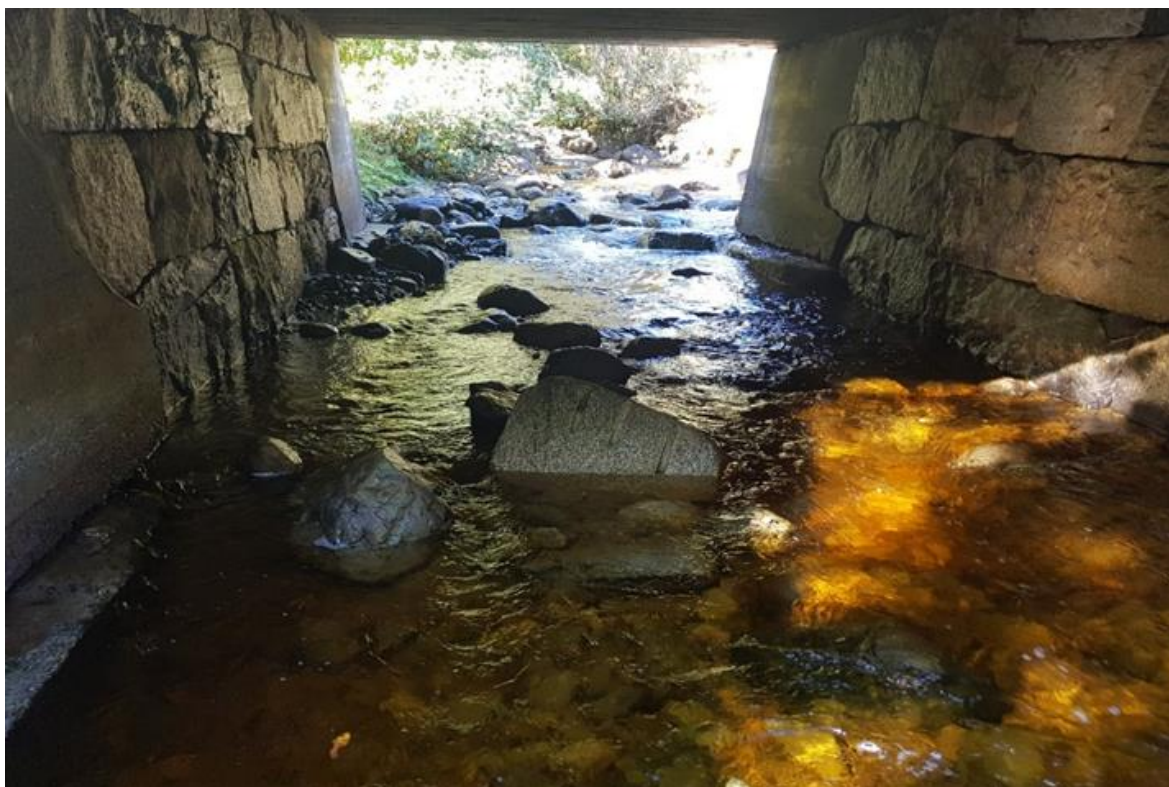
Figur 54. Kulvert under Fv 65 høsten 2018. Bunnen består av naturlig stein og utgjør ikke et vandringshinder for anadrom laksefisk i Ela. Foto: Øyvind Solem, NINA.
