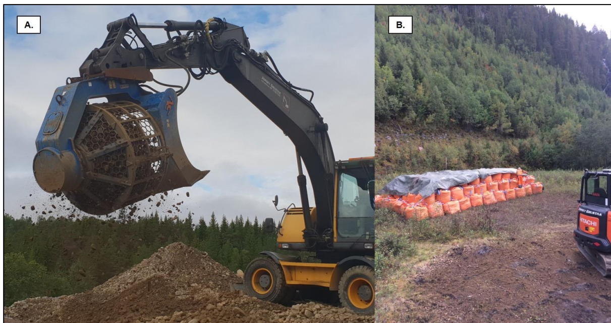
Figur 7. A. Sorteringsskuffe for å sile ut ønsket steinstørrelse fra grustaket i Resdalen. B. Gytegrus ferdig opplesset i «big bags», kontrollveid og stablet ved Rennebu JFF sin skytebane i Svenskedalen, mellom Brattset kraftverk og Nylenfossen. Foto: Marius Berg, NINA.
