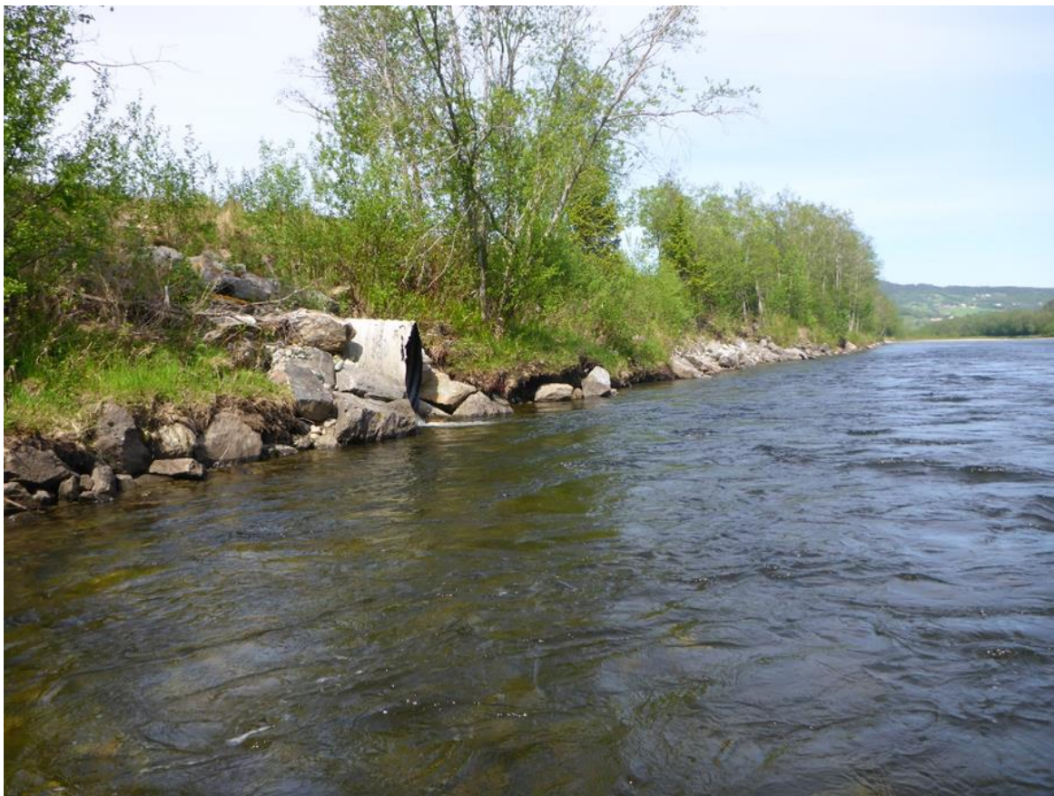
Figur 60. Kulvert gjennom forbygning er lite egnet for oppvandring av anadrom laksefisk til Tonga. Foto: Jan Gunnar Jensås, NINA.
