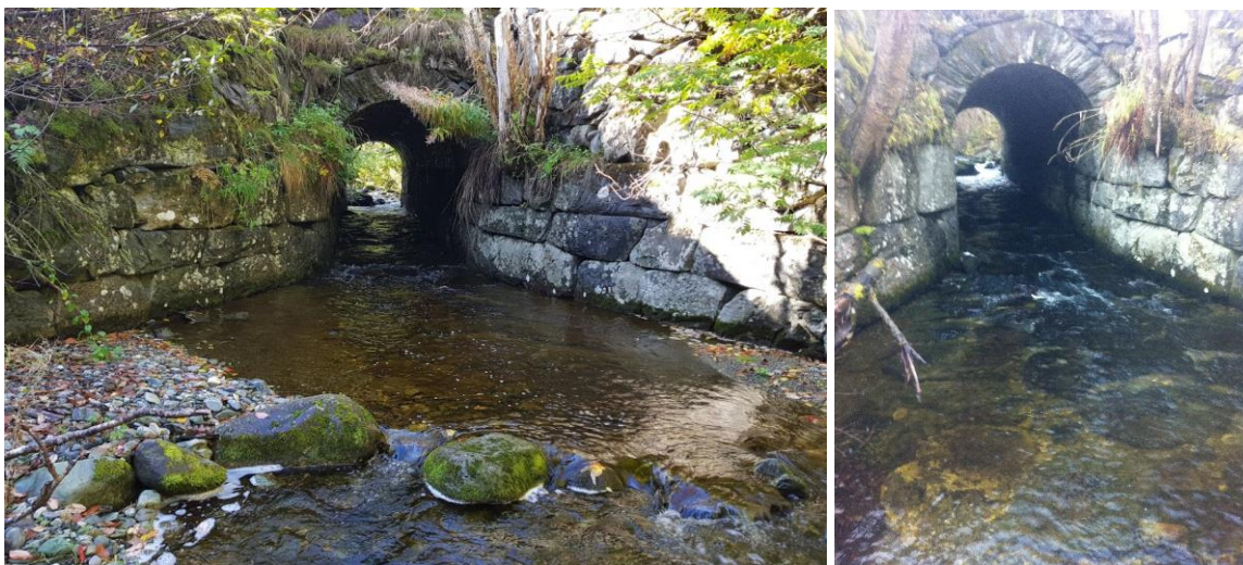
Figur 49. Til venstre: Kulvert under Fv 65 høsten 2018, på lav vannføring. Veikrysningen anses ikke som et vandringshindrende for anadrom laksefisk i Druggu/Litjdruggu, uansett fiskestørrelser. Til høyre vises foto av samme kulvert på noe høyere vannføring, tatt under befaring i 2011 (arkivfoto). Foto: Øyvind Solem/Morten Bergan, NINA.
