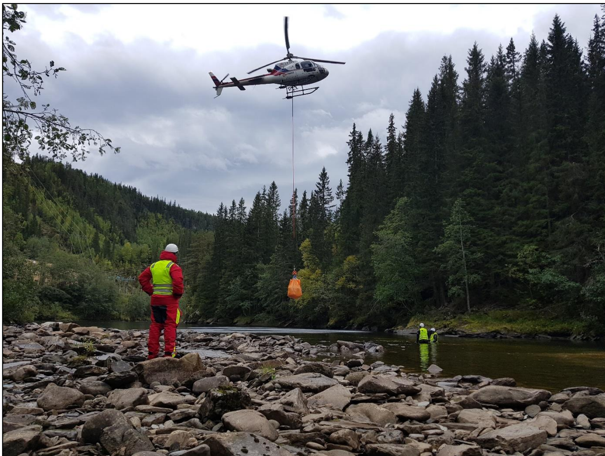
Figur 8. Utlekking av gytegrus i Orkla ved utløpsområdet til Stavåa. Sekken settes ned på elvebunnen, før man skjærer ned langs to sider av sekken og kapper to av de fire bærestroppene. Sekken løftes forsiktig slik at den revner og grusen faller ut. Grusen rakes deretter ut på elvebunnen. Et alternativ til «big bags» er bruk av tobber som fylles opp med grus av gravemaskin/traktor. Foto: Øyvind Solem, NINA.
