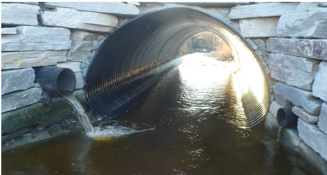
Figur 24. Nylig skiftet veikulvert under Fv 235 (A) i Balsneselva er godt egnet for fiskevandring uansett vannføringsforhold i vassdraget. Foto: Morten Bergan.
