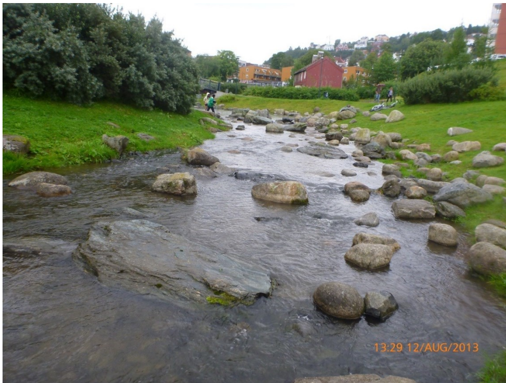
Figur 74. Utlagt storstein i Ilabekken. Fordi det er ønskelig å ha et urbant preg over Ilabekken, er det lagt ned forbud mot å etablere kantvegetasjon, og kompensert med bruk av storstein. Dette gjelder ikke for Stamselva eller Reitbekken, som bør få etablert så mye som mulig av sin kantvegetasjon. (Foto: Morten Bergan)
