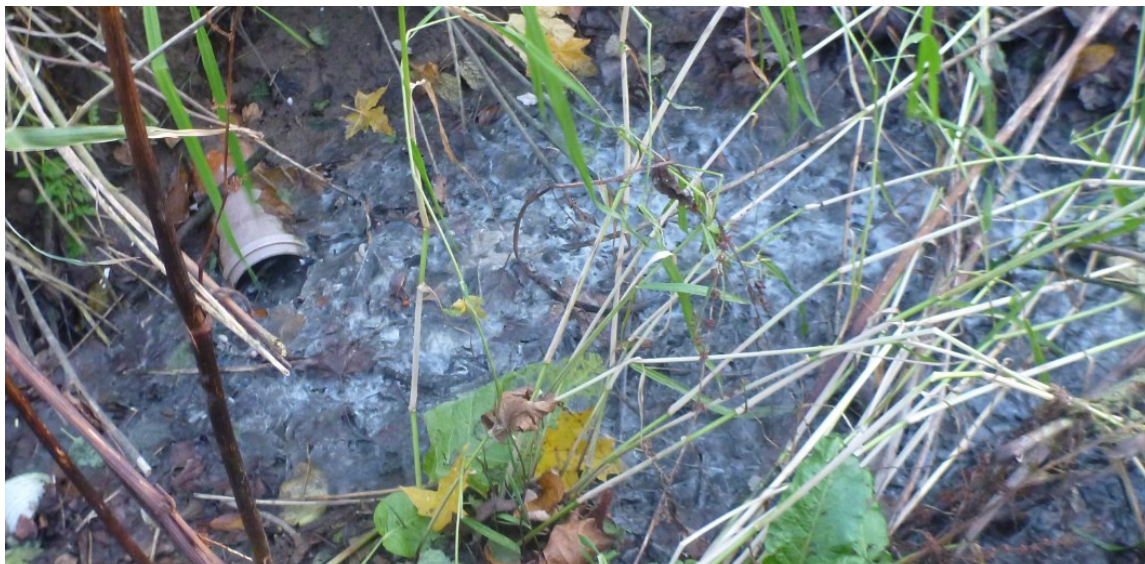
Figur 44. Delvis nedsunken utslippsrør, som ikke var i virksomhet ved befaringen, men der det i perioder ser ut til å være utslipp av ukjent omfang og innhold, basert på tilstanden (lukt og ut-seende) nedstrøms røret. Foto: Morten Bergan.
