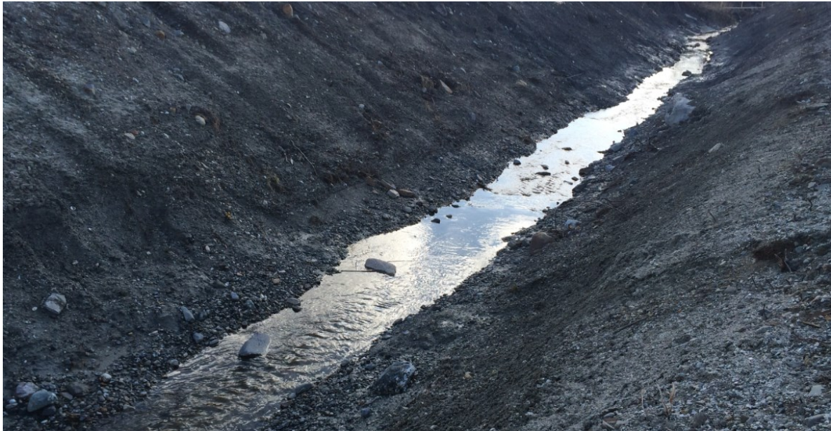
Figur 48. Nyutgravde Stamselva, som for tiden mangler alt av kantvegetasjon, egnet substrat og andre kvaliteter som vil gi god vannøkologisk helsetilstand på sikt.
