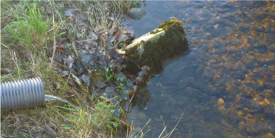
Figur 41. Utslippsrør, med ukjent innhold, fra bolighus til Reitbekken ved Reitan. Foto: Morten Andre Bergan.
