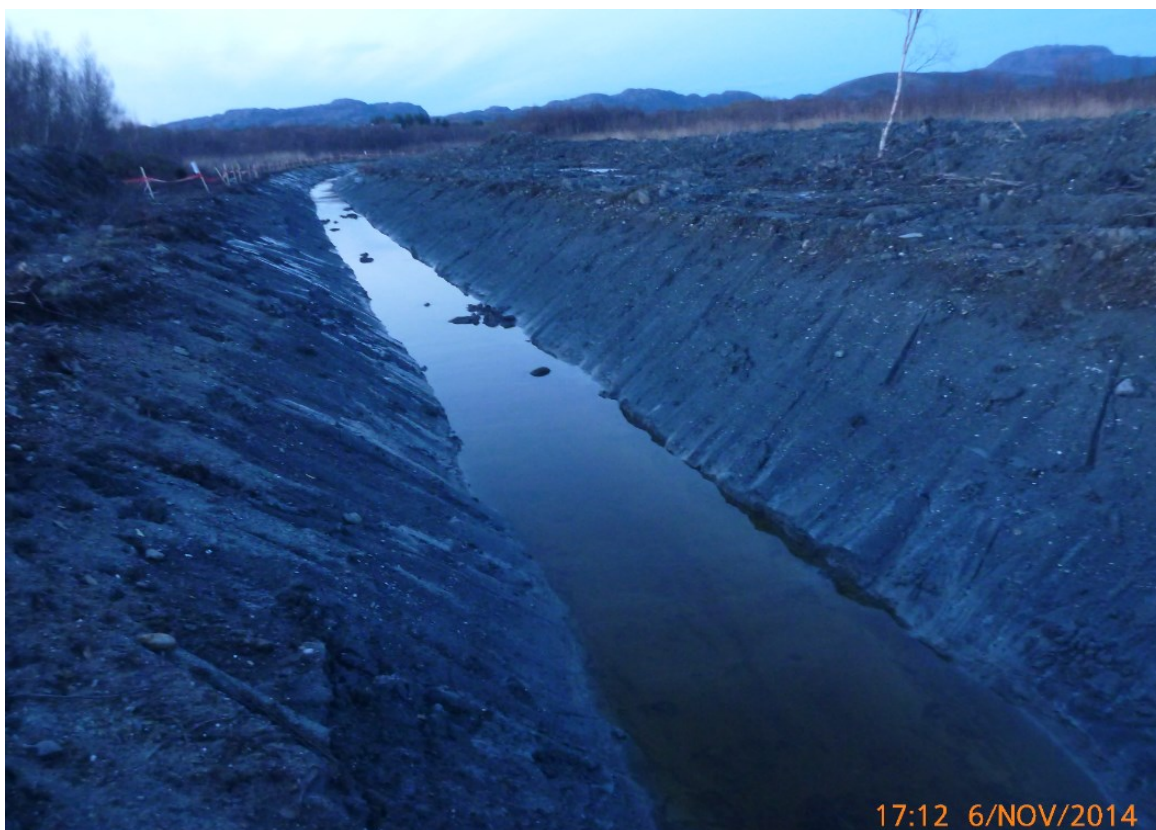
Figur 64. Utgrunnet og rett kanal i Reitbekken/Stamselva ovenfor samløp med nyanlagt utløpsbekk fra Rusasetvatnet.
