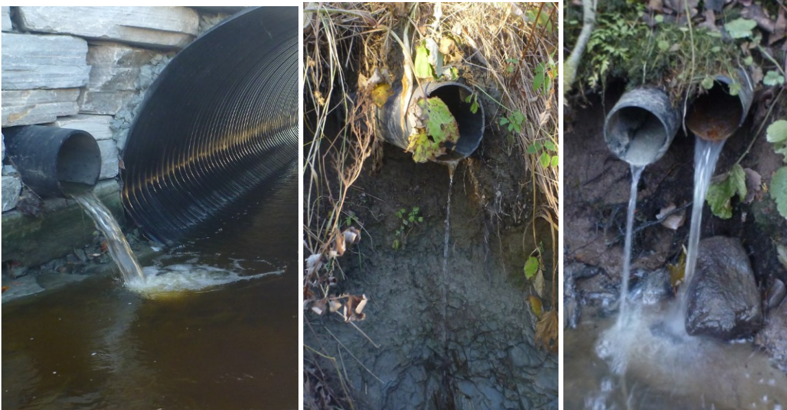
Figur 42. Ulike utslippsrør med ukjent innhold i Balsnesvassdraget. Lukt av kloakk eller nedslamming/begroing nedstrøms utslippspunktet kan tyde på negativ vannkjemisk påvirkning til vassdraget. Foto: Morten Andre Bergan.
