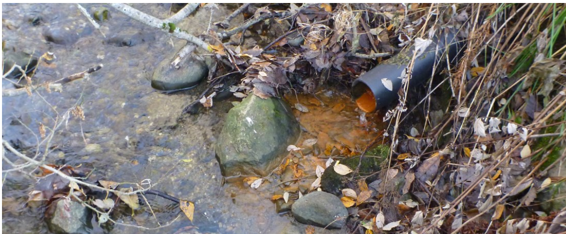
Figur 39. Drensrør (?) til Balsnesvassdraget, der en har utfelling av jern ved utslippspunktet. Foto: Morten Bergan
