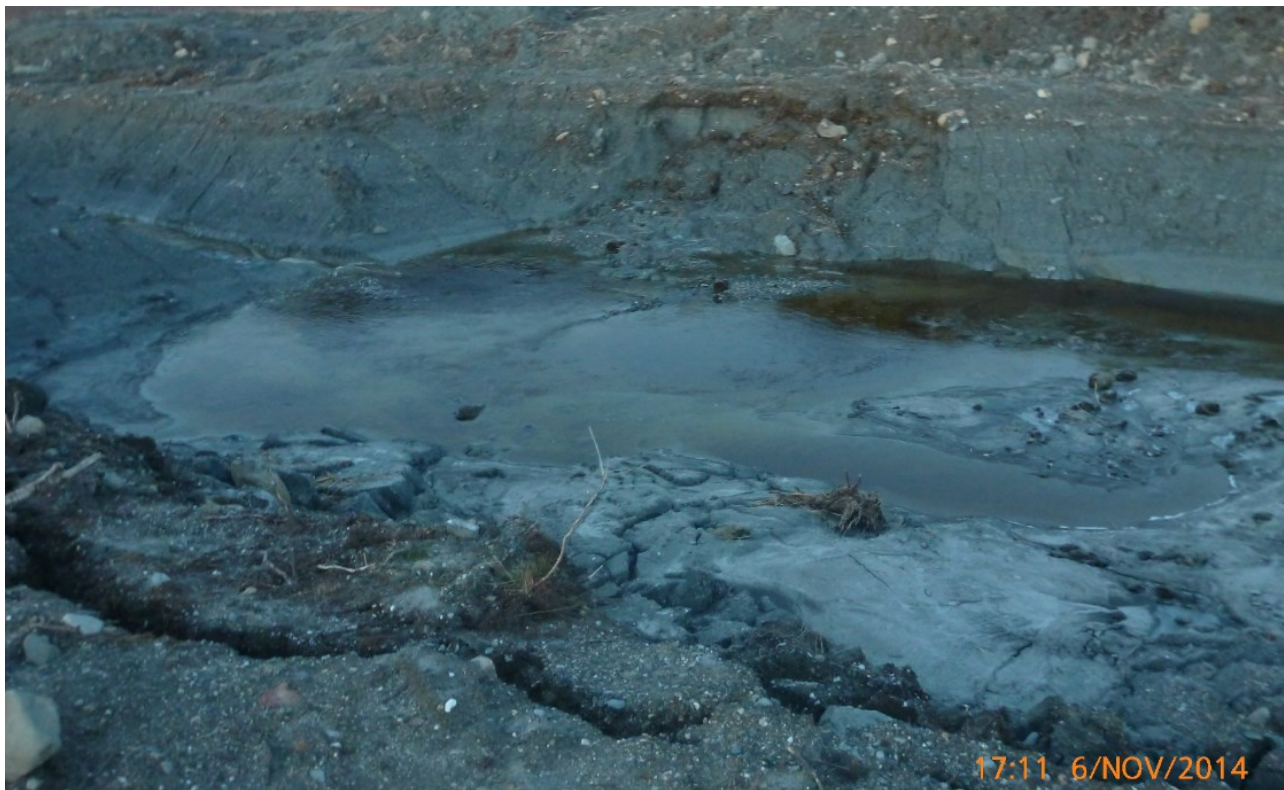
Figur 65. Anlegging av større kulp/dypområde i Reitbekken/Stamselva.
