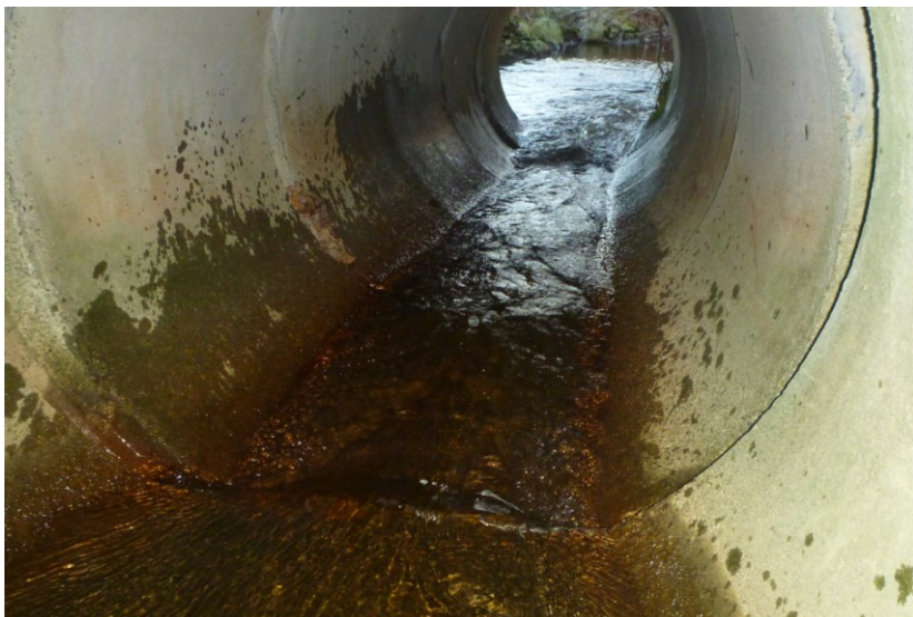
Figur 31. Noe ukurant veikulvert under bilvei mellom Solhaugen og Trelskogen (H), men ungfisktellingerne i 2013 og 2014 viser at sjøørret kan passere kulverten årlig. Foto: Morten Bergan.
