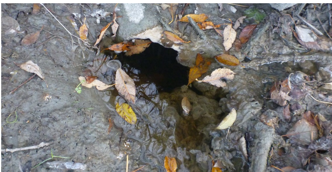
Figur 40. Sig av silo-luktende vann fra betongrør, delvis nedgravd, i Balsneselva ved stasjonsområde 1. Oppblomstring av bakteriekolonier («lammehaler») i og nedstrøms utslippet tyder på svært høyt næringsinnhold i sigevatnet. Slike utslipp kan potensielt føre større akuttutslipp i nedbørsperioder eller ved uhell. Foto: Morten Andre Bergan
