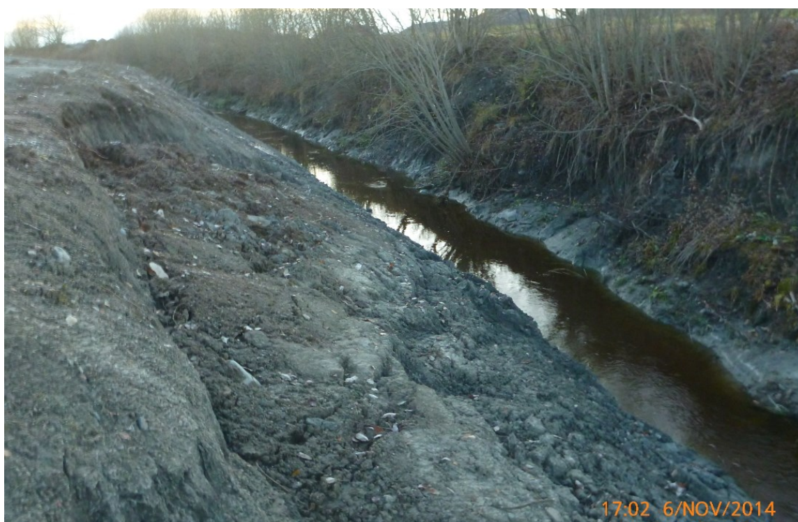
Figur 60. Stamselva i nedre del av tiltaksområdet.
