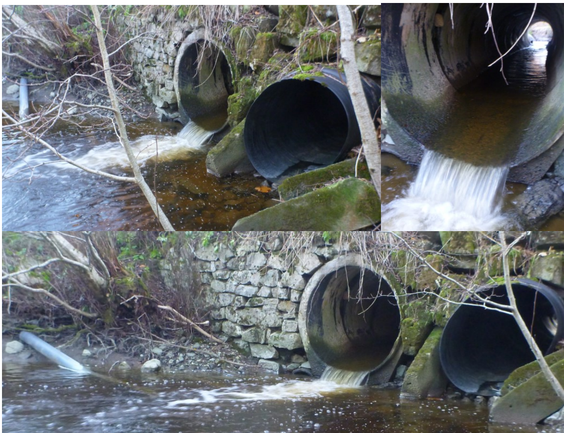
Figur 28. Veikryssing under FV 231 ved Lundal (E) kan forsinke eller hindre oppgang, men er passerbar for sjørørret. Foto: Morten Bergan.
