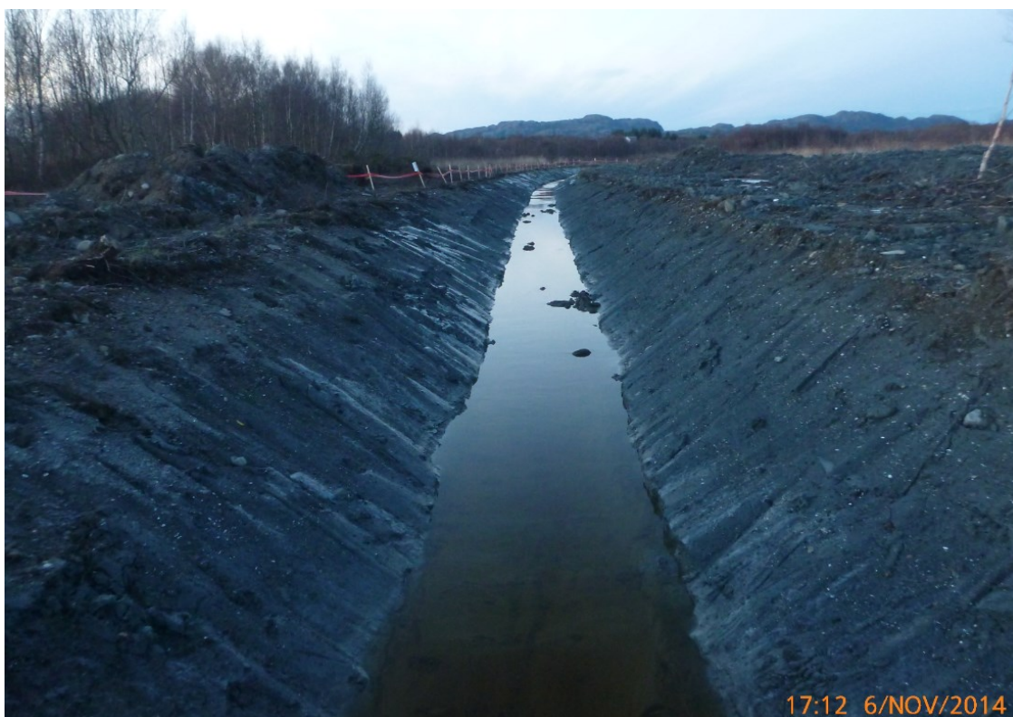
Figur 62. Utgrunnet og rett kanal i Reitbekken/Stamselva ovenfor samløp med nyanlagt utløpsbekk fra Rusasetvatnet.
