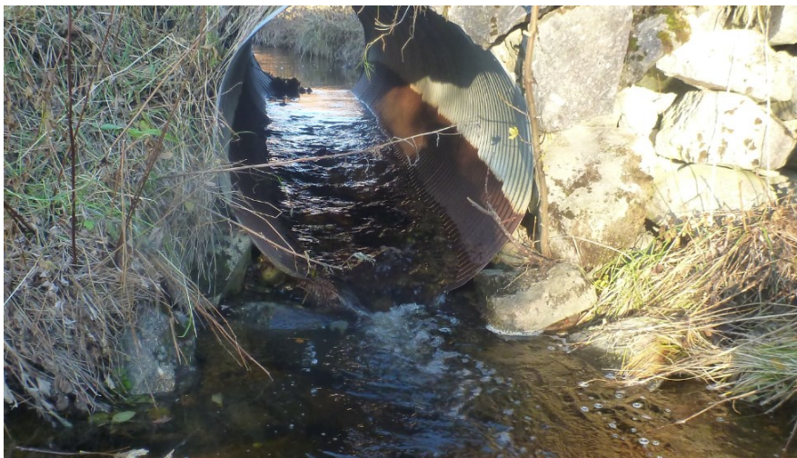
Figur 27. Kulvert under grusvei ved Reitan (D) er passerbar for ørret i de fleste størrelser og på de fleste vannføringer. Foto: Morten Bergan.
