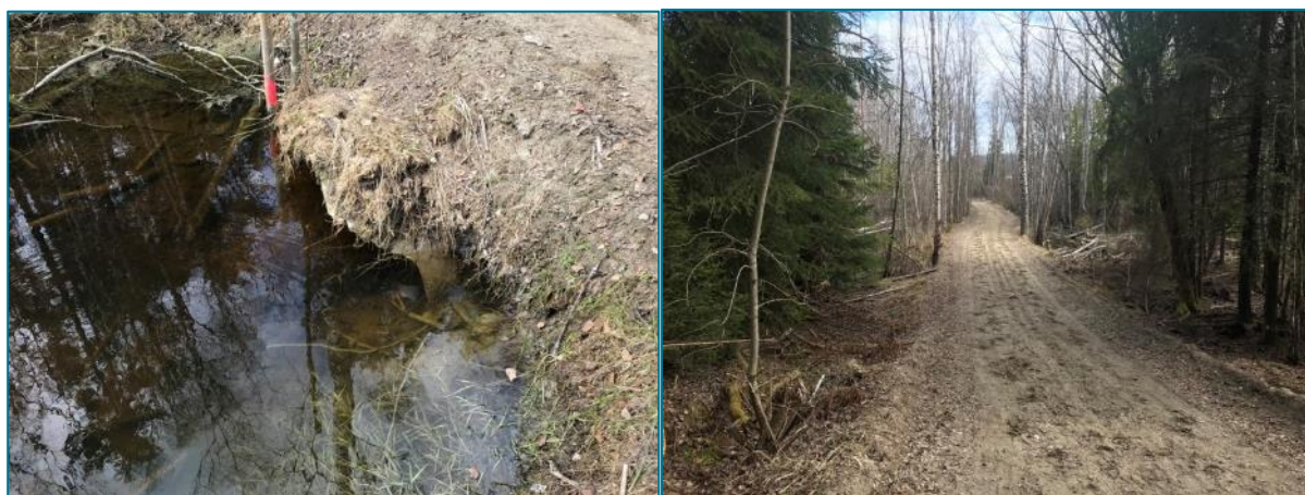
Figur 3.15. Eksisterende kulvert ved kryssende vei anbefales å fjernes for å isteden heve og forsterke den eksisterende veien, slik at vannet kan gå over ved høy vannstand. Foto. Magnus Nygård, 2018 ©
