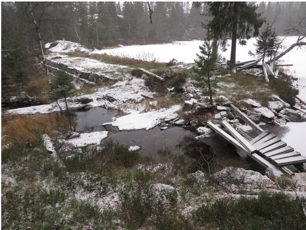
Figur 17 Dammen på Krokvann med overløpet nærmest fotograf.
