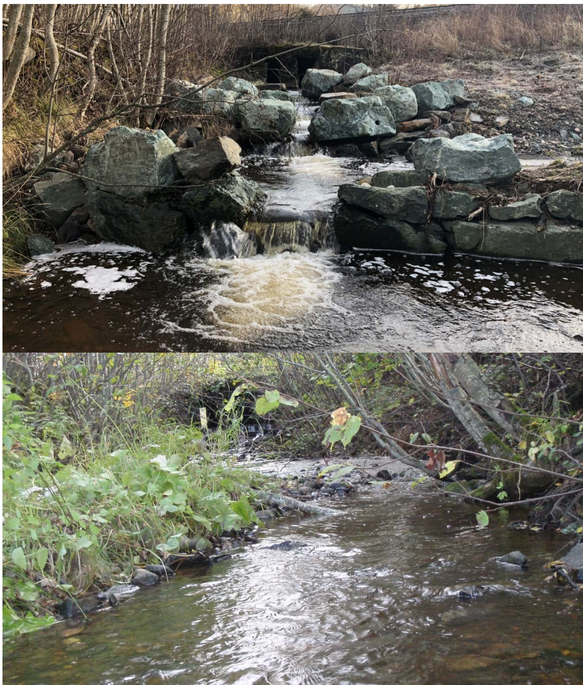
Figur 40. Fisketrappa i Lynga nedstrøms jernbanekrysningen i november 2018 (øverst). Samme bekkeparti i 2008, før tiltak (nederst). Foto. Morten Andre Bergan.
