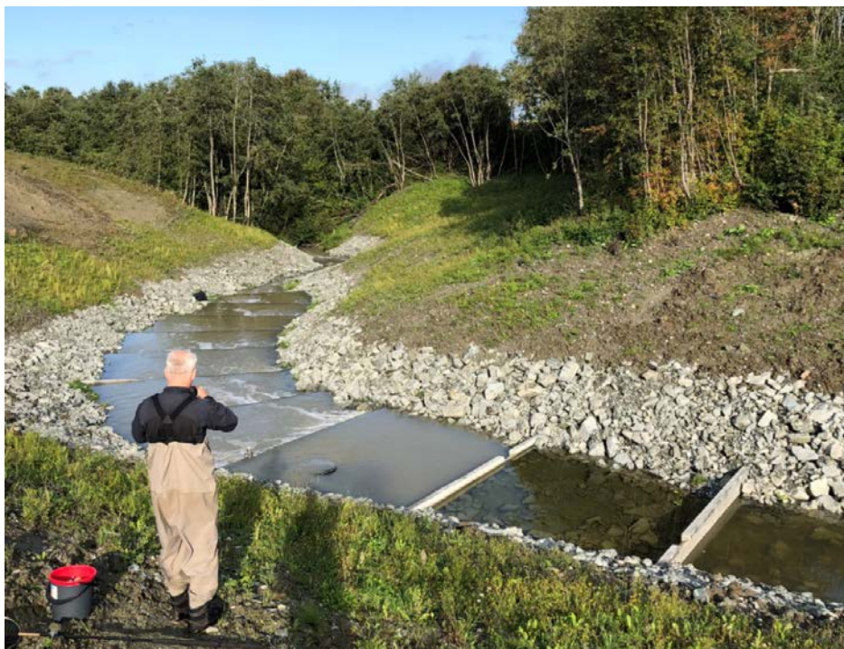
Figur 9. Nederste terskel (for stort sprang og lav vanndybde nedstrøms) i dette bekkepartiet av Søra må endres slik at sjørret kommer forbi. Foto: Morten Andre Bergan.
