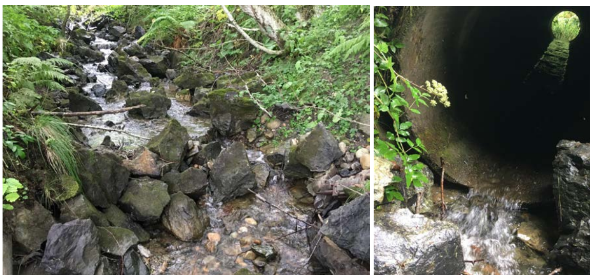
Figur 24. Bekk ved Kleivahammaren går i kanalisert løp nedstrøms Lebergsveien (t.v.), og krysser veien i en underdimensjonert betongkulvert (t.h.). Foto: Morten Andre Bergan.
