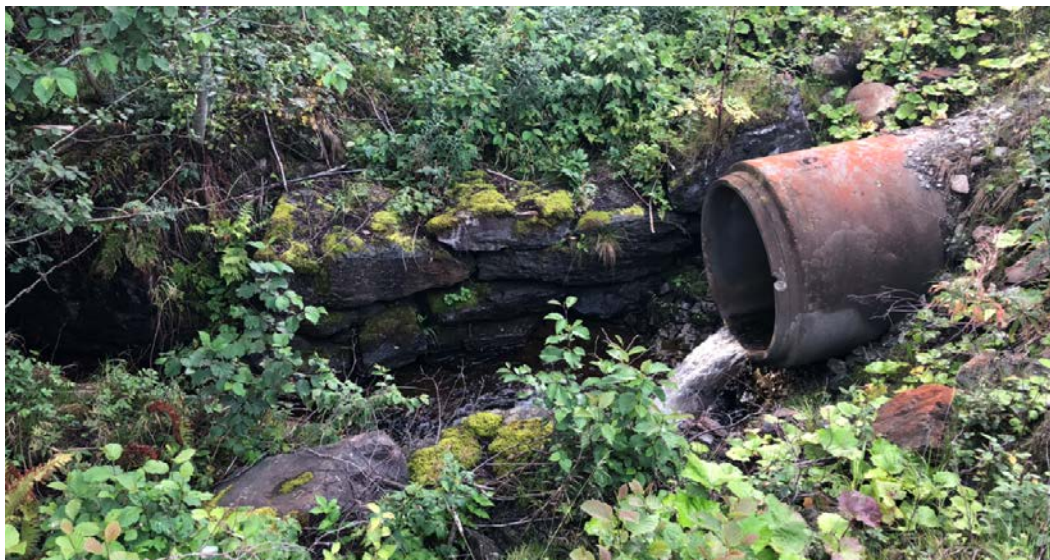
Figur 85. Kvernbekken går i en vandringsstoppende veikulvert under E6 ovenfor stasjon 23a. Foto: Morten Andre Bergan.
