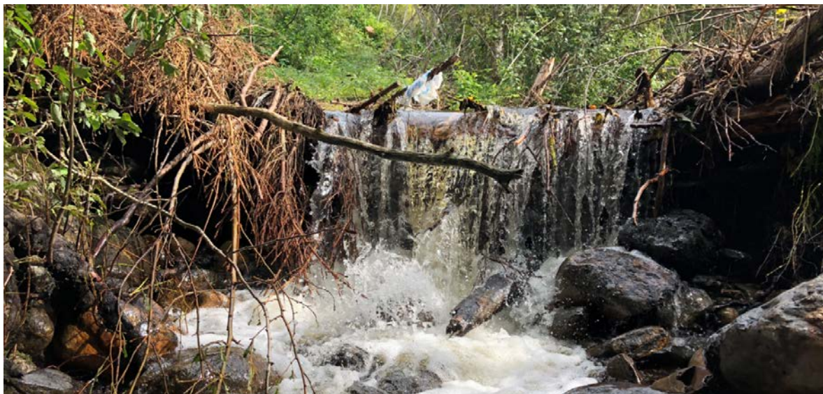
Figur 107. Bonesbekken og anleggsvei/traktorvei over bekken, som har medført for stort fall nedstrøms, slik at laks og sjørret ikke lenger kan utnytte gode produksjonsområder ovenfor. Foto: Morten Andre Bergan
