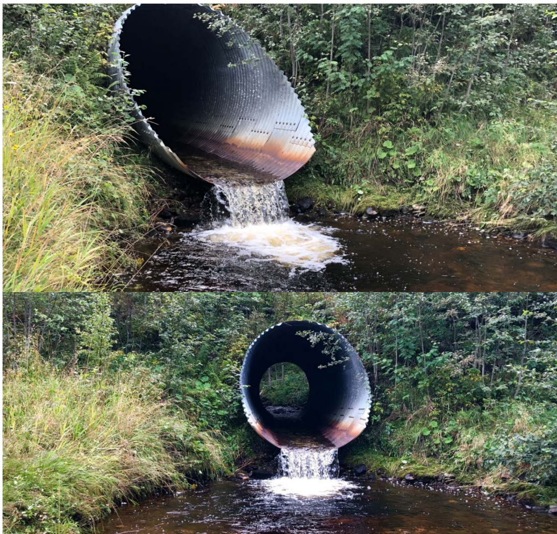
Figur 104. Veikulvert under RV 30 hindrer fiskevandring, selv om den kan passeres på optimale vannføringer. Den økologiske effekten over tid er at ørretbestanden blir svært redusert. Foto: Morten Andre Bergan
