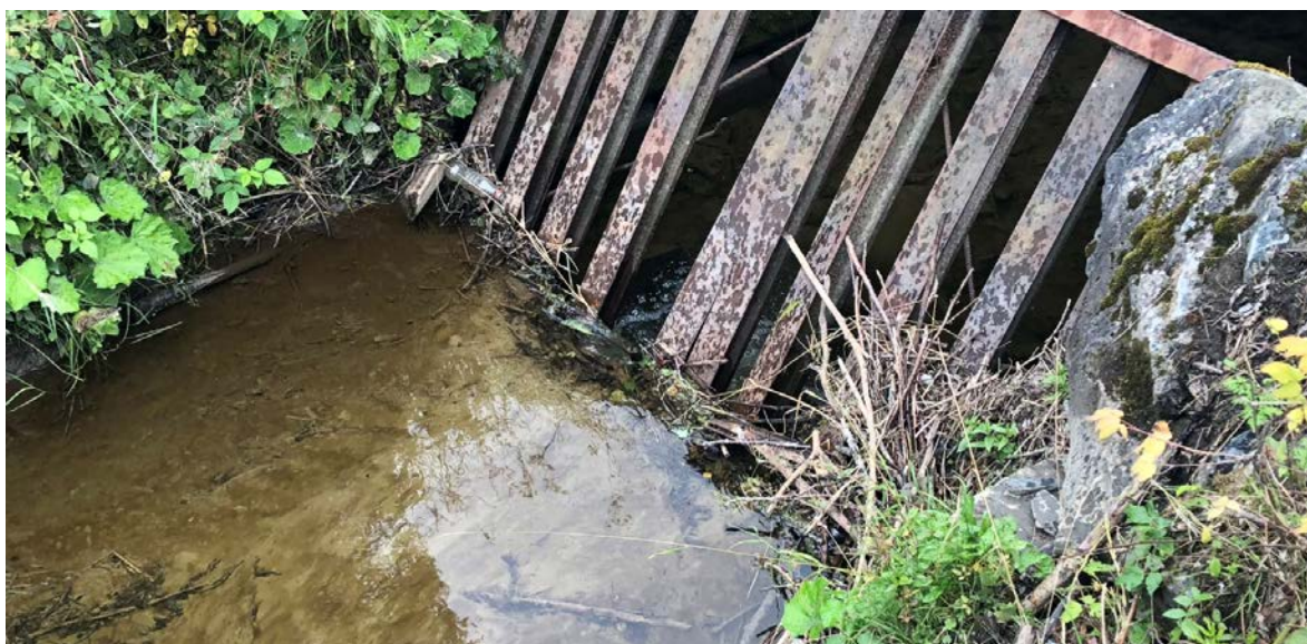
Figur 54. Rista foran kryssing/stikkrenne under jernbane i nedre del av Ørbekken/Skjerva. Foto: Morten Andre Bergan.
