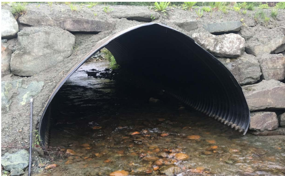
Figur 18. Strekning i Loa gjennom ny kulvert under Fv 6578 Lebergsveien høsten 2018. Kulverten er optimalt utformet for fiskevandring, og bør stå som eksempel til etterfølgelse ved alle framtidige veikrysninger i vassdrag med anadrom laksefisk Foto: Morten Andre Bergan.
