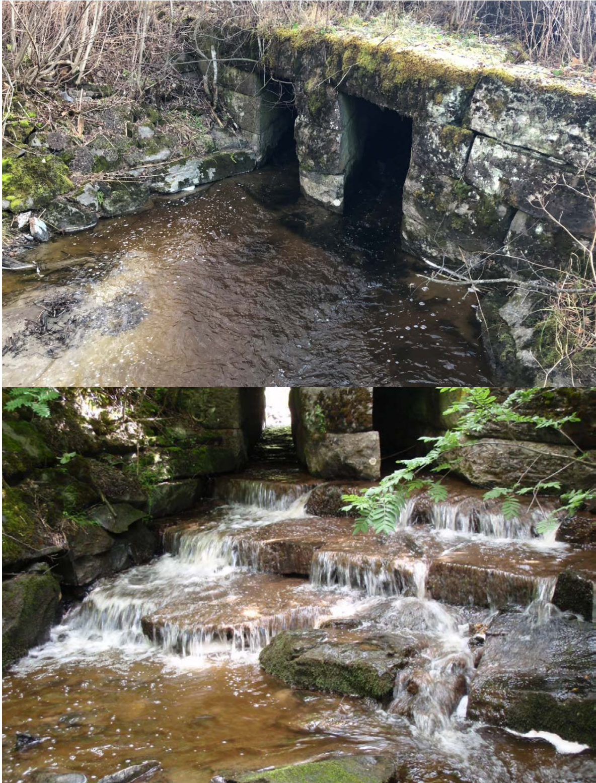
Figur 41. Stikkrenne under jernbane i november 2018 (øverst), og samme punkt i 2008, før tiltak. Foto. Morten Andre Bergan.
