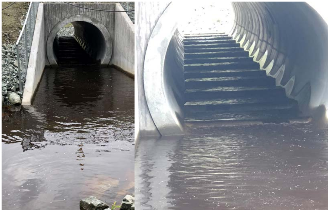
Figur 15. Strekning i Ratbekken under ny vei, og ny kulvert med terskler høsten 2018. Foto: Morten Andre Bergan.
