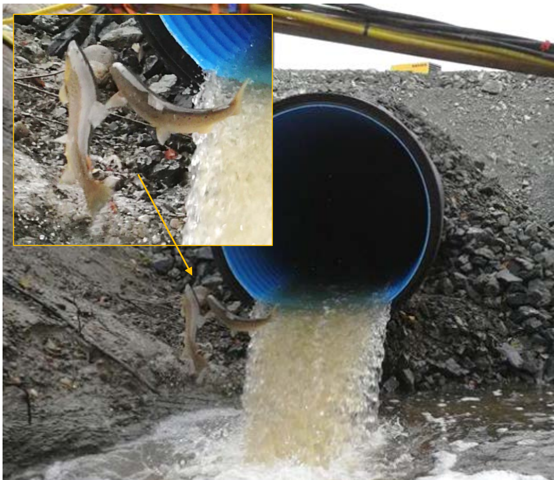
Figur 12. To sjørret gytefisk (oransje pil) forsøker å passere inngrepet og opp til gyteområdene i Ratbekken høsten 2017, men må gi tapt for summen av høydesprang, vannhastighet og lengde på rørlagt strekning. Konsekvensen ble som fryktet, fravær av gytefisk på bekkestrekingene ovenfor, og tilnærmet ingen årsyngelproduksjon i 2018. Foto: Privat/Lars Petter Wassmo.
