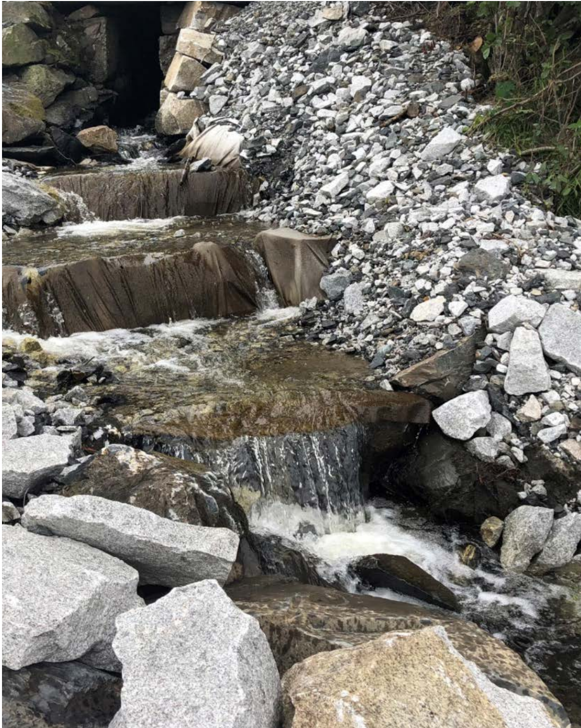
Figur 57. Øverste tre steg/terskler i fisketrappa opp mot stikkrenna under jernbanen. Foto: Morten Andre Bergan.
