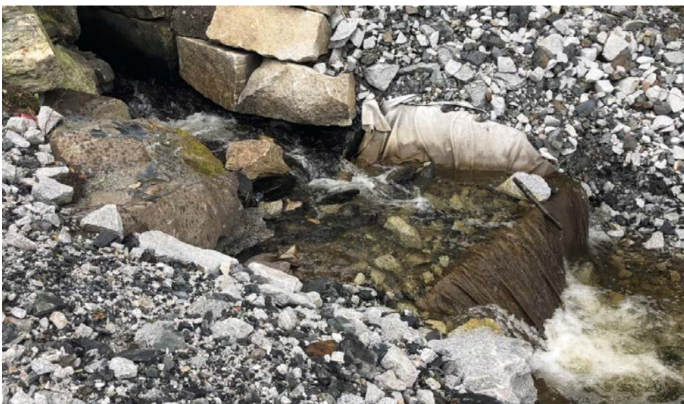
Figur 56. Øverste steg/terskel i fisketrappa opp mot stikkrenna under jernbanen. Foto: Morten Andre Bergan.
