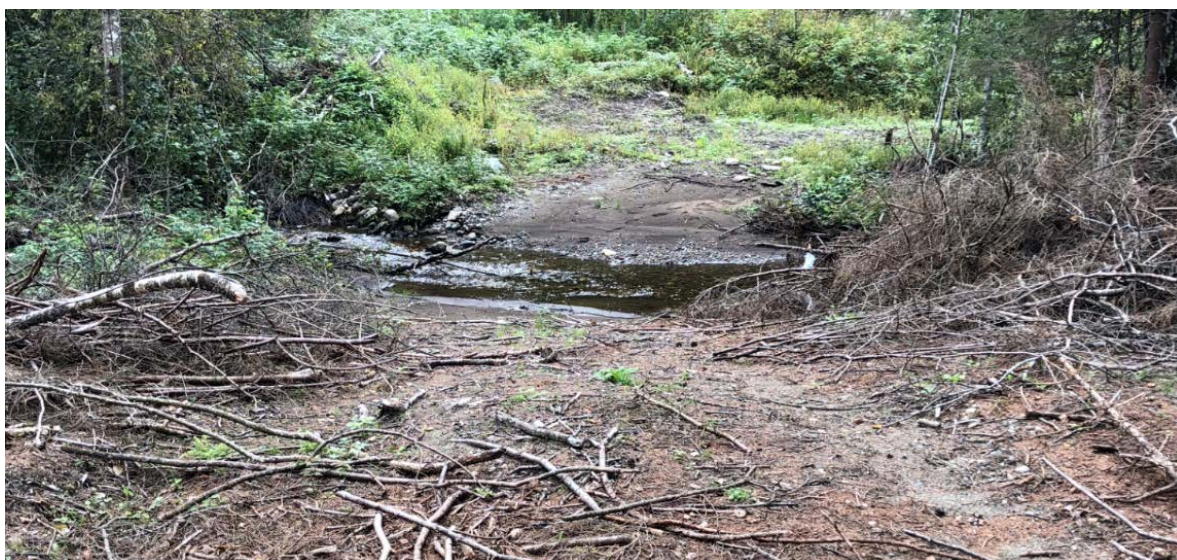
Figur 106. Bonesbekken og anleggsvei/traktorvei over bekken, som har medført for stort fall nedstrøms, slik at laks og sjørret ikke lenger kan utnytte gode produksjonsområder ovenfor. Foto: Morten Andre Bergan
