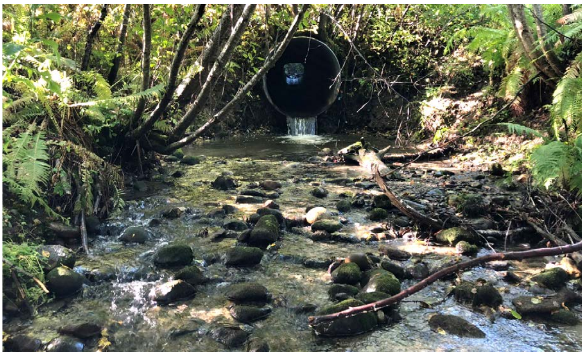
Figur 74. Vandringshindrende veikulvert under vei ved Spjelddalen. Foto: Morten Andre Bergan
