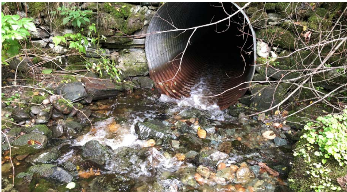
Figur 68. Bjørkbekken forsvinner i kulvert under Krogstadveien, som er en av to årsaker til at bekken er fisketom i dag. Foto: Morten Andre Bergan.
