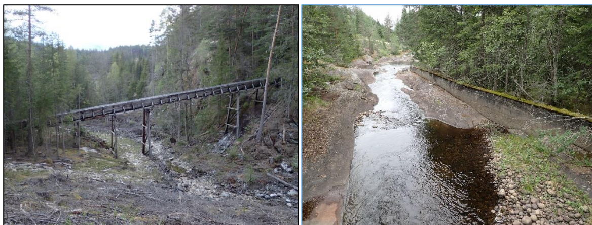
Figur 6. Det var mange fløtningsanordninger i Fulldøla for å lede tømmeret nedover elva. Tømmerrenna som ble bygd for å unngå de vanskeligste partiene i øvre del kan fortsatt sees (bildet til venstre). Skjermes ble bygd både av stein kledd med tømmer og i betong (bildet til høyre) for å holde tømmeret i elveløpet. Foto: Bjørn Mejdell Larsen.
