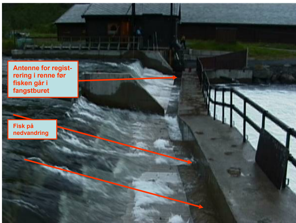
Figur 3. Fellesystemet med rister og renne for oppsamling av fisk og antennesystem for PIT-merke registreringer.
