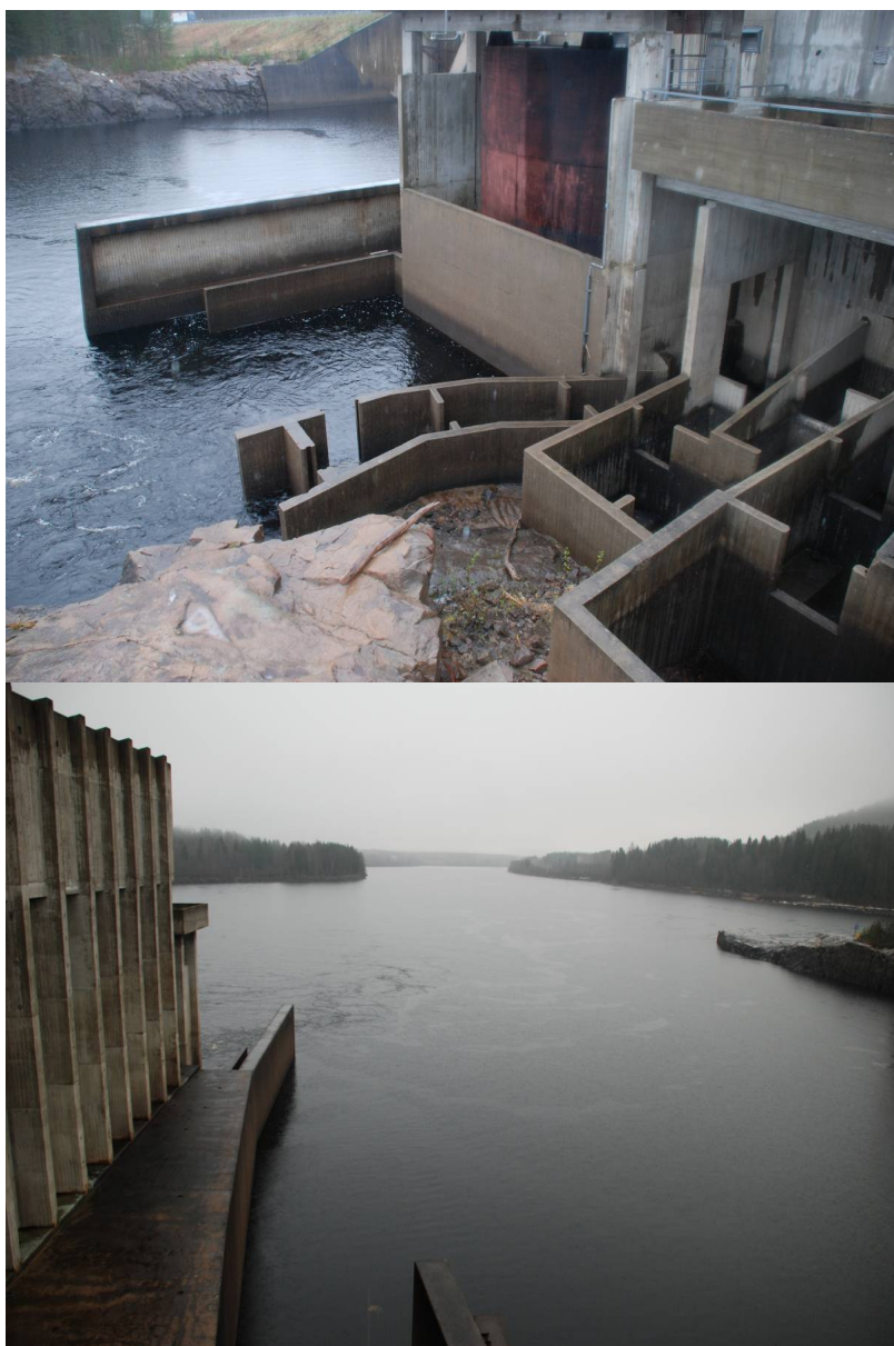
Bilde 3 Braskereidfoss kraftverk: Fiskeoppgangen er konstruert med flere fiskeinnganger for å øke funksjonaliteten ved vannstandsendringer (øverst). Turbinutslaget og fiskeinngangen er samlokalisert, og gir markant attraksjonsvann i et bredt elveleie (nederst). Foto: M. Kraabøl.
