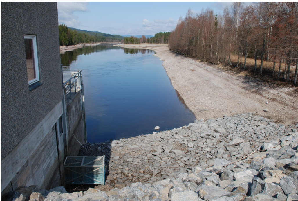
Bilde 8 Fiskefella er montert ved vanninntaket til fisketrappa. Bildet ble tatt om våren da Storsjøen var helt nedtappet. Foto: M. Kraabøl.
