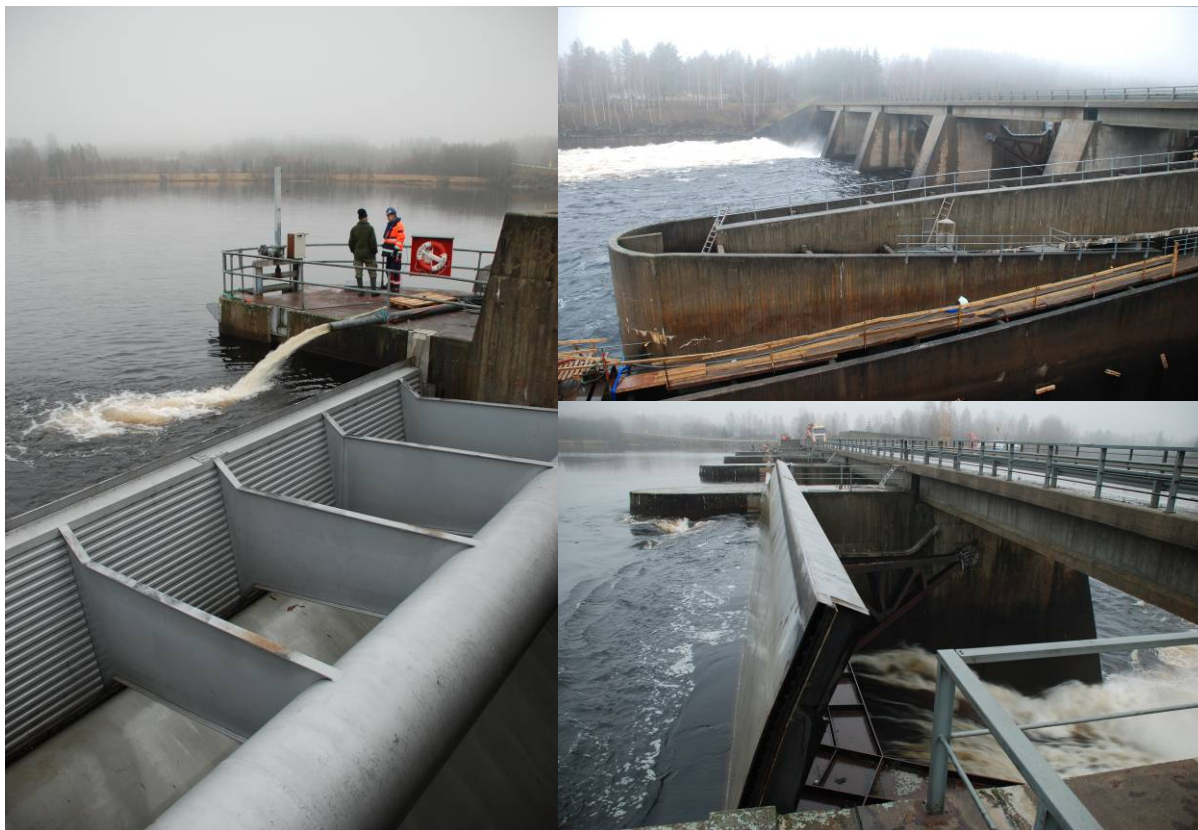
Bilde 2 Kongsvinger kraftverk: Ombygd tømmerluke med sektorluke på toppen (t.v.). Kulpetrappene går i en slynge nedenfor dammen (t.h. øverst). Taping av bunnvann gjennom løfte-luker er et problem for nedstrøms fiskevandring (t.v. nederst). Foto: M. Kraabøl.
