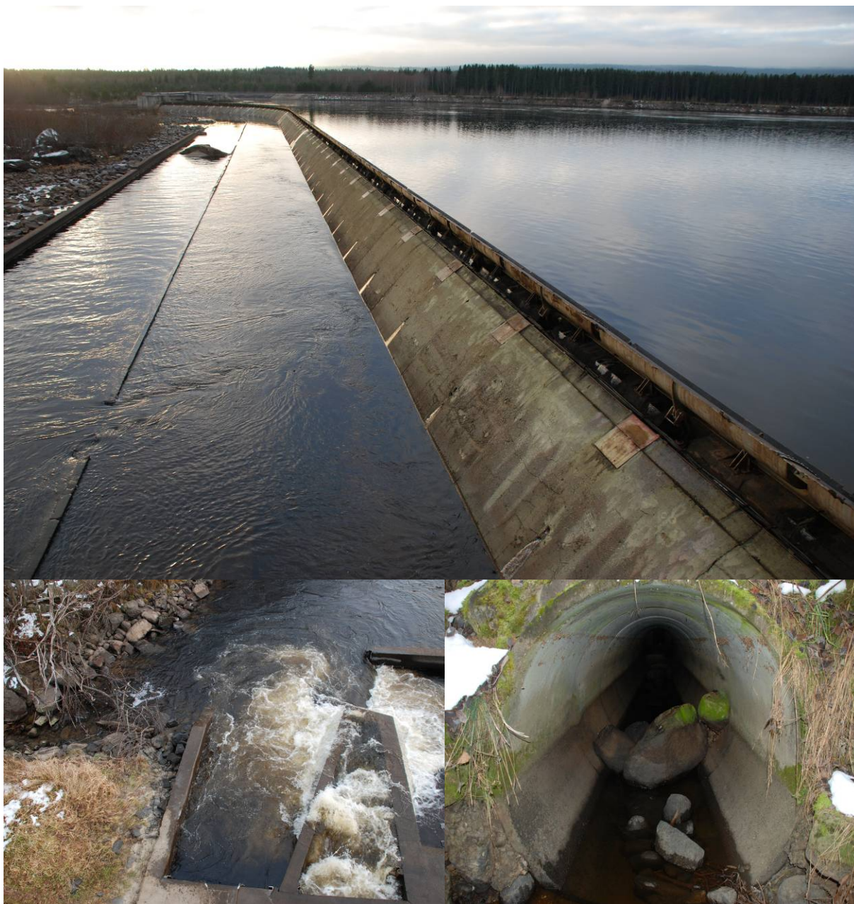
Bilde 10 Strandfossen: Overløpsterskelen med klappeluker (øverst). Utslag av driftsvann fra miniturbine ligger inntil fiskeinngangen til fiskepassasjen (t.v. nederst). Inngangen til det 22 m lange og 150 cm brede betongrøret som leder fisken inn til kulpetrappene og fella. Steingrupper er lagt inne i røret for å skape standplasser for oppvandrende fisk (t.h. nederst). Foto: M. Kraabøl.
