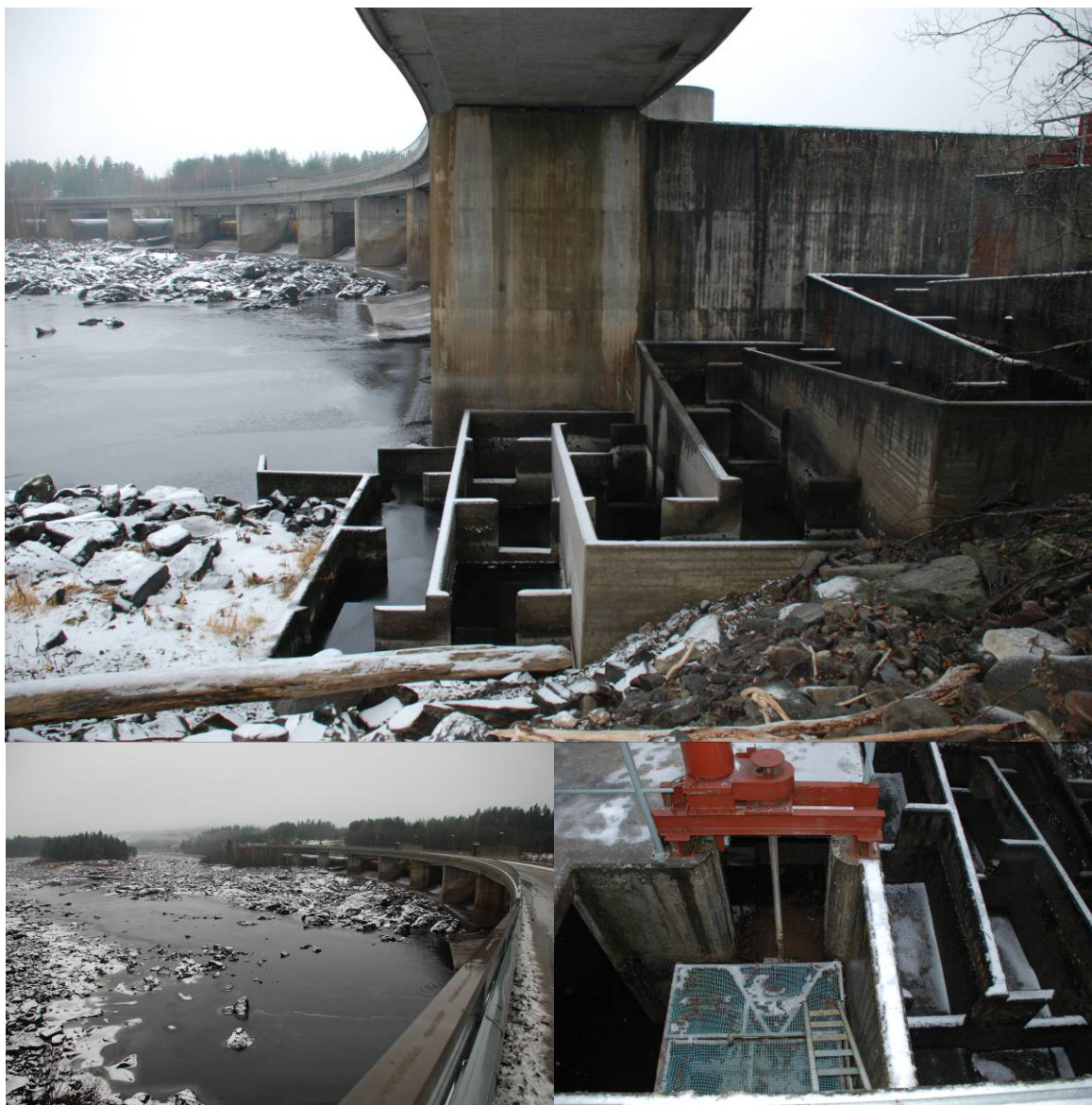
Bilde 4 Skjefstadvasskrafta: Fisketrappas fiskeinngang er lokalisert innunder damkrona på østsiden av elva (øverst). Øvre del av den 700 m lange minstevannføringsstrekningen (nederst t.v.). Fiskefella (nederst t.h.). Foto: M. Kraabøl.
