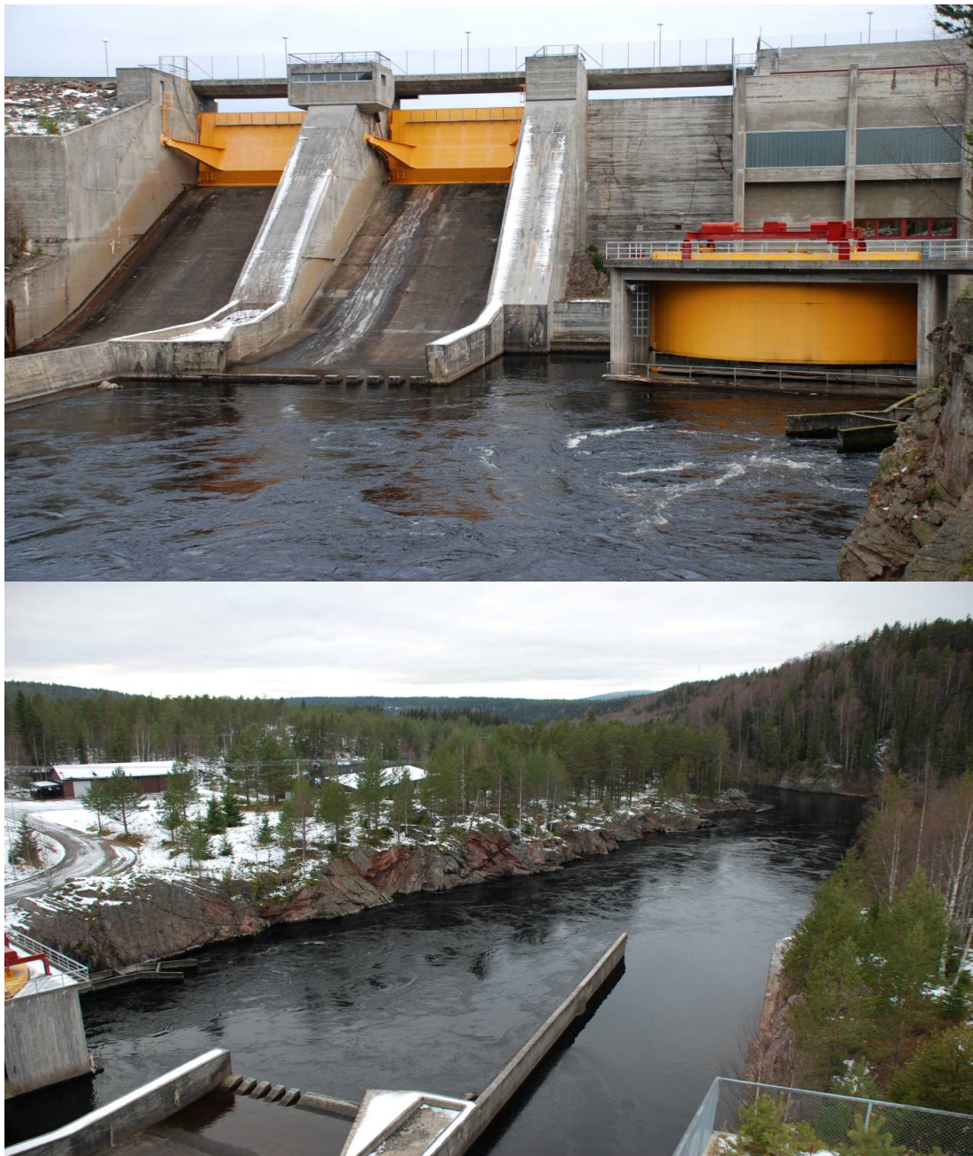
Bilde 6 Løpet kraftstasjon: De to flomlukene tapper kun bunnvann fra magasinet, og er lokalisert på motsatt side av turbininntaket. Trappas fiskeinngang er plassert i utslagssonen fra turbinene (øverst). Fiskeinngangens plassering i turbinutslaget gjør at fisk som søker oppover i elva ledes til trappemunningen når den følger hovedstrømmen. Unntaket er de korte periodene med slipp av overskuddsvann gjennom lukene på motsatt side av elven (nederst). Foto: M. Kraabøl.
