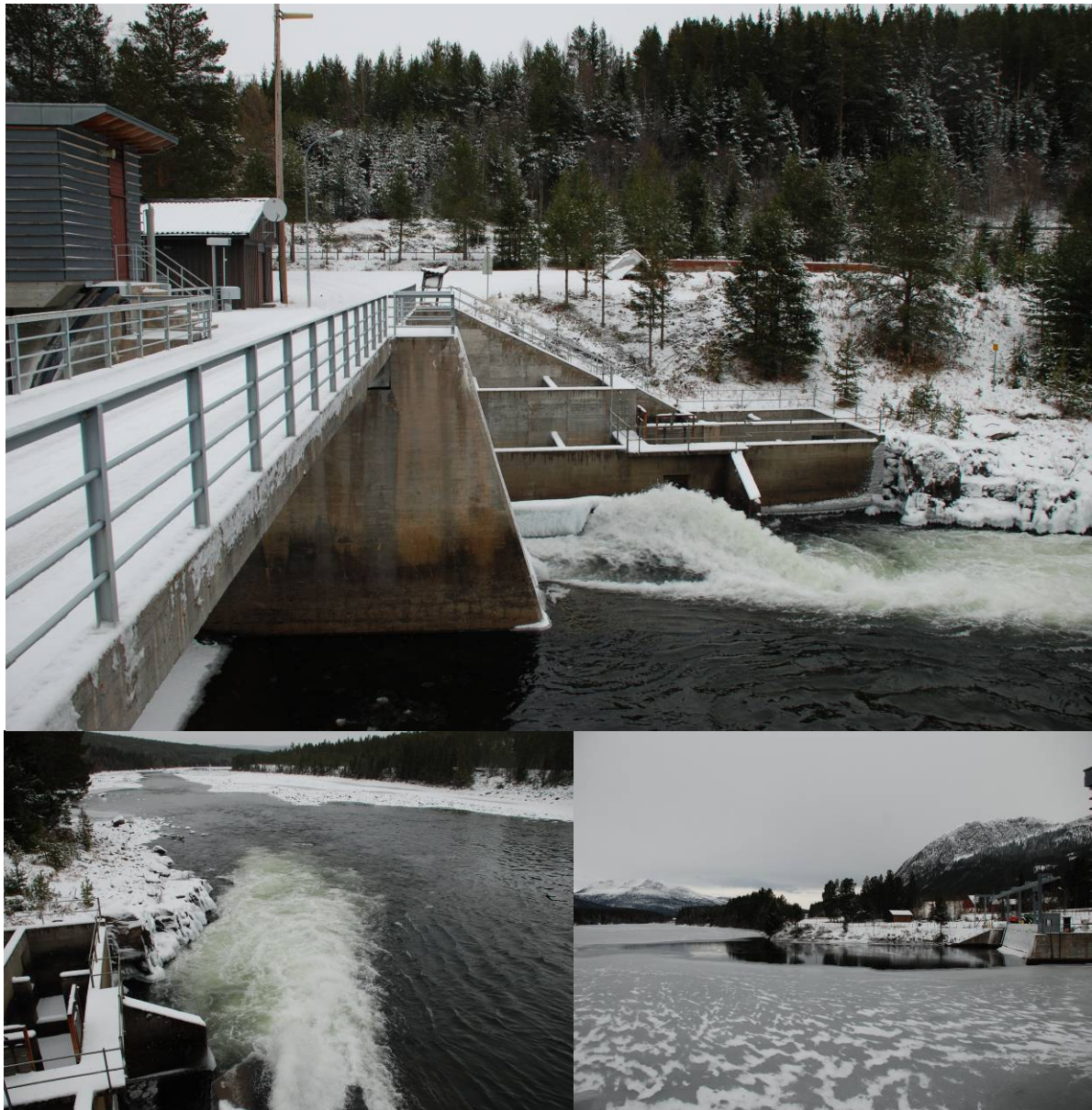
Bilde 11 Høyegga dam: Fisketrappa er lokalisert på østsiden av dammen, og minstevannføringen slippes gjennom en glideluke helt inntil trappen (øverst). Samlokaliseringen av fiskeinn- gang og markant attraksjonsvann gir optimale søke- og oppvandringsforhold for fisk (t.h. ne- derst). Inntaket til Rendalsoverføringen ligger i Høyegga dam, og medfører at Glomma mellom Høyegga og samløpet med Rena er en minstevannføringsstrekning (t.v. nederst). Foto: M. Kraabøl.
