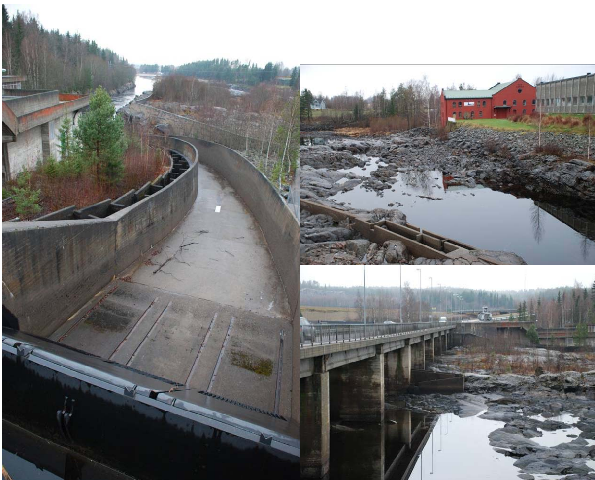
Bilde 1 Fisketrappene ved Funnefoss kraftverk. Fisketrappa og tømmerrenna går parallelt ned mot den utsprengte kanalen ved driftsvannsutslippet (t.v.). Trappesystemene på vestsiden av elva (t.h., øverst og nederst). Foto: M. Kraabøl.
