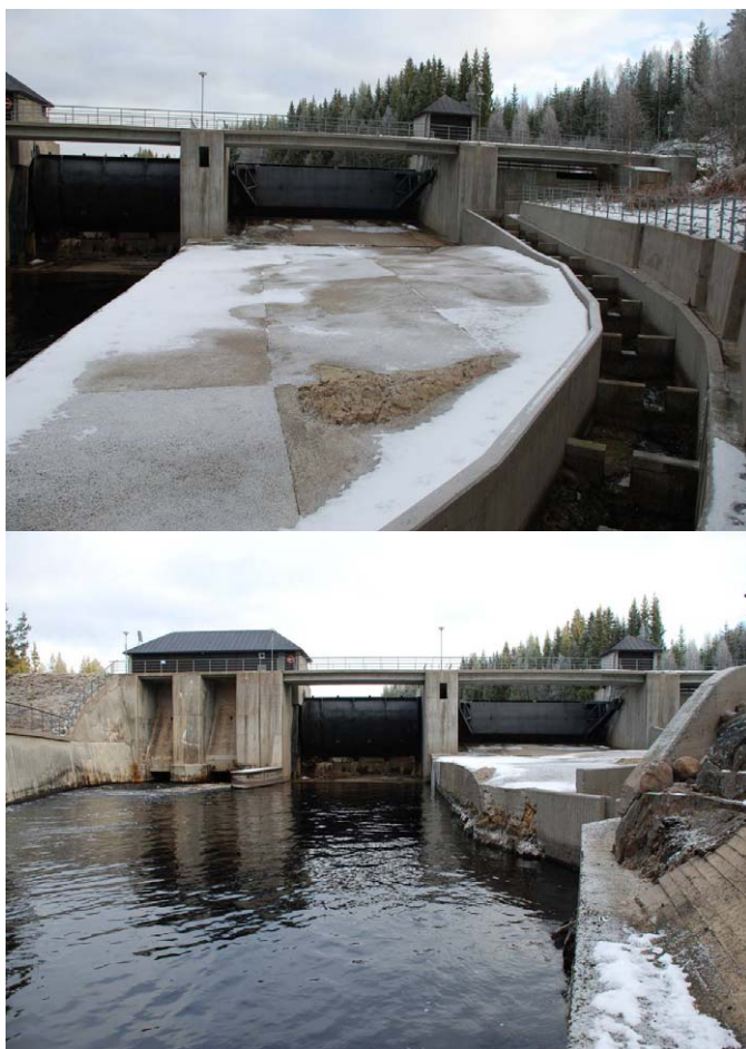
Bilde 5 Valmen i Søre Osa: Kulpetrappa er den minste i vassdraget, men kun 47 cm brede skår mellom kulpene (øverst). Fiskeinngangen er lokalisert flere titalls meter nedenfor dammen, og på motsatt side av minstevannføringsslipet. Dette er en lite gunstig kombinasjon. Foto: M. Kraabøl.
