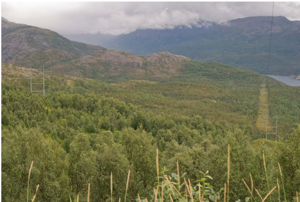
Bilde 1. Effekten av hogstgater. Bildet er tatt fra nord mot sør. Mot Rombaksfjorden. I venstre kant av bildet ligger dagens 420 kV-ledning uten hogstgate fra Ofoten transformatorstasjon. I høyre kant ligger en 132 kV-ledning med hogstgate.
