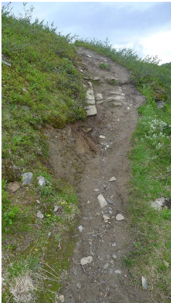
Figur 5.6. Der stien passerer krappe kneiker eller brinker er det fare for erosjon når vegetasjonsdekket slites og det kan oppstå utvasking og redusert framkommelighet over tid.
