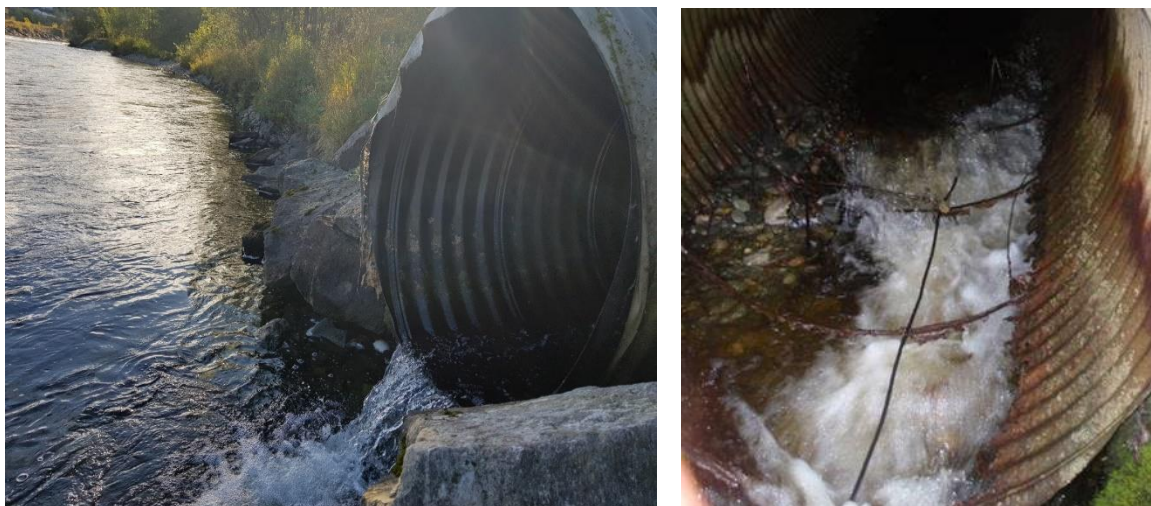
Bilde 32. Venstre: Selv når Orkla går med vannføring over middels som her på undersøkelsestidspunktet i 2017 er det litt for stort sprang opp til kulvert i utløp av Tonga. Høyre: Kulvert gjennom forbygning der med Tunga munner ut i Orkla i 2010. Jernstenger gjorde det da tilnærmet umulig for fisk å vandre opp i vassdraget. Foto: Øyvind Solem (venstre) og Morten Andre Bergan (høyre)
