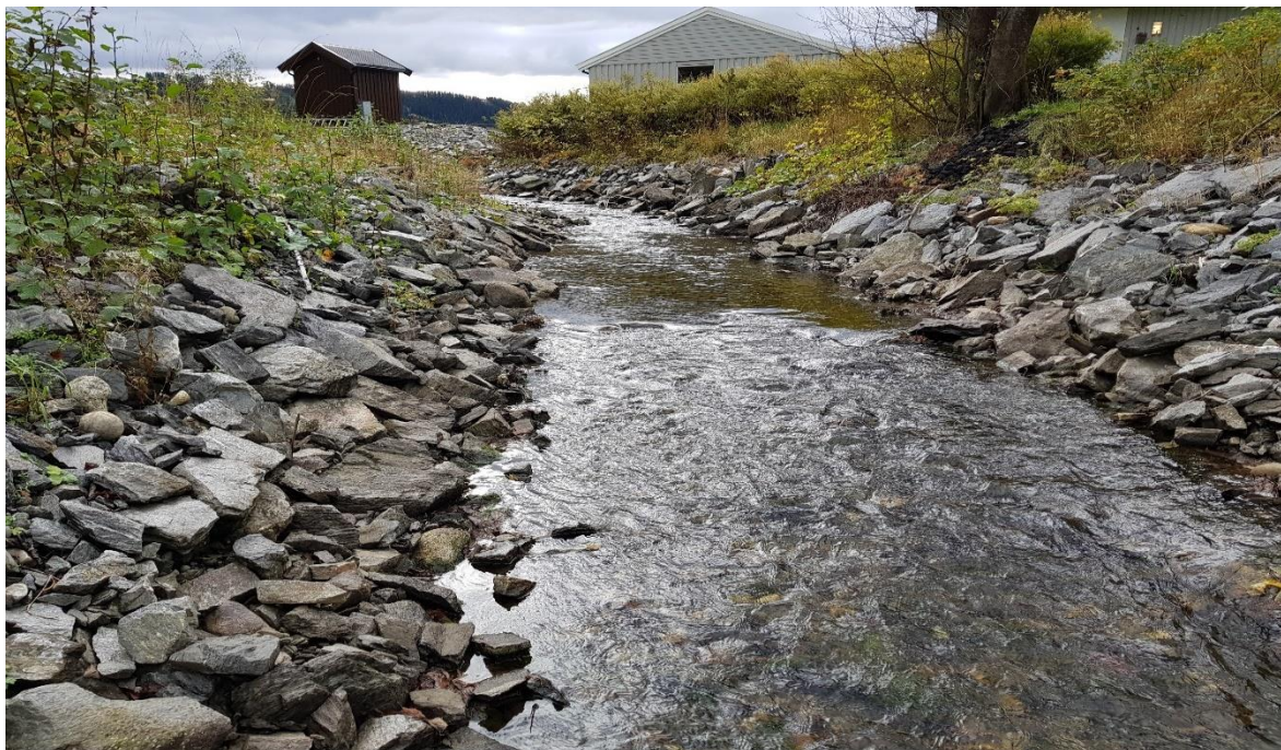
Bilde 18. Nederste elfiskestasjon (6a) i Sola ligger fra ca. midt i bildet og oppover rundt svingen til venstre. Sider og deler av elvebunn bar preg av å nylig blitt steinsatt, i tillegg til at kantvegetasjon var fjernet. Foto: Øyvind Solem.
