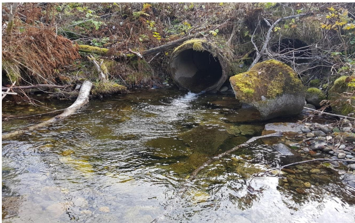
Bilde 63. Kulvert under skogsbilvei ved Skugglia. Kulverten er uhensiktsmessig utformet med tanke på å sikre tilfredsstillende forbivandring av laks og ørret. Foto: Øyvind Solem.
