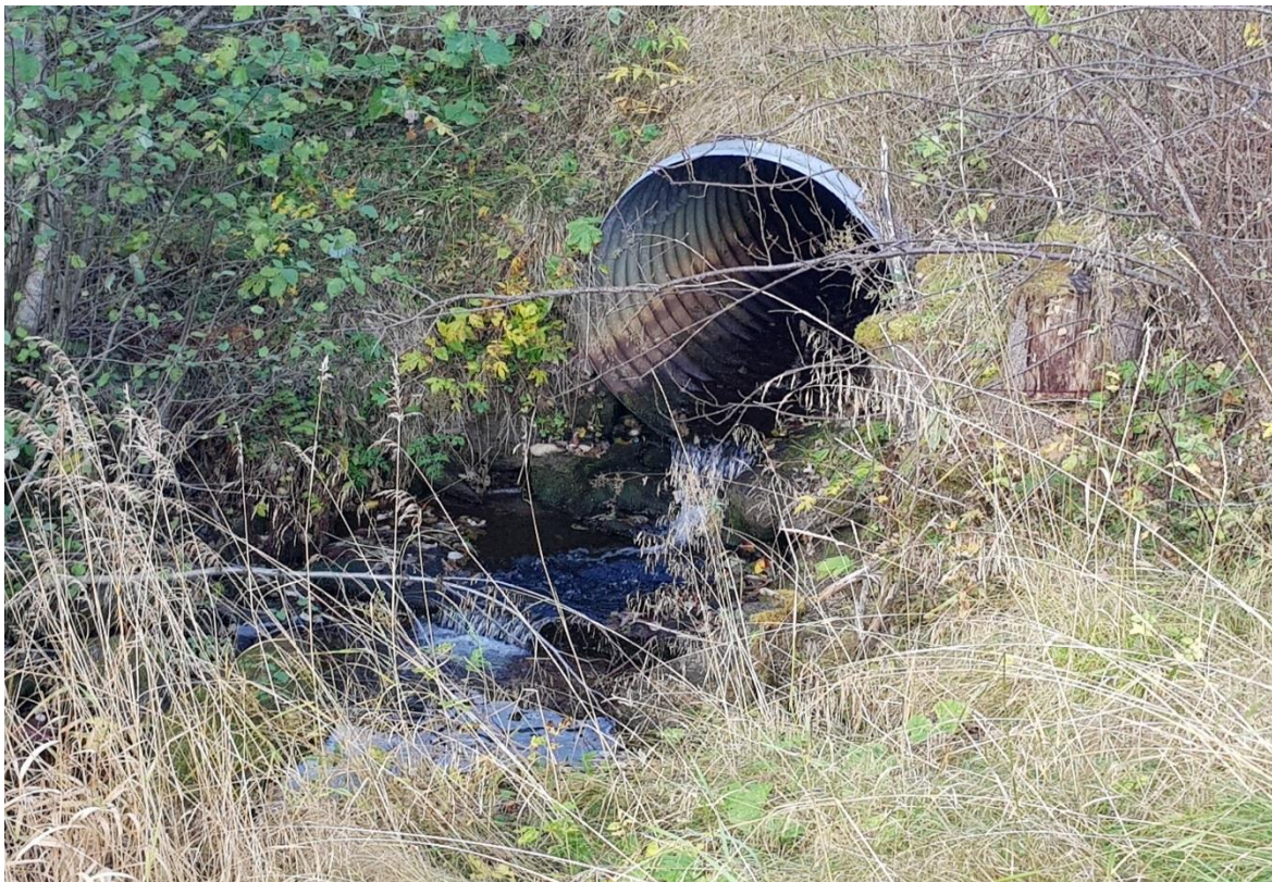
Bilde 35. Utløp av kulvert under Raudkleivvegen. Det er trolig vanskelige oppvandringsforhold for fisk ved de fleste vannføringer. Foto: Øyvind Solem.
