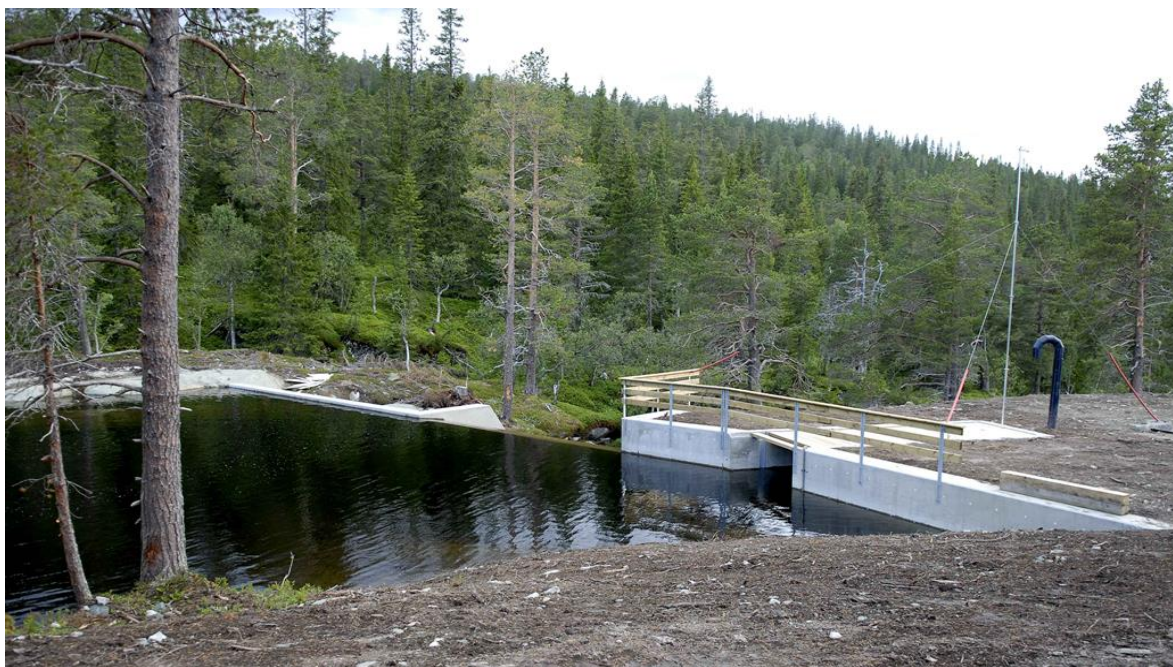
Bilde 58. Demning i Gautvella. Synlig overløp ved demningen og inntak til kraftverk. Foto hentet fra http://www.fadumtekniske.no .
