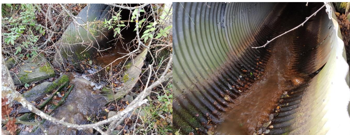
Bilde 13. Kulvert i Mobekken under Blåsmovegen. Trolig er passering av denne problematisk både på høy og lav vannføring. Foto: Øyvind Solem.
