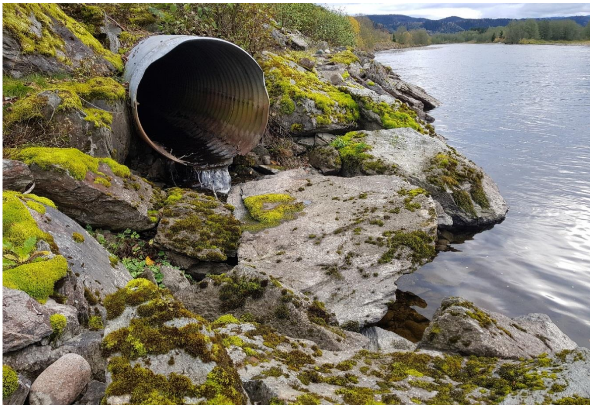
Bilde 14. Utløp til Orkla for bekk som kommer fra Langdalen. Under befaring høsten 2017 var det lav vannføring i bekken og Orkla må trolig være stor for at fisk skal kunne vandre opp i vassdraget. Foto: Øyvind Solem.
