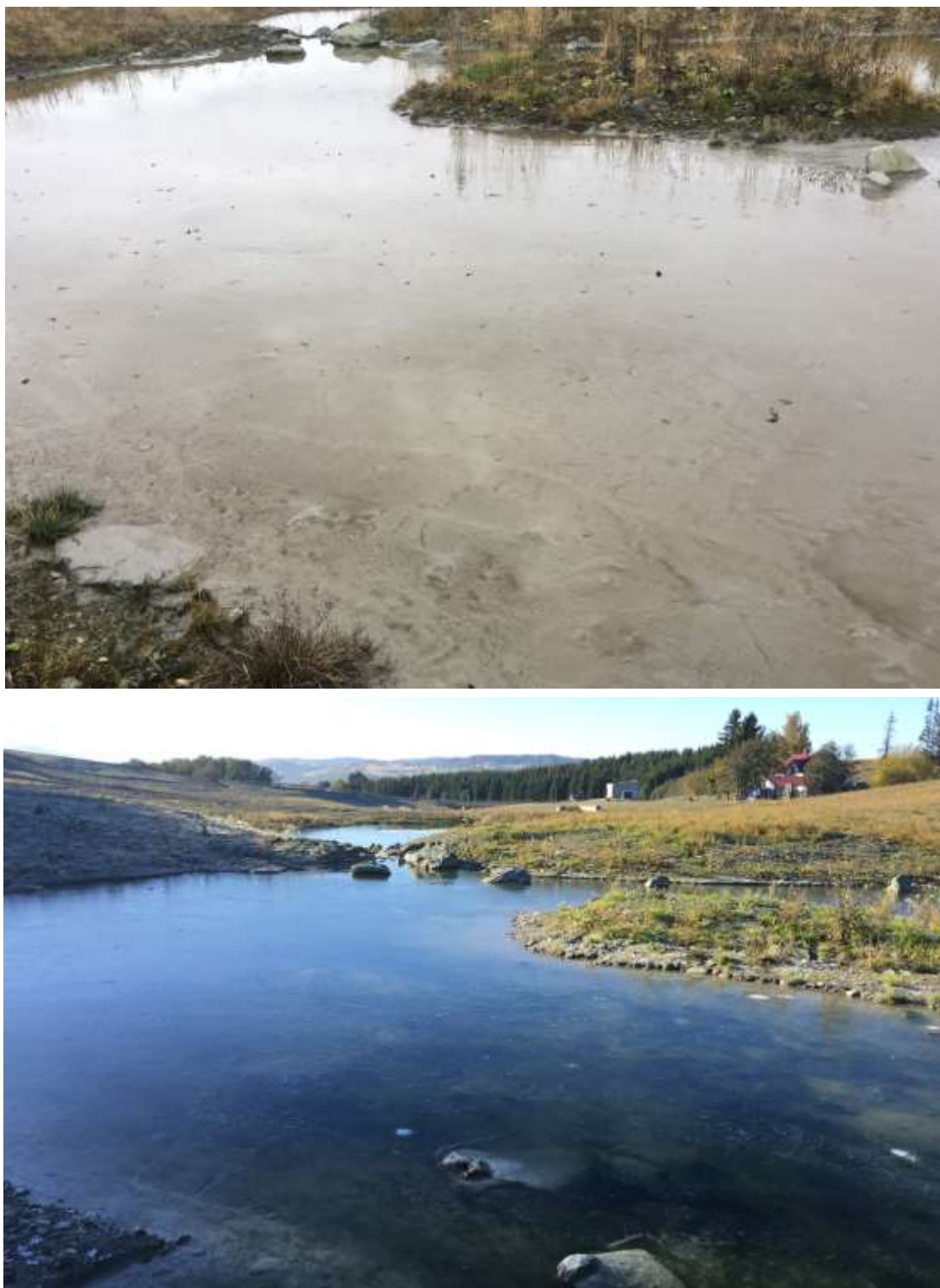
Figur 28. Sedimentasjonsbasseng i Heggstadbekken er fylt opp av silt og leire fra anleggsarbeid og lignende aktiviteter lenger oppe i nedbørfeltet. Kun et par cm vanndybde i dag (øverst), mot opp mot 30-40 cm vanndyp året før (foto 13. oktober 2016). Foto: Morten Andre Bergan.
