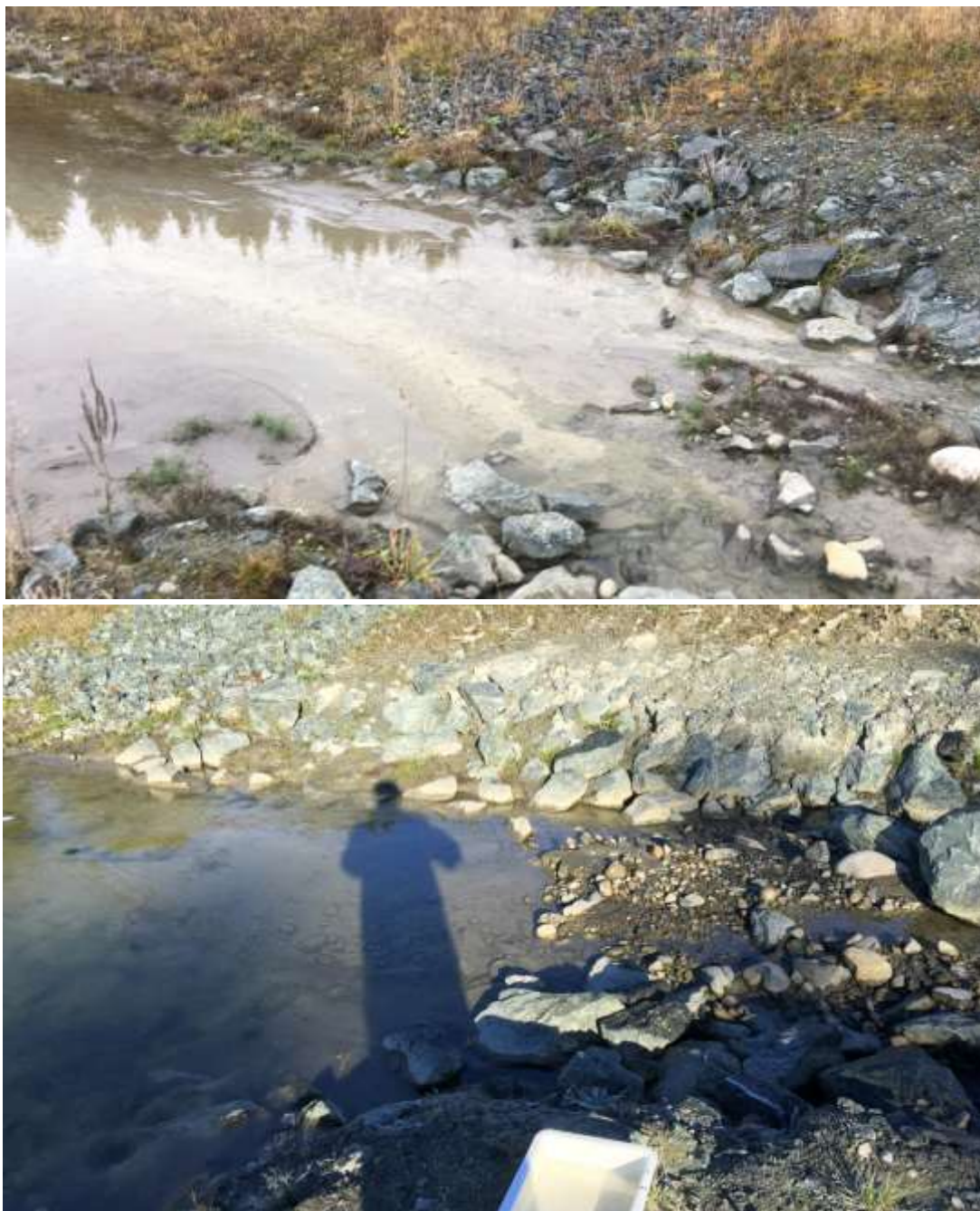
Figur 27. Innløp til sedimentasjonsbasseng i Heggstadbekken. Bassenget er i dag fylt opp av silt og leire fra anleggsarbeid og lignende aktiviteter lenger oppe i nedbørfeltet (øverst). Situasjonen var helt annerledes året før (nederst, foto 13. oktober 2016). Foto: Morten Andre Bergan.
