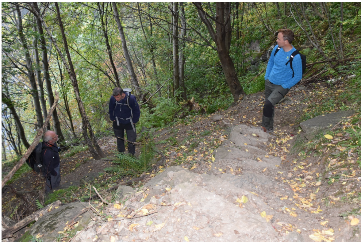
Figur 4.5 Stien opp frå fjorden til Skageflå er for ein stor del steinsett og godt sikra mot erosjon og avrenning, men på enkelte korte strekningar er det finare substrat der det kan bli auka slitasje og utvasking ved auka bruk.
