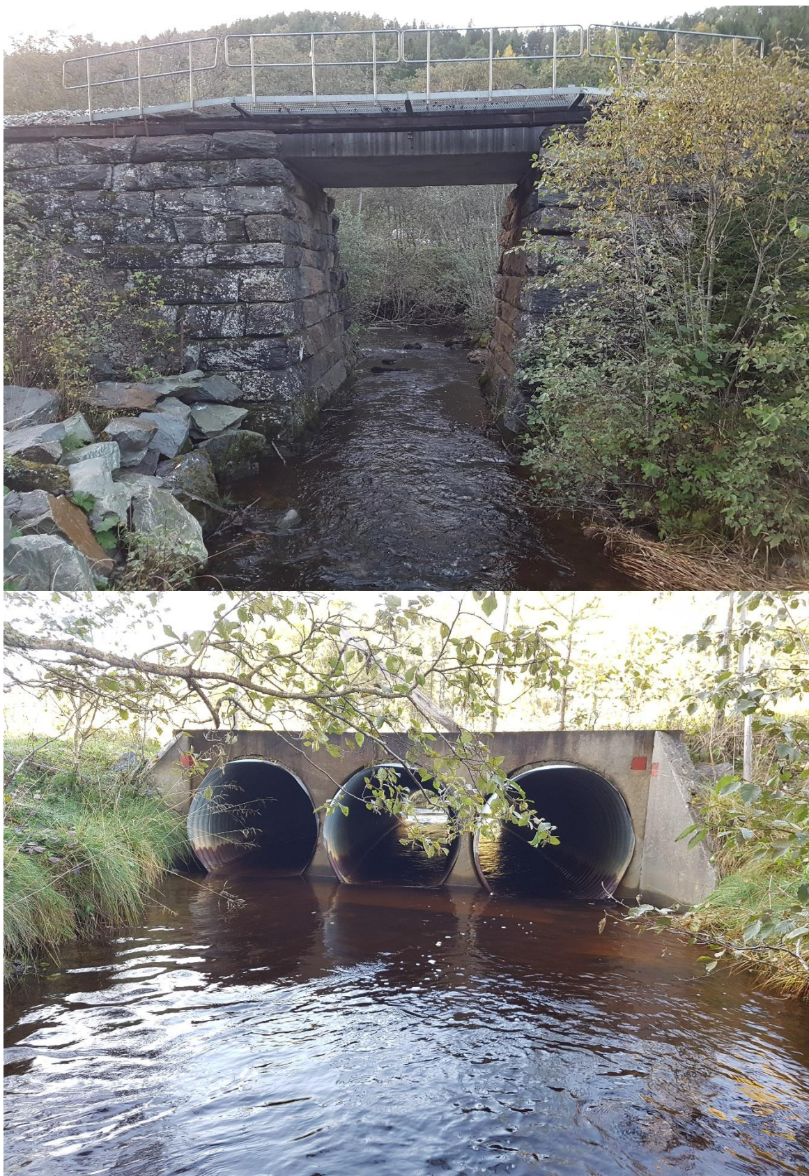
Bilde 13 og bilde 14. I området der jernbanen krysser Fættenelva er det på en kort strekning først en kunstig innsnevring av elveløpet (øverste bilde) før elveløpet er samlet i tre lange stikkrenner under en nylig etablert grusvei (nederste bilde). Foto: Eva Marita Ulvan.
