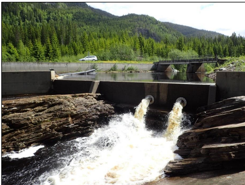
Foto 2. Inntaksdammen til Knutfoss kraftverk. Minstevannføringen forbi inntaket er 0,4 m 3 /s hele året. Foto: Bjørn Mejdell Larsen.
