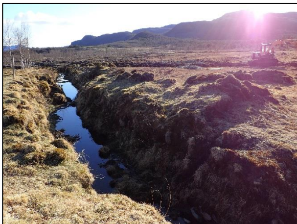
Foto 35-36. Grøfting av myr langs Vollaelva. Myrjord og finpartikulært materiale blir ført ut i elveløpet og legger seg opp i elvekanten før det vaskes videre nedover Vollaelva. Foto: Bjørn Mejdell Larsen.
