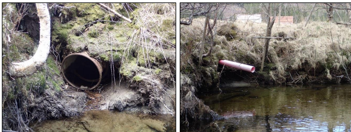
Foto: 31-32. Drensrør gjennom dyrka mark ledes som oftest helt fram til elveløpet. Foto: Bjørn Mejdell Larsen.
