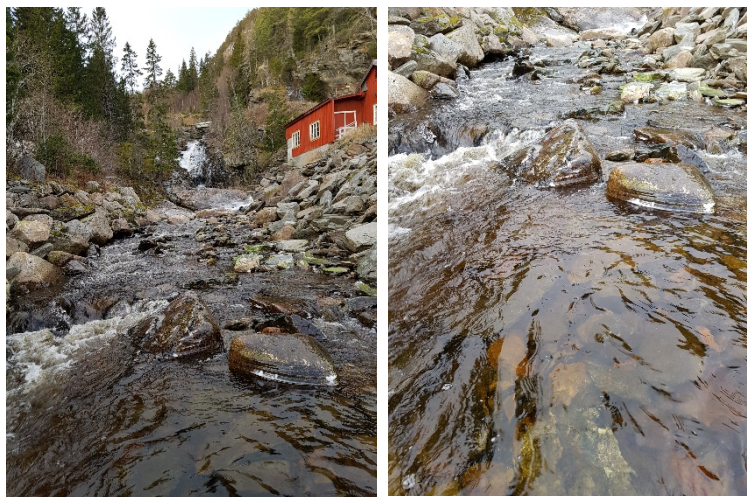
Utløpskanalen med grov skytestein.
