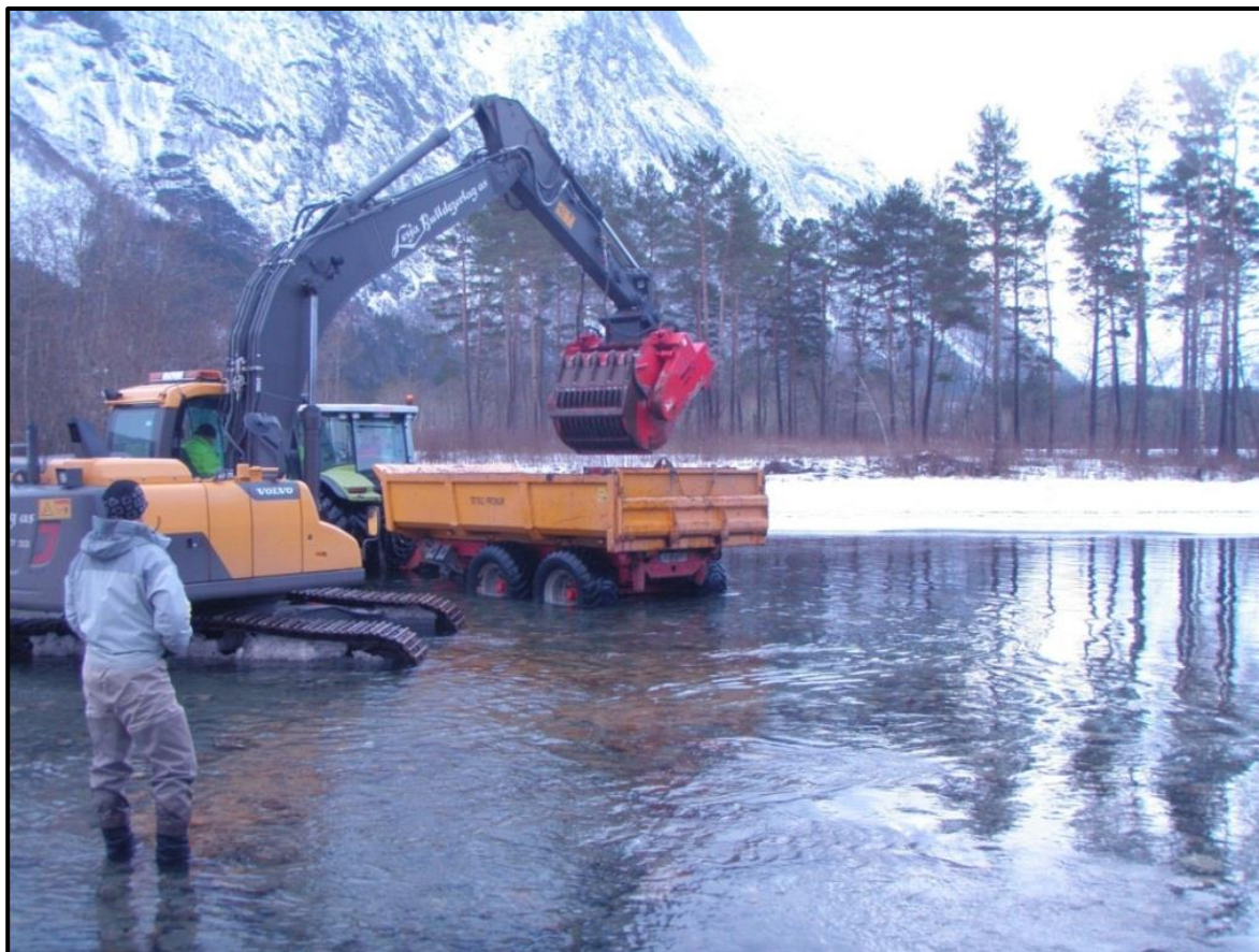
Bilde 1. I mars 2013 ble det benyttet beltegraver med sorteringsskuffe for å fjerne finsedimenter fra elvebunnen i to områder av Eira. Foto: Nils Arne Hvidsten.
