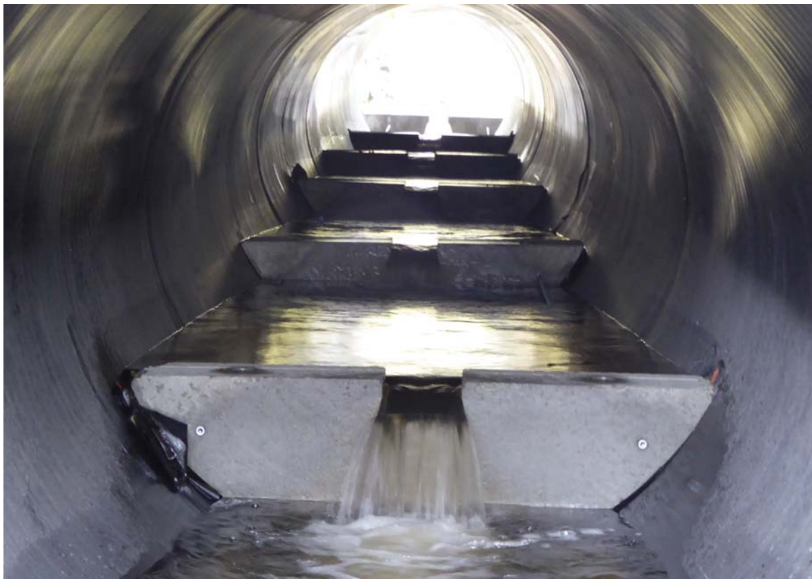
Figur 25. Potensiell løsning på terskelbasert fisketrapp, her plassert i et større drenerør. Foto: Hans Petter Fjeldstad, Sintef.
