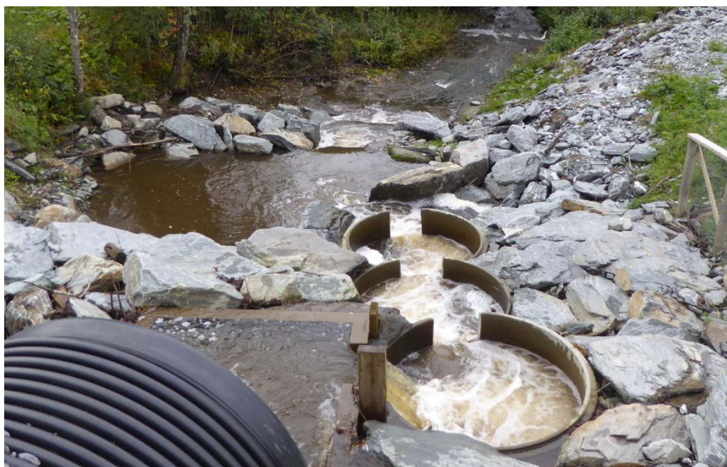
Figur 24. Foto som viser en mulig løsning mht. utformingen av en fisketrapp. Eksemplet er hentet fra en bekk i Nord Trøndelag med vanskelige oppgangsforhold i forbindelse med en veikrysning. Foto: Hans Petter Fjeldstad, Sintef.
