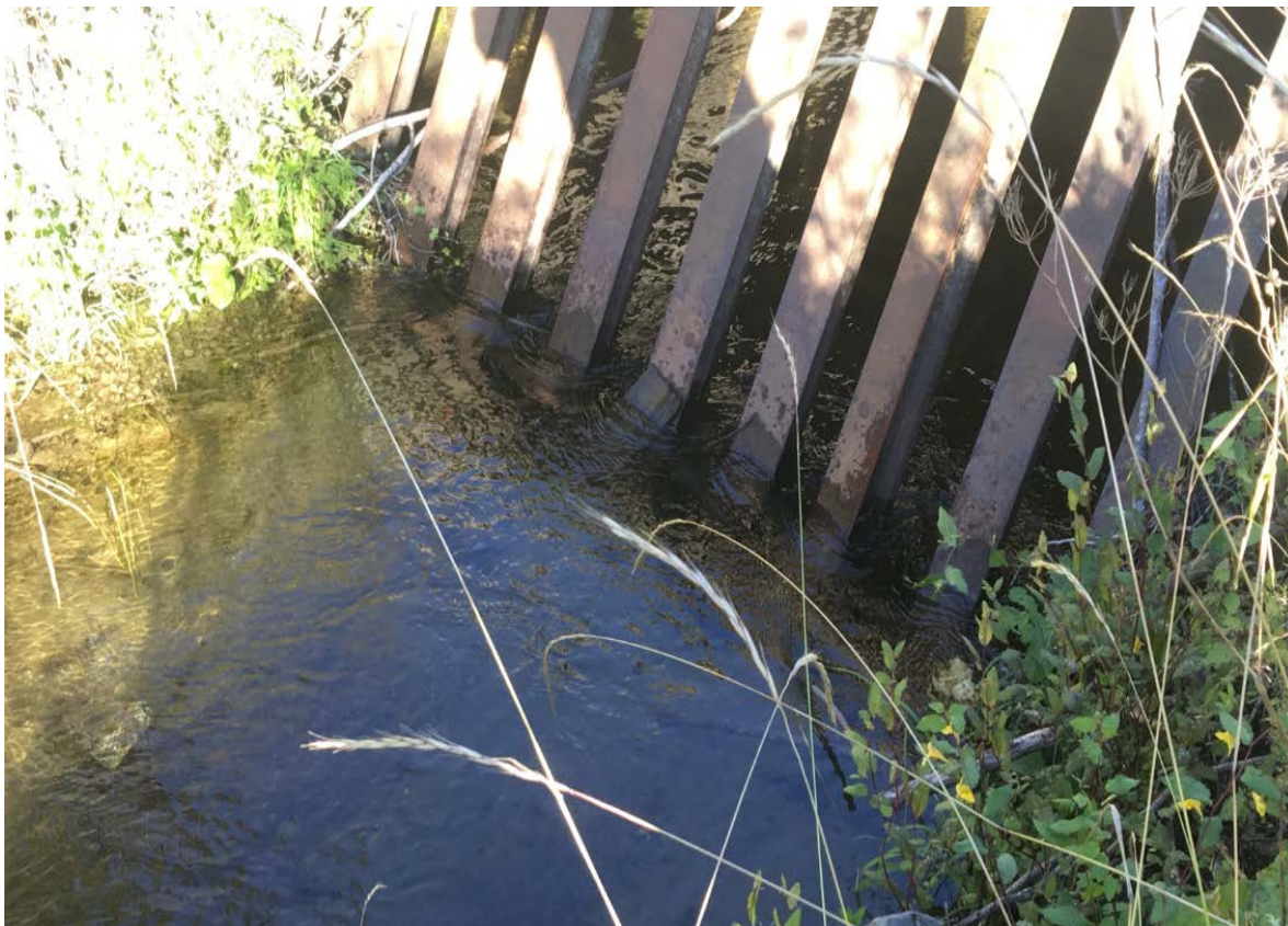
Figur 16. Rista foran jernbanekulverten er rensket, slik som året før, og sjøørret opp til en viss størrelse kan passere fritt.
