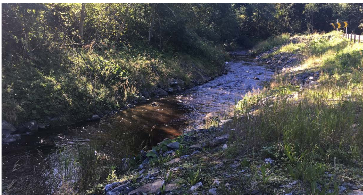
Figur 11. Møsta ved stasjonsområdet i nylig erosjonssikret strekning.
