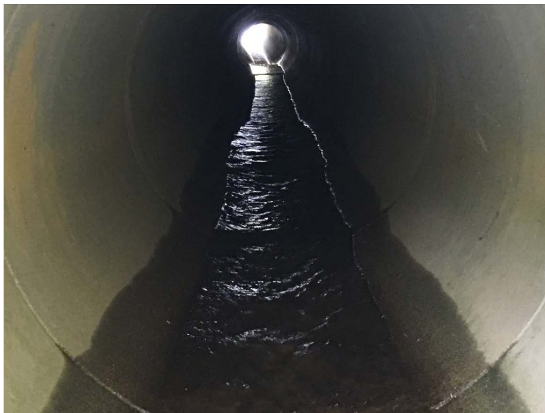
Figur 31. Vandringsstoppende kulvert under FV 30 i «Lille Remna».
