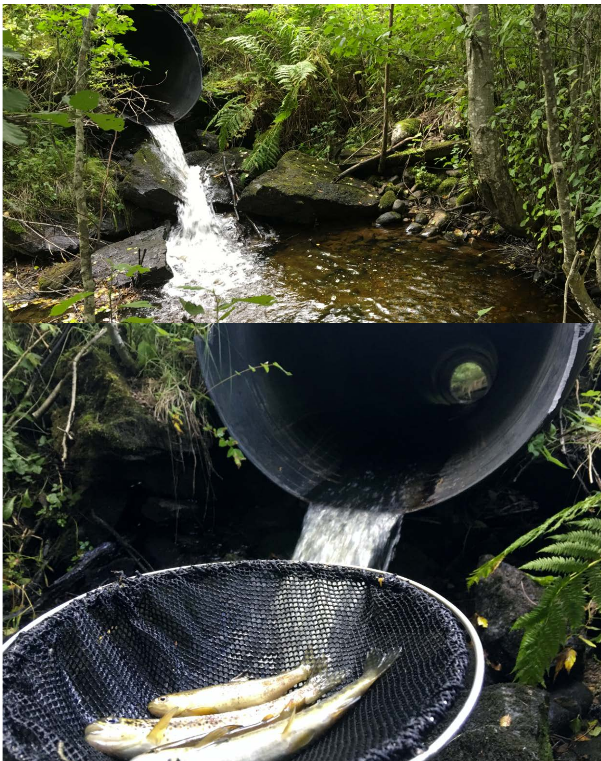
Figur 25. Kulvert i forbindelse med jernbane er vandringsstoppende for anadrom laksefisk.
