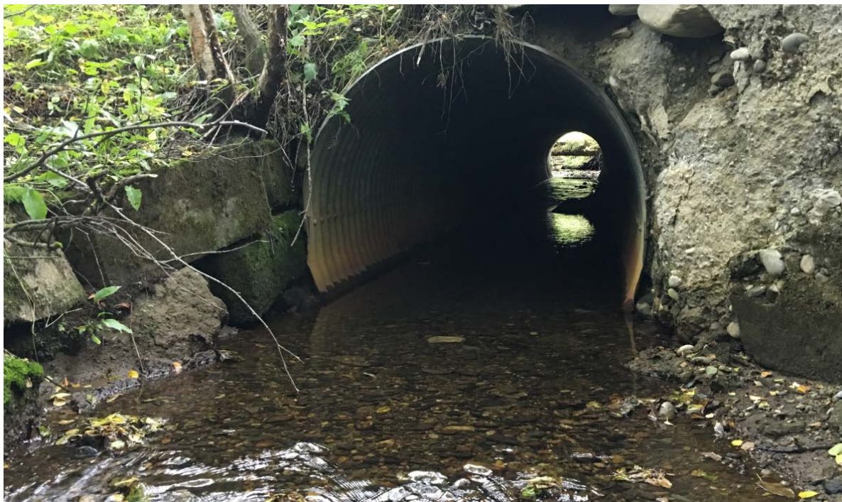
Figur 26. Kulvert under Fv 30 er godt egnet for fiskevandring.
