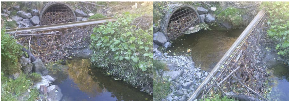
Figur 6. Nedre jernbanekulvert og stengsler i Langbekken før tiltak. Foto fra høsten 2015.
