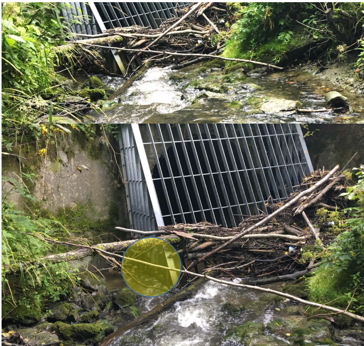
Figur 8. Kulvert under E6 i Langbekken går snart tett, og har underdimensjonert avstand mellom vertikale stolper. En nødløsning inntil problemet er løst kan være å kutte vekk disse i området avmerket med sirkel i bildet, slik at stor og små gytefisk slipper enkelt forbi. Foto fra høsten 2016.
