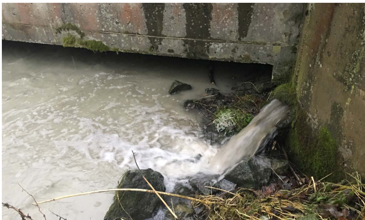
Figur 2. Lekkasje av kloakk i perioder med nedbør. Utslippet kommer fra nærliggende pumpehus ved Eggbekken, like ovenfor stasjon 2a.
