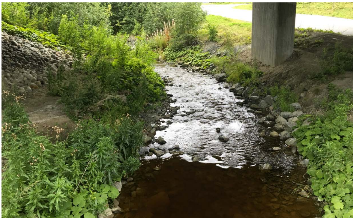
Figur 4. Utelukkende bruk av skuttstein i Ratbekkens steinsatte bekkeløp gir dårlig egnethet for gyting av sjørret, samtidig som store mengder rund elvestein er deponert under brua (øverst til venstre i bildet).
