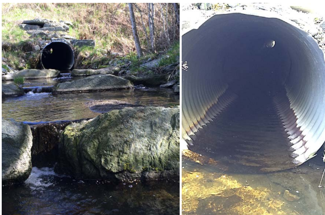
Figur 3. Tiltaksstrekning nedstrøms Fv 7070 (t.v.), og ukurant kulvert under veien (t.h.).
