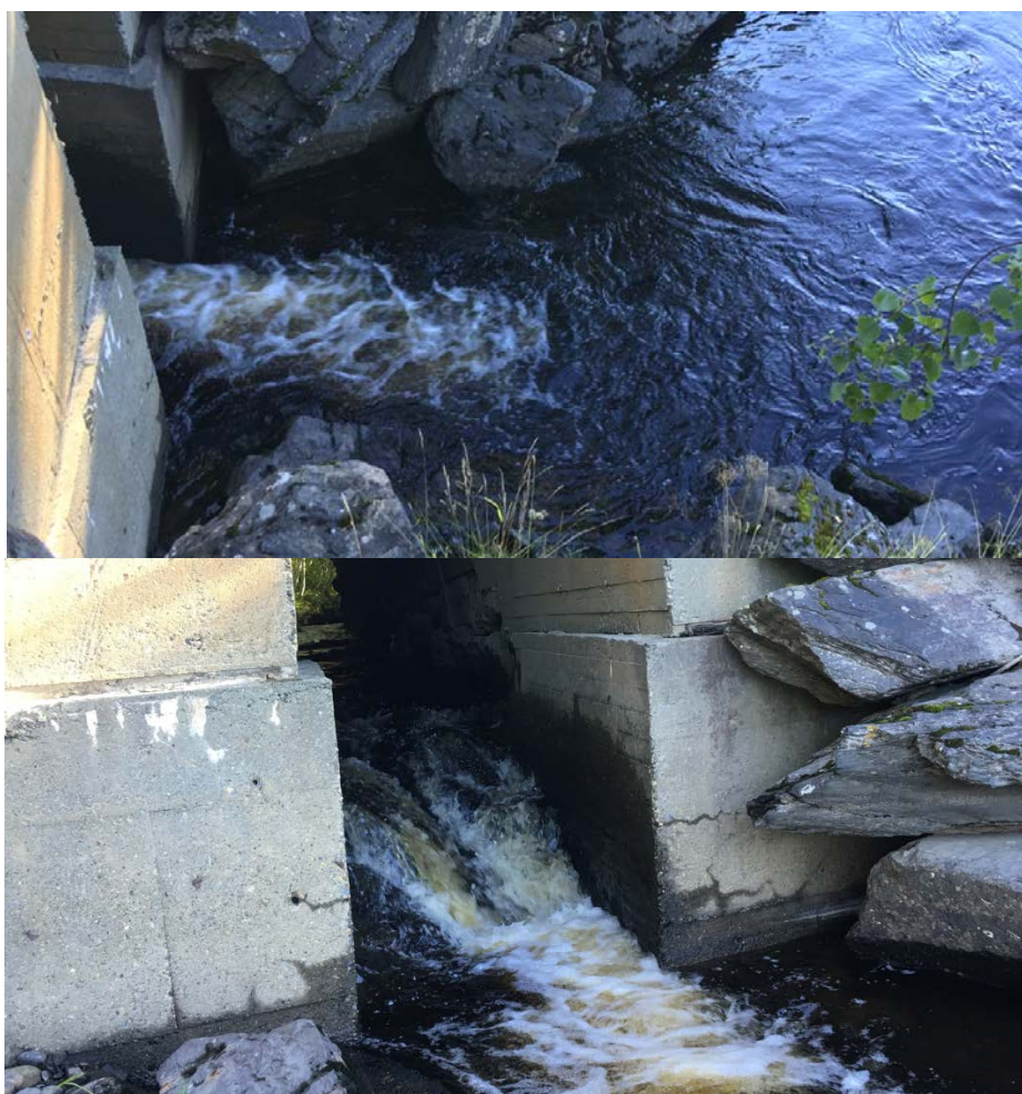
Figur 14. En av de største risikofaktorene for sjørretbestanden i Gyllbekken de siste tiårene har vært veikulverten under E6. Her avfotografert på en vannstand i Gaula (ca 100-150 m 3 /s) som gjør det mulig å svømme forbi.
