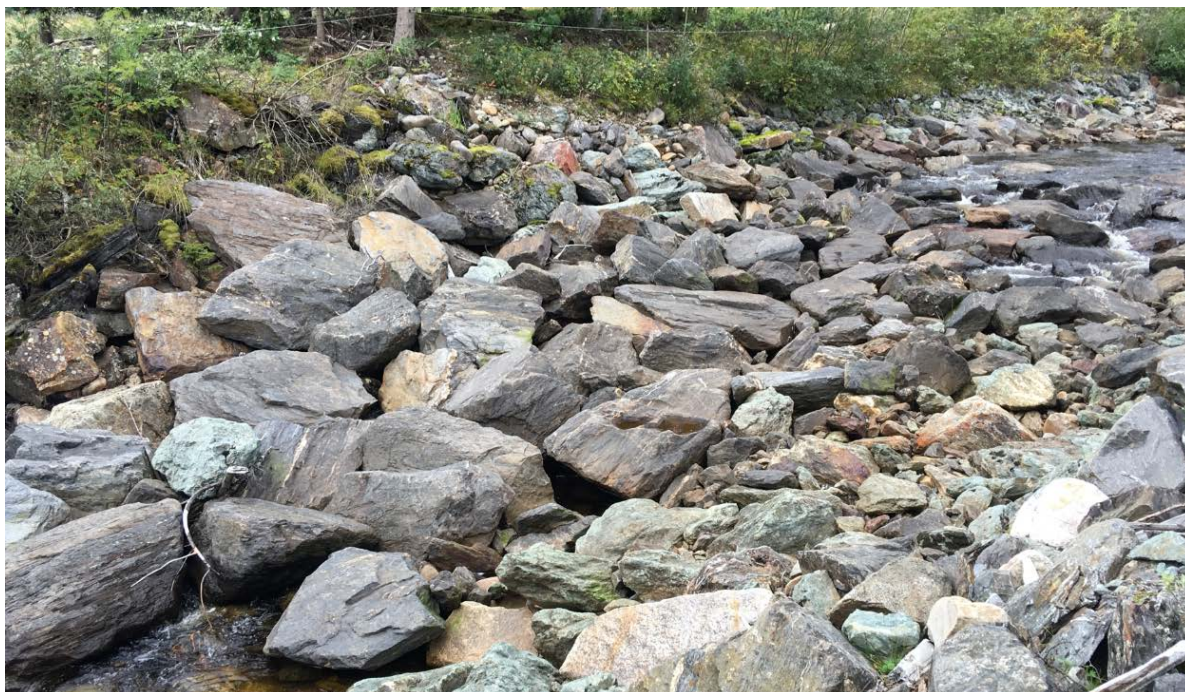
Figur 21. Sikret strekning av Sevilla. Elva forsvinner i elvebunnen over et parti på flere titalls meter på normale vannføringer.
