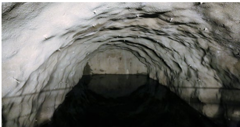
Fjellrom med vannspeil i bunnen. Omtrent slik ser det ut inne i et luftputekammer. Foto: Ånund Killingtveit
