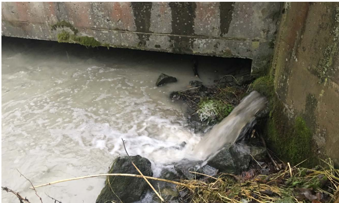
Figur 25. Lekkasje av kloakk i perioder med nedbør. Utslippet kommer fra et nærliggende pumpehus ved bekken, like ovenfor stasjon 28.
