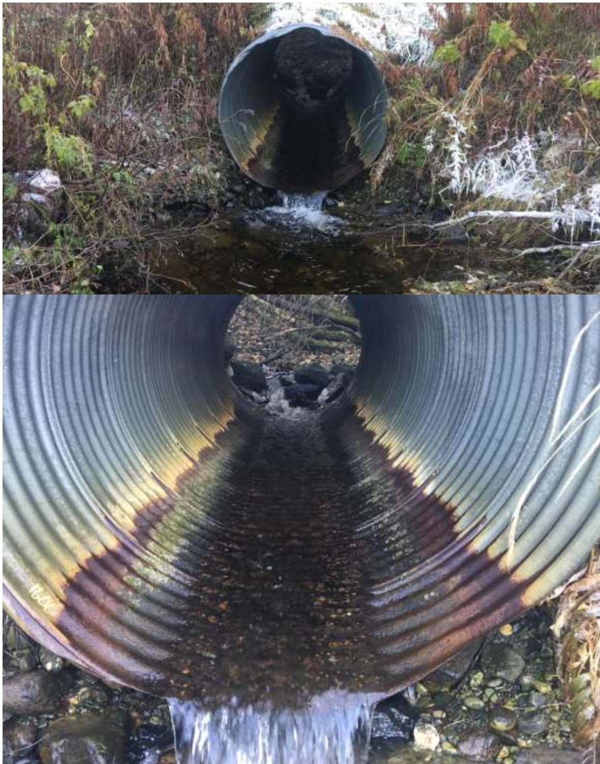
Foto 39: Kulvert under traktorvei i nedre del av Storsandbekken hindrer oppgang av gytefisk.
