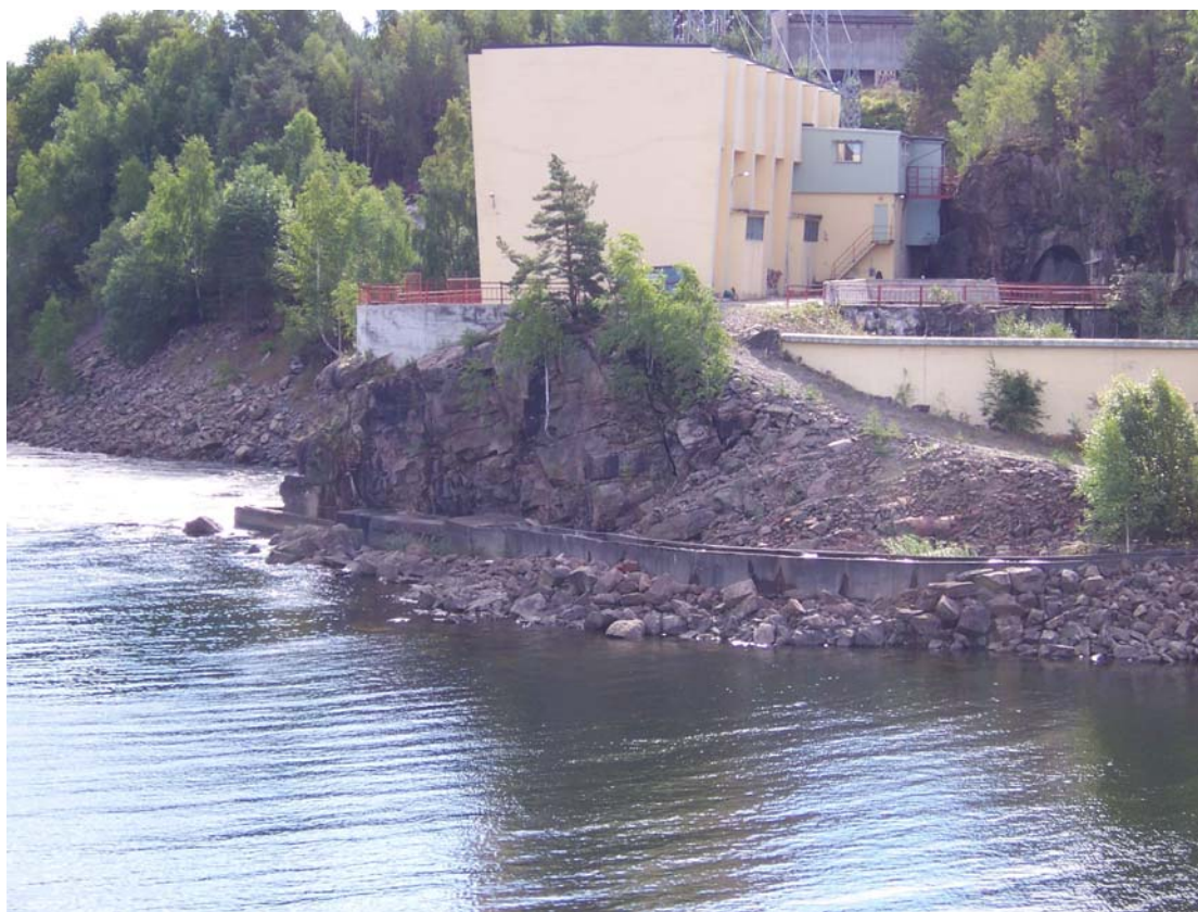
Dagens kraftverksbygg i Skotfoss med utløp til venstre og fisketrapp midt på bildet. Foto: Torbjørn Forseth
