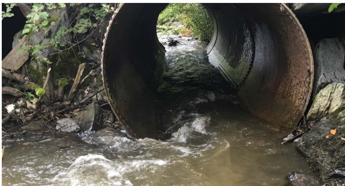
Figur 25. Nederste problemkulvert i Hofstadelva i 2016, etter utbedring av NINA. Fri vandrings- vei gjennom hovedrør. Foto: Morten Andre Bergan, NINA.
