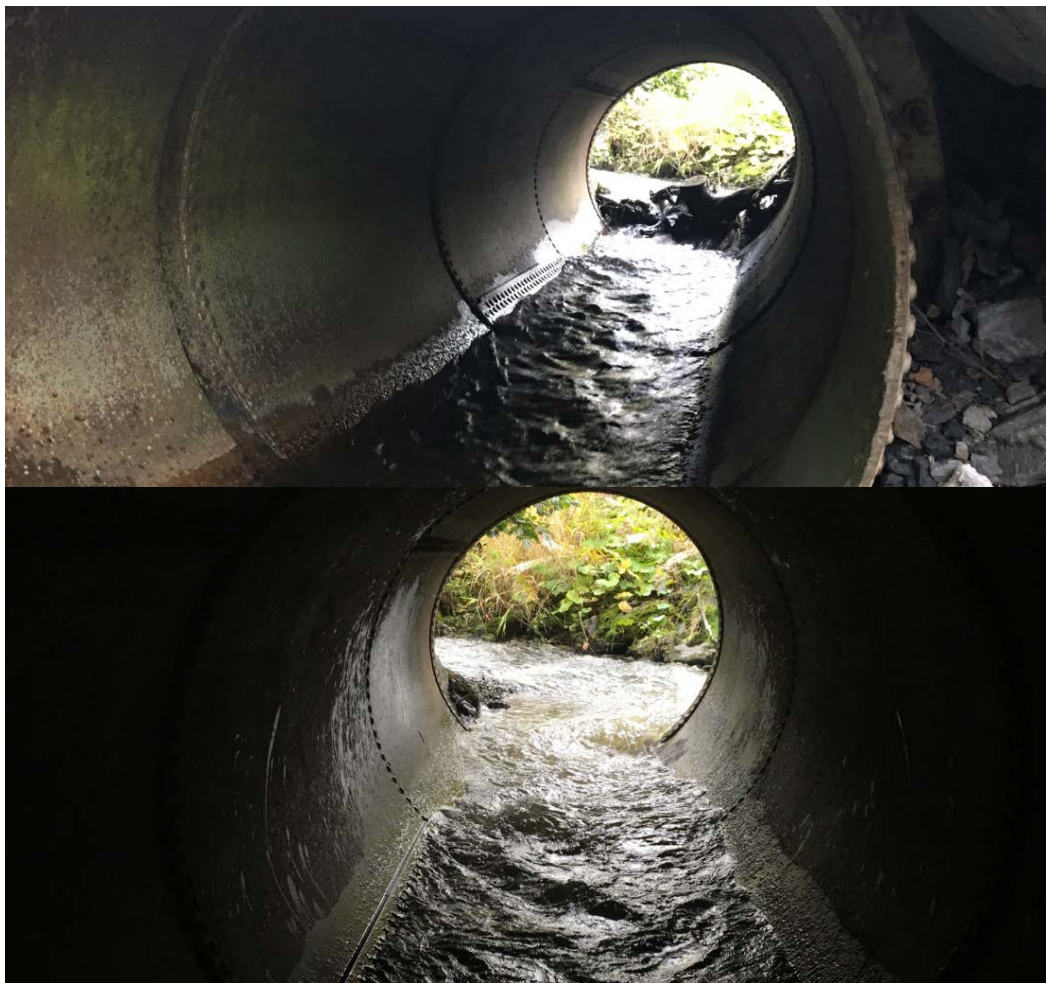
Figur 26. Nederste problemkulvert i Hofstadelva i 2016. Før (øverst) og etter (nederst) utbedring av NINA. Foto fra innside av kulvert og oppover. Foto: Morten Andre Bergan, NINA.
