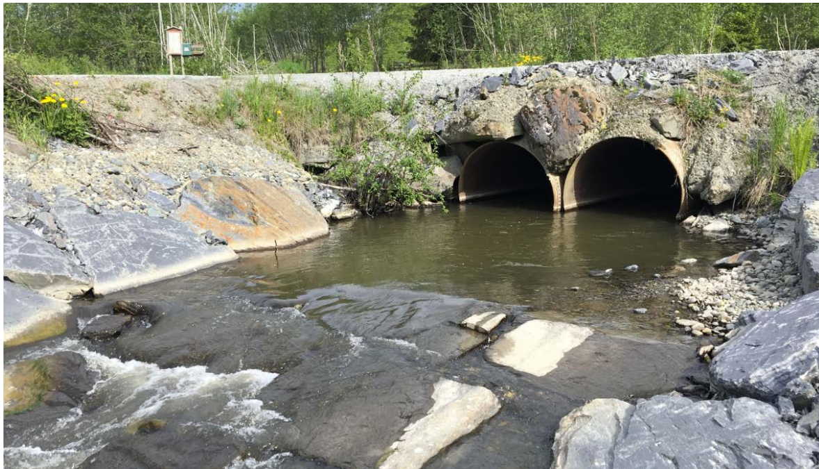
Figur 23. Problemkulvert i Hofstadelva i 2016, etter utbedring. Vesentlig forbedrede oppgangsmuligheter for både gytefisk og ungfisk, på et langt større vannføringsvindu sammenlignet med tidligere. Foto: Morten Andre Bergan, NINA.
