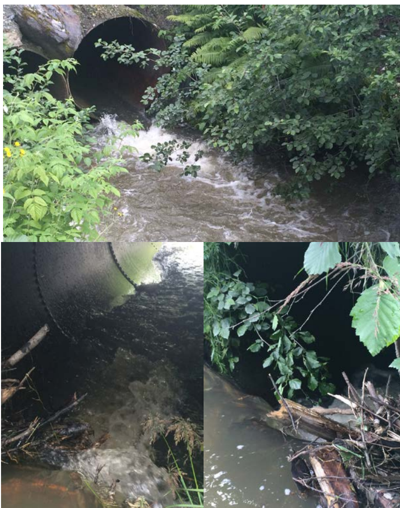
Figur 22. Problemkulvert i Hofstadelva, august 2015. Tilstoppet innløp (nederst), i tillegg til i utgangspunktet vanskelige oppgangsforhold for både stor gytefisk og små ungfisk, skapte en vandringsbarriere i forkant av gytesesongen 2015 for laks og sjørret. Foto: Morten Andre Bergan, NINA.
