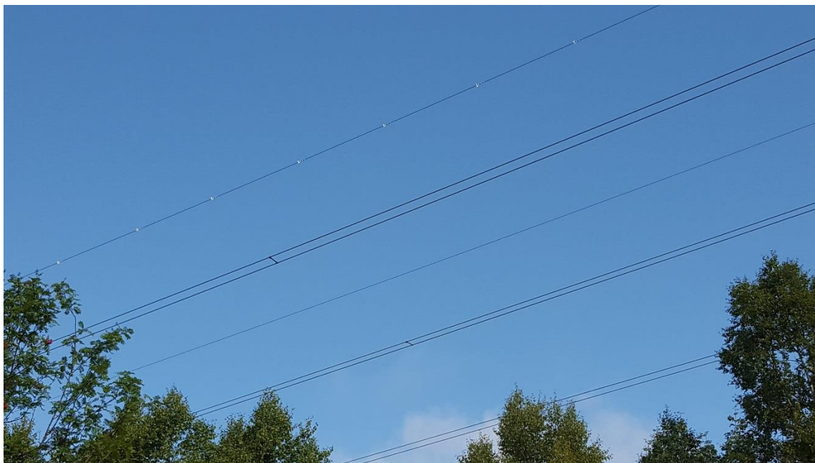
Figur 3. Parti av 420kV-linje (Oselva) hvor topplina er merket med grå grisehaler. Foto: Bård G. Stokke ©.
