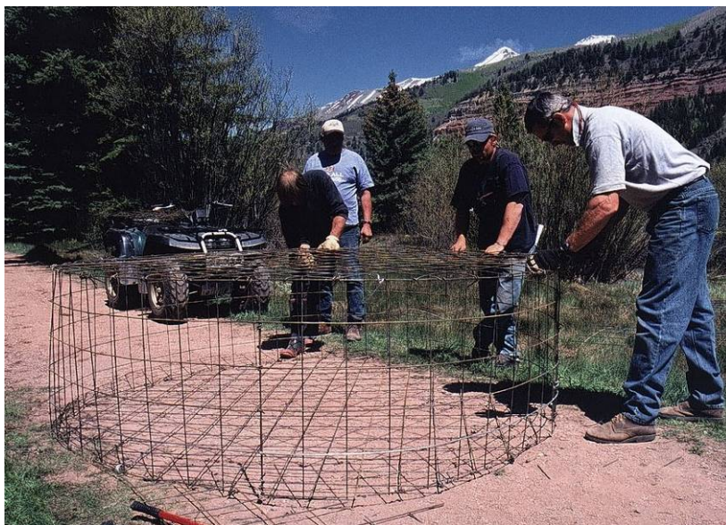
Figur 13.3. Filterbygging. Foto: S. Lisle
