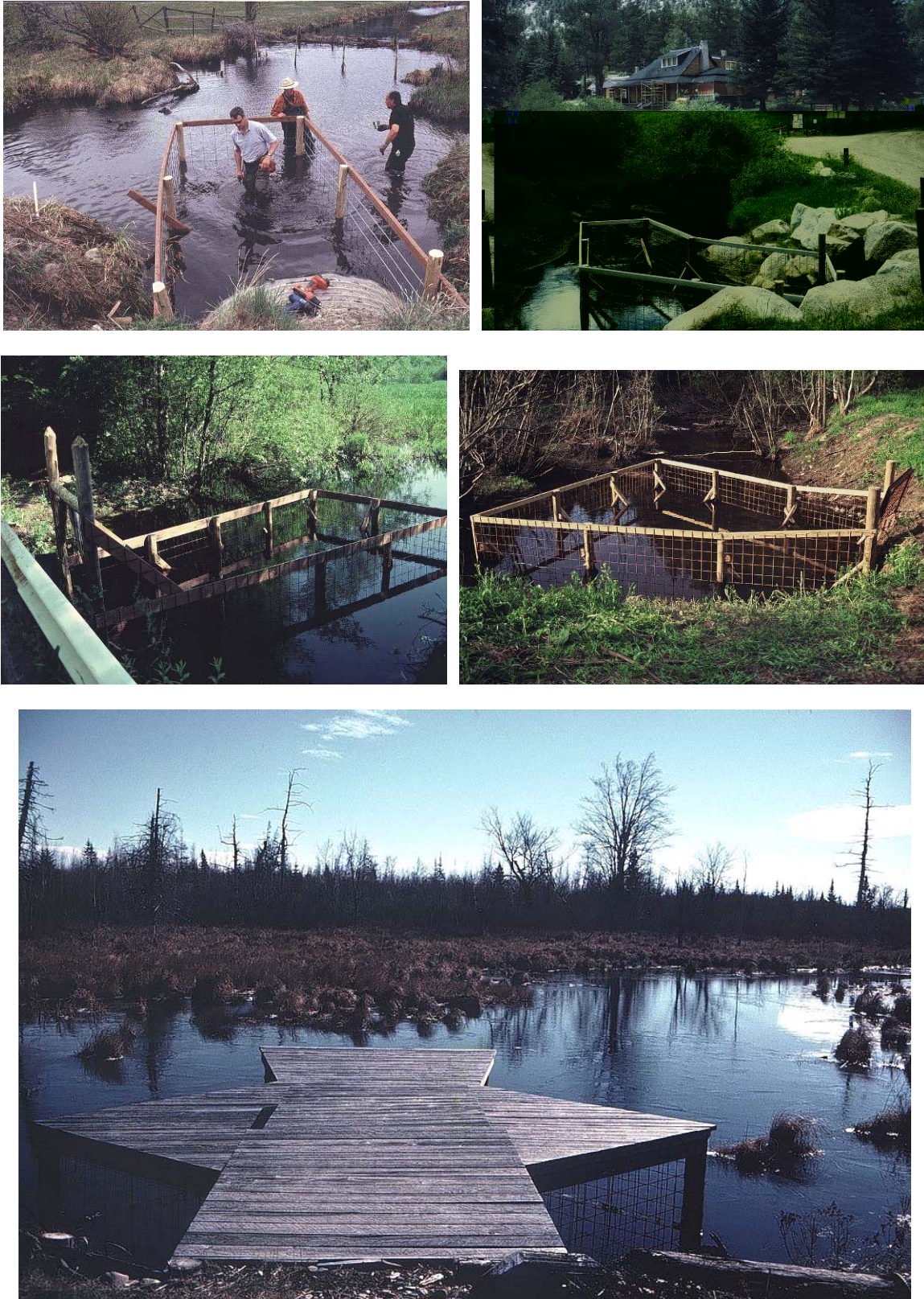
Figur 11.6 Ulike for-dammer. Merk robust konstruksjon (noe som utvilsomt lønner seg) samt tilpasning av formen til formen på bekken. Det siste bildet viser en konstruksjon (som ligger i et naturreservat) utstyrt med plattform som å gjør den mer attraktiv, samtidig som den kan tjene som utsiktspunkt for besøkende. Foto: S Lisle / S. Tippie
