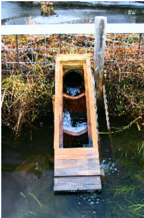
Figur 12.1 Fisketrapp i beverdemning plassert mot for-dam (se kapittel om for-dam) Foto: S. Lisle
