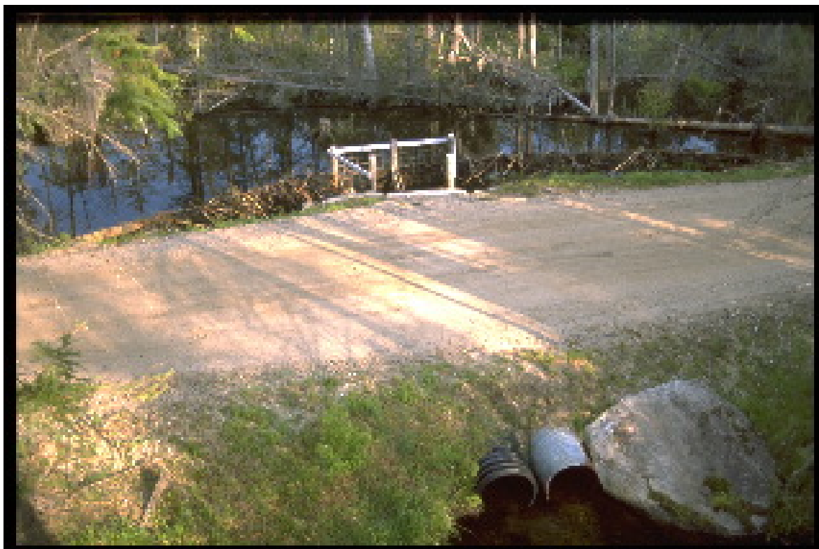
Figur 11.1 Enkel for-dam med beverdemning bygget utenpå.
