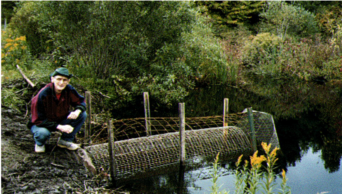
Figur 10.1 Dobbelt beverforvirrer. Foto: BWW
