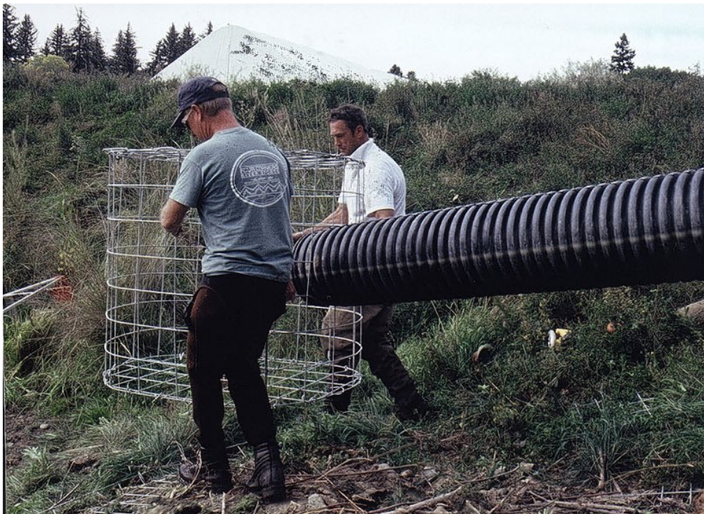
Figur 13.8 Bygging av kombinert for-dam og nettingsylinderfilter. B) Filter og rør fraktes til byggeplassen. Foto: S. Lisle
