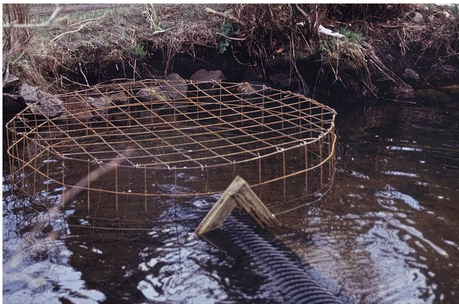
Figur 13.5 Rørmontering. Foto: S. Lisle
