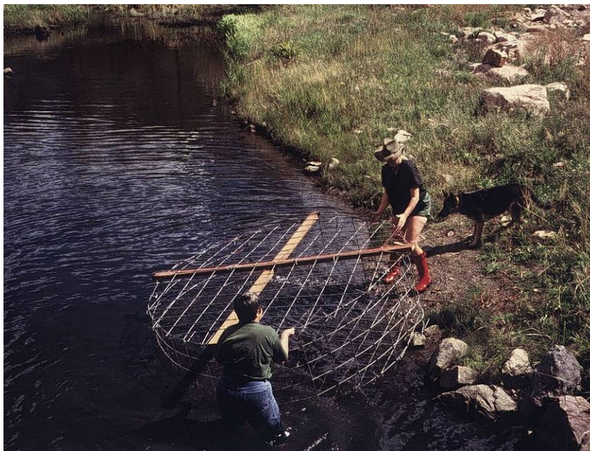
Figur 13.4 Filteret settes på plass. Foto: S. Lisle
