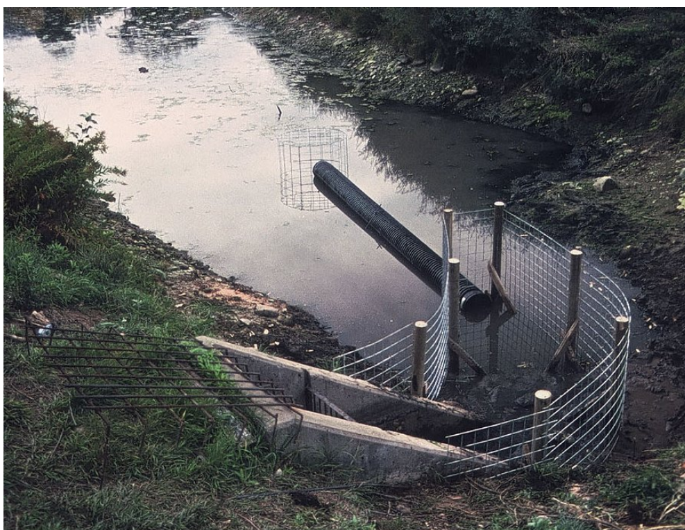
Figur 13.10 Bygging av kombinert for-dam og nettingsylinderfilter. D) Ferdigbygd installasjonen. Foto: S. Lisle
