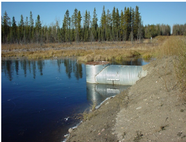
Figur 10.6 Ferdigbygd beverforvirrer av rustfritt stål. Foto: T&C Enterprises
