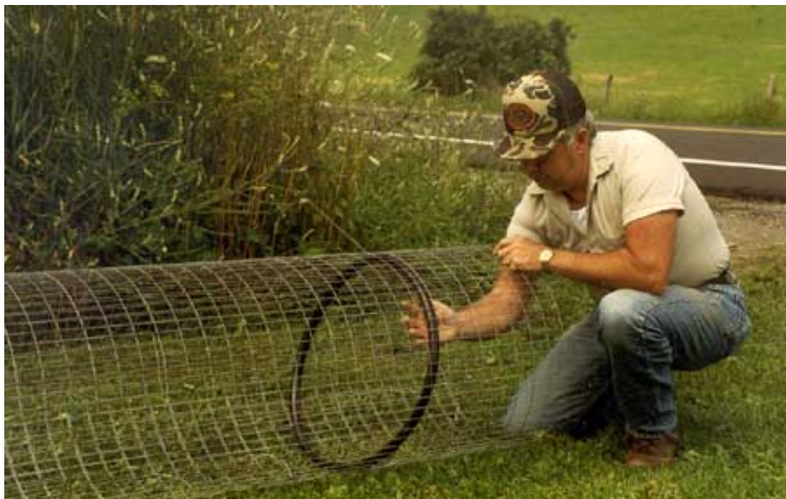
Figur 10.2 Montering av stålring som tilleggstøtte. Foto: BWW
