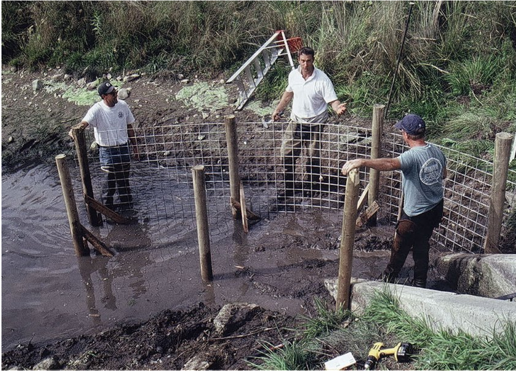
Figur 13.7 Bygging av kombinert for-dam og nettingsylinderfilter. A) For-dam bygges
