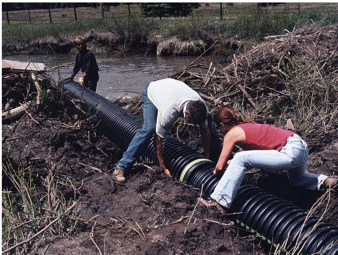
Figur 13.6 Rørmontering i en beverdemning. Et hull graves ut på ønskede vannivået og røret legges inn. Bevrene skal reparere demningen etterpå. Foto: S. Lisle
