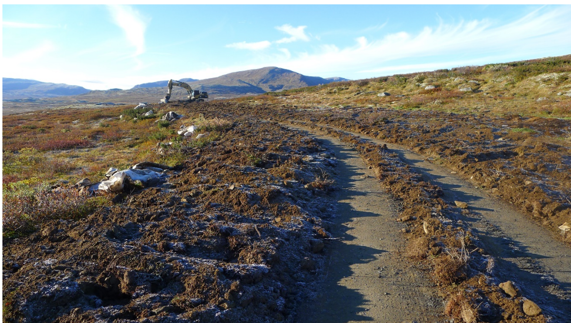
Figur 3. Mellomlagra masser lagt oppå det nye bærelaget etter avsluttet anleggsfase.
