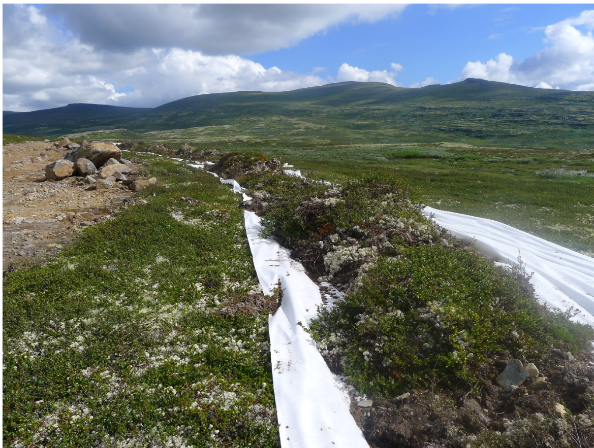
Figur 2. Mellomlagring av vegetasjon og toppmasser på duk i anleggsfasen.
