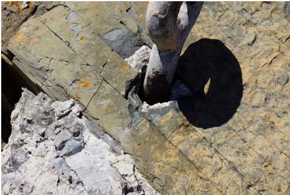
Figur 21. Bolt satt ned nær gangbrua i sone 6. Ved uheldig plassering kan slike inngrep gjøre stor skade og bør unngås så sant det er mulig.
