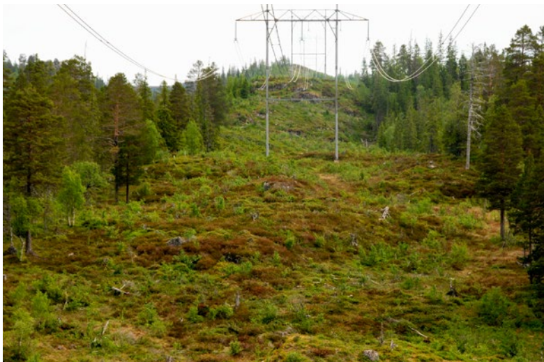
Ryddebelstet under høyspentledningen i Bangdalen ble selektivt ryddet. Der bildet er tatt ble gran og or fjernet mens beitetrær ble kuttet på 1 meter dersom de var over 1 meter høye. Foto Sigbjørn Stokke
