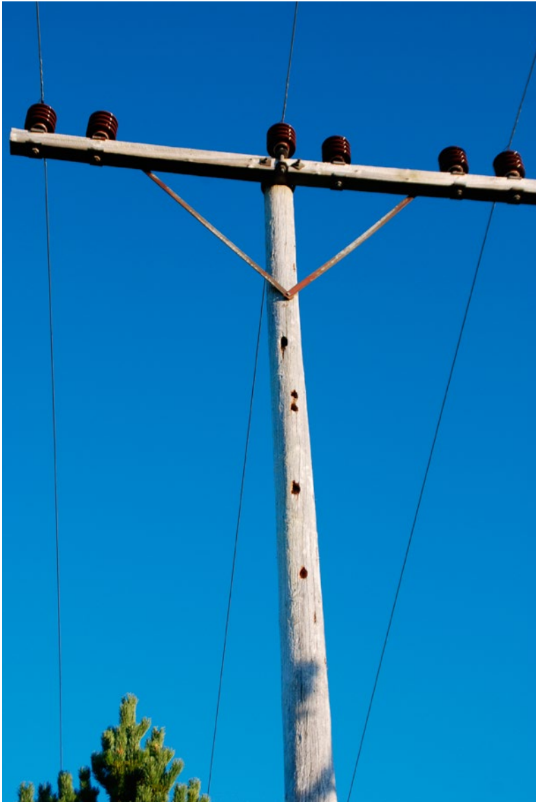
Hakkespetter kan gjøre betydelig skade på kraftledningsstolper. Årsaken til at fuglene går løs på bestemte stolper er fremdeles ikke fullt ut forstått. Foto: Arne Follestad
