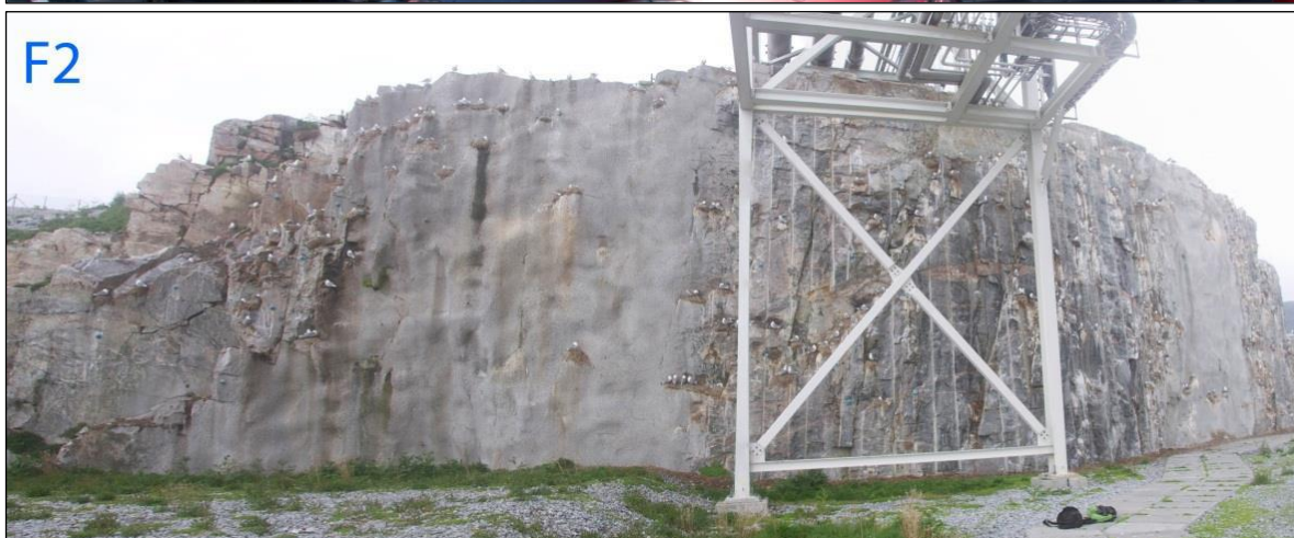
Figur 11. Partier av fjellskjæringer på Melkøya der deler av veggen er sprayet med betong som gjør den glattere, noe som begrenser hekkemulighetene. Foto: Geir Systad ©
