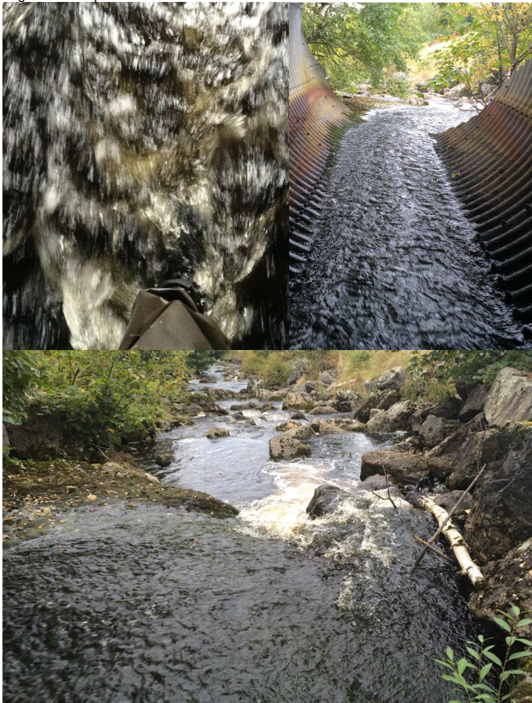
Figur 44. Passeringsmuligheter for laks og sjørret ved veikulvert under Fv 710 ved middels vannføring. Foto fra innside (øverst) og utgangen til kulverten (nederst) nedenfor Fv 710. Høy vannhastighet, lav vanddybde og murt betong i bunn.
