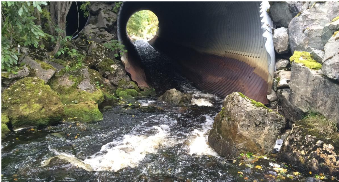
Figur 45. Passeringsmuligheter for laks og sjørret ved veikulvert under Fv 710. Foto fra inngangen til kulverten ovenfor Fv 710.
